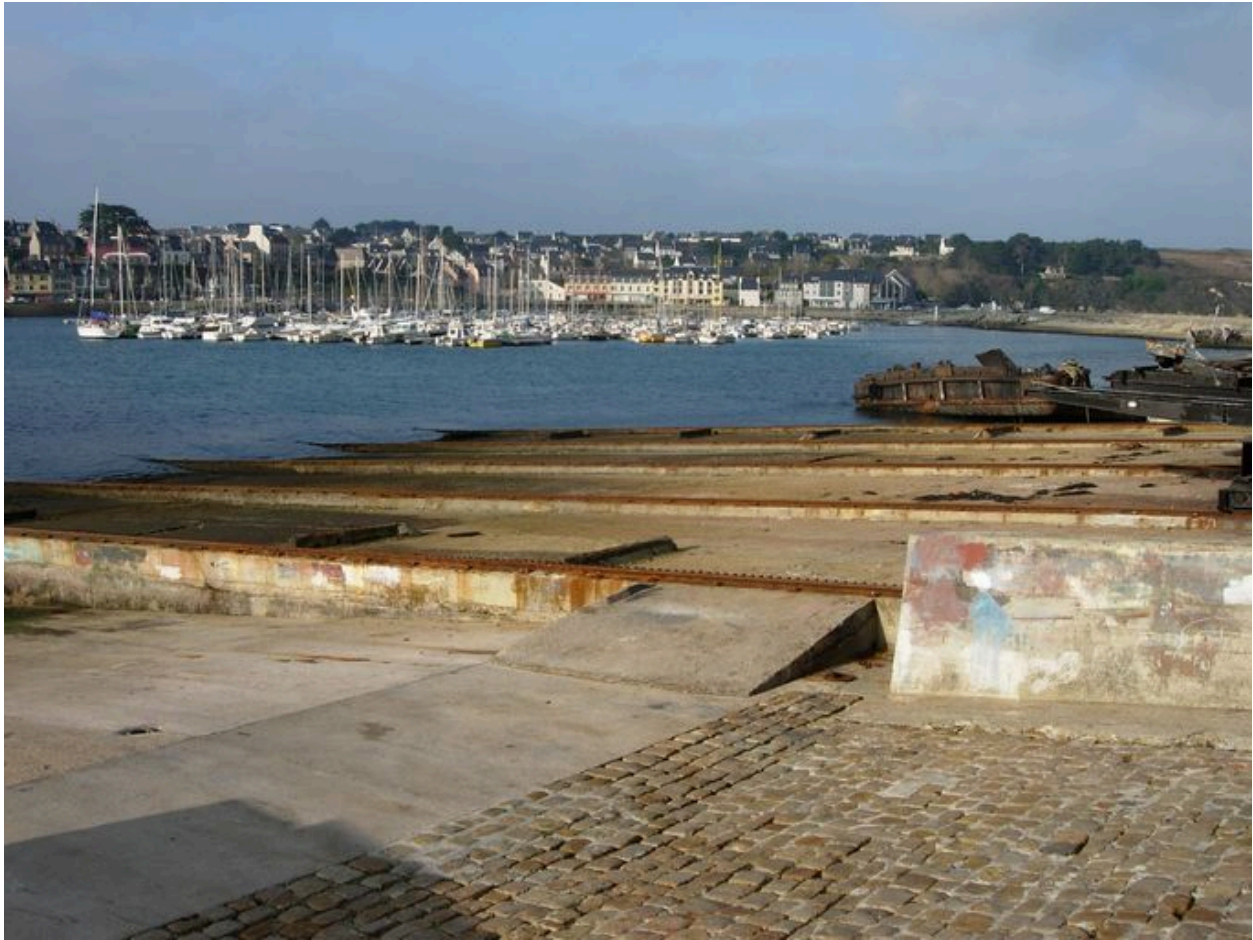
Rails du slipway
