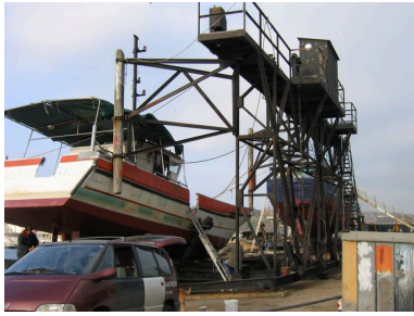
Partie haute du slipway avec treuil à bateau Phot. Françoise Péron IVR53_20062908440NUCA
