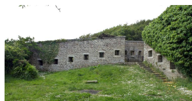
Plouzané : vue du fort du Dellec Phot. Bernard Bègne IVR53_20122901574NUCA
