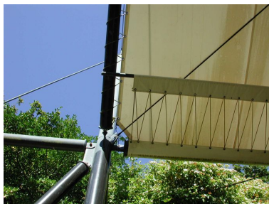
Vue du fort du Dellec : structure légère et toile assurant l'étanchéité de l'espace de la caserne aujourd'hui réhabilité Phot. Guillaume Lécueillier IVR53_20052903401NUCA
