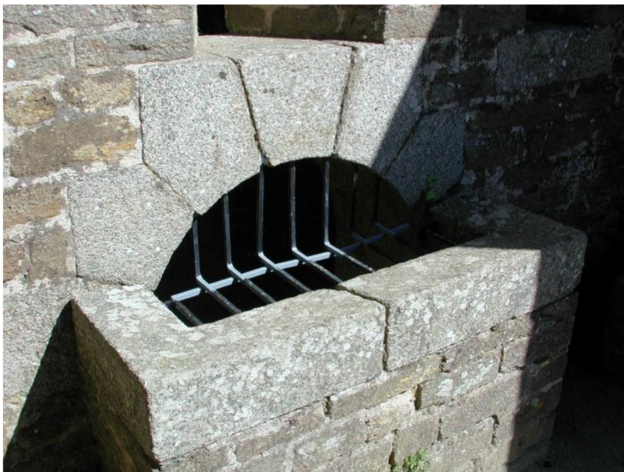
Vue du fort du Dellec : mâchicoulis ou créneaux de pied
