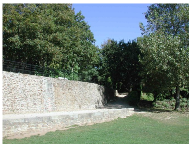
Vue du fort du Dellec : rampe inclinée de la batterie Phot. Guillaume Lécueillier IVR53_20052903425NUCA
