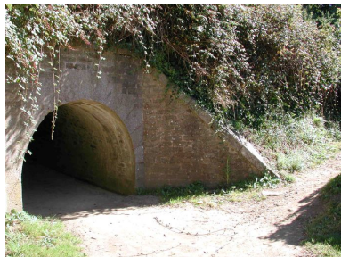
Vue du fort du Dellec : passage couvert menant de la deuxième batterie Phot. Guillaume Lécueillier IVR53_20052903466NUCA
