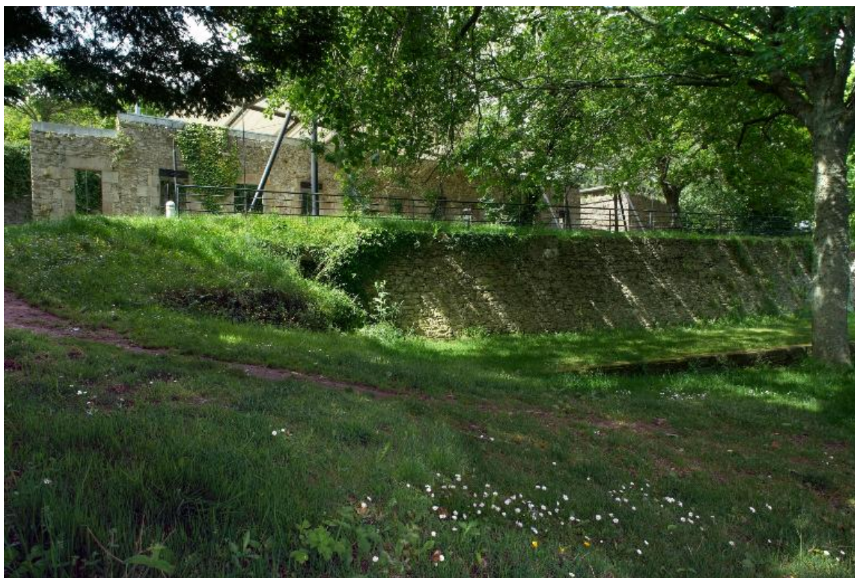
Plouzané : vue du fort du Dellec
