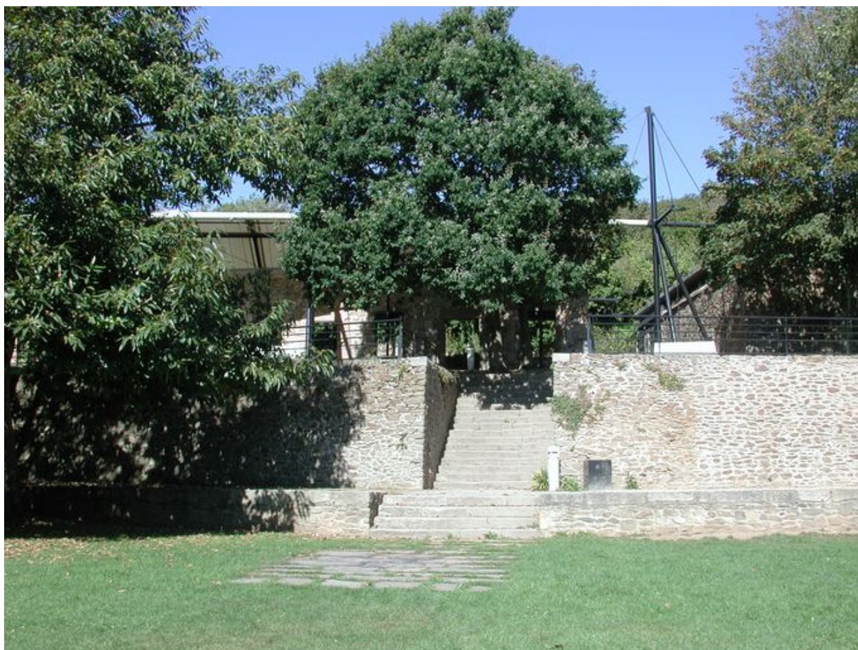
Vue du fort du Dellec : rampe inclinée, plate-forme et escalier de la batterie
