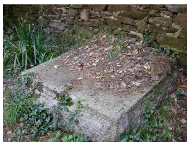
Vue du fort du Dellec : dé et boulons de sellette Phot. Guillaume Lécueillier IVR53_20052903433NUCA
