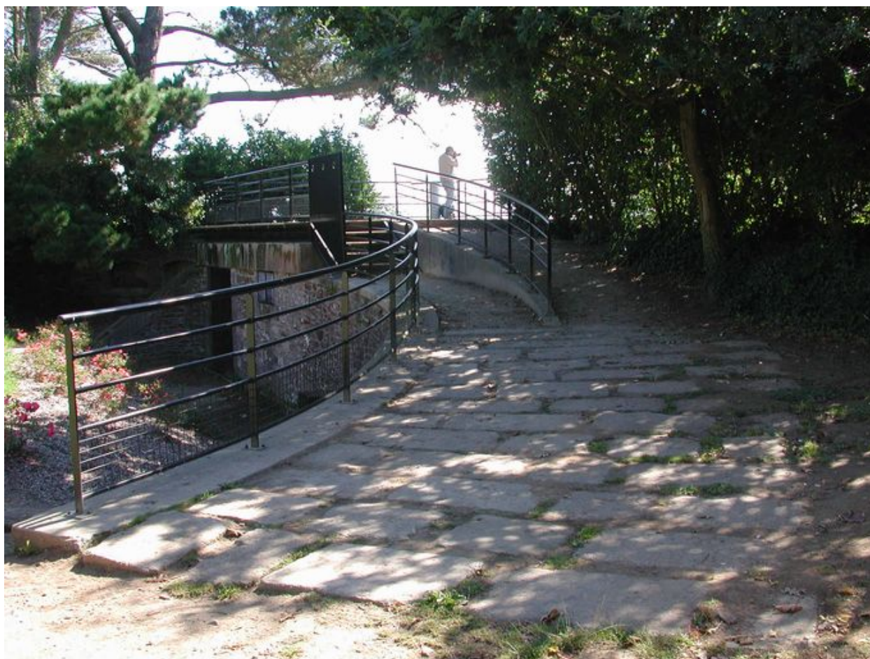
Vue du fort du Dellec : détail du pavage de la rampe surmontant le poste de projecteur
