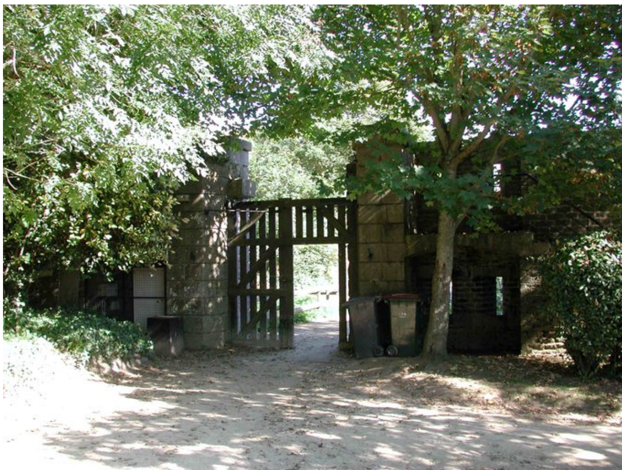
Vue du fort du Dellec : entrée monumentale vue depuis l'intérieur
