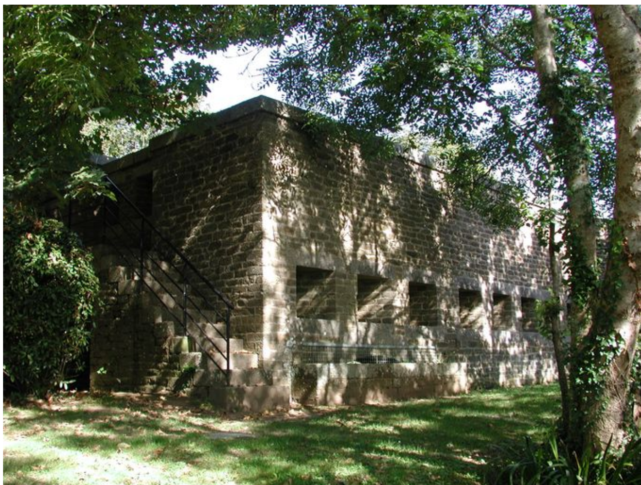
Vue du fort du Dellec : mur d'enceinte percé de créneaux de fusillade
