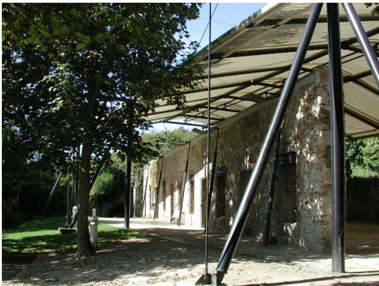
Vue du fort du Dellec : exemple de réhabilitation d'une caserne
