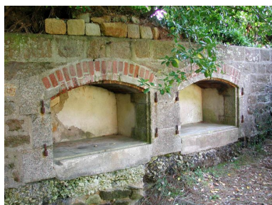
Vue du fort du Dellec : niches à munitions de la batterie de 4 canons Marine à tir modèle 1885 sur affûts M modèle 1885 crinoline Phot. Guillaume Lécueillier IVR53_20052903436NUCA
