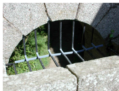
Vue du fort du Dellec : mâchicoulis ou créneaux de pied Phot. Guillaume Lécueillier IVR53_20052903477NUCA
