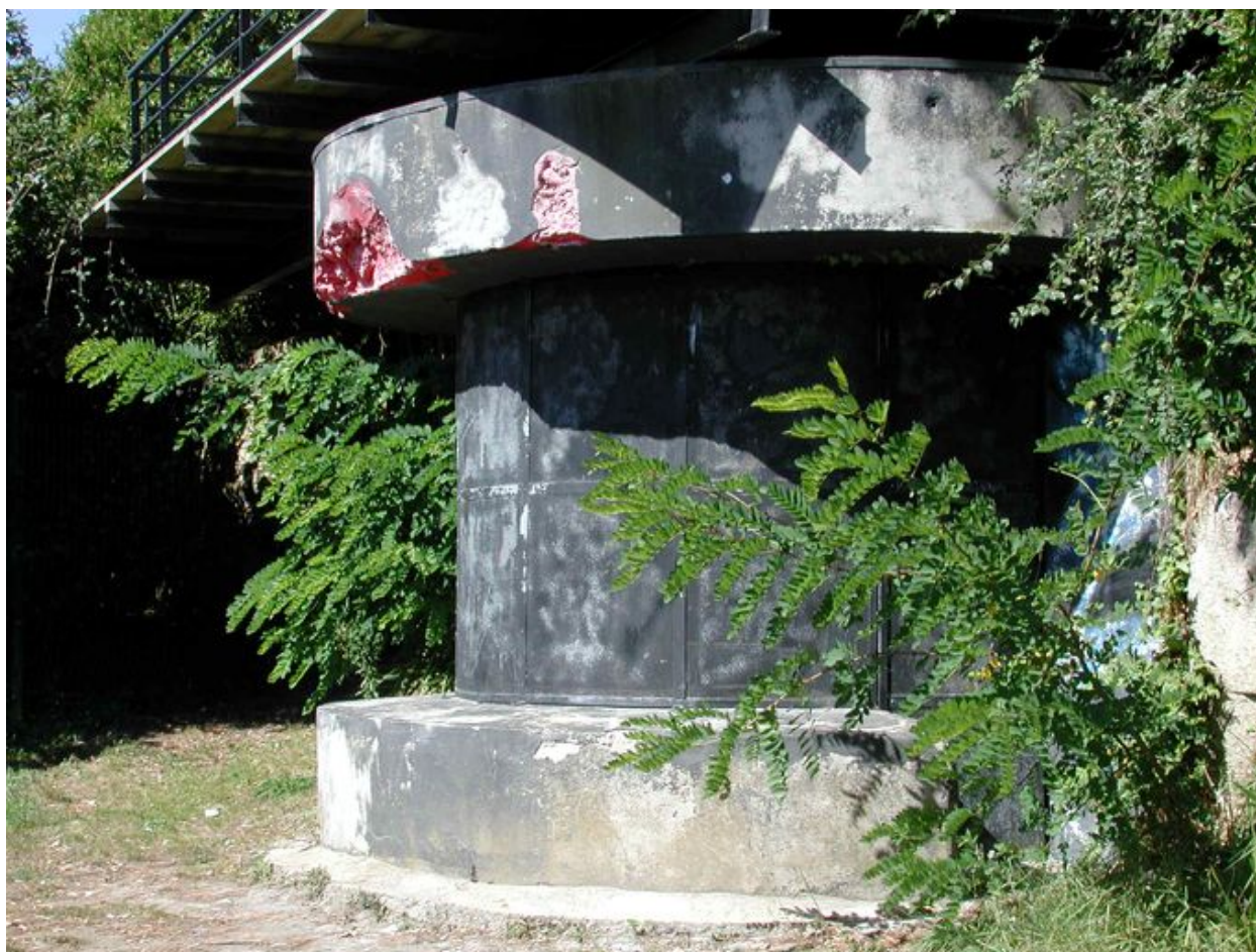
Vue du fort du Dellec : abri de jour et de combat du projecteur (casemate française en béton armé)
