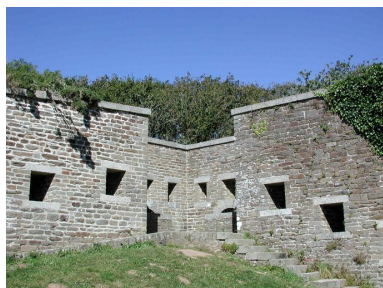
Vue du fort du Dellec : mur d'enceinte ouest percé de créneaux de fusillade. Bastionnet à mâchicoulis ou créneaux de pied Phot. Guillaume Lécueillier IVR53_20052903469NUCA
