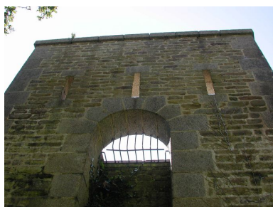
Vue du fort du Dellec : bastionnet percé de créneaux de fusillade et doté de mâchicoulis ou créneaux de pied Phot. Guillaume Lécueillier IVR53_20052903493NUCA
