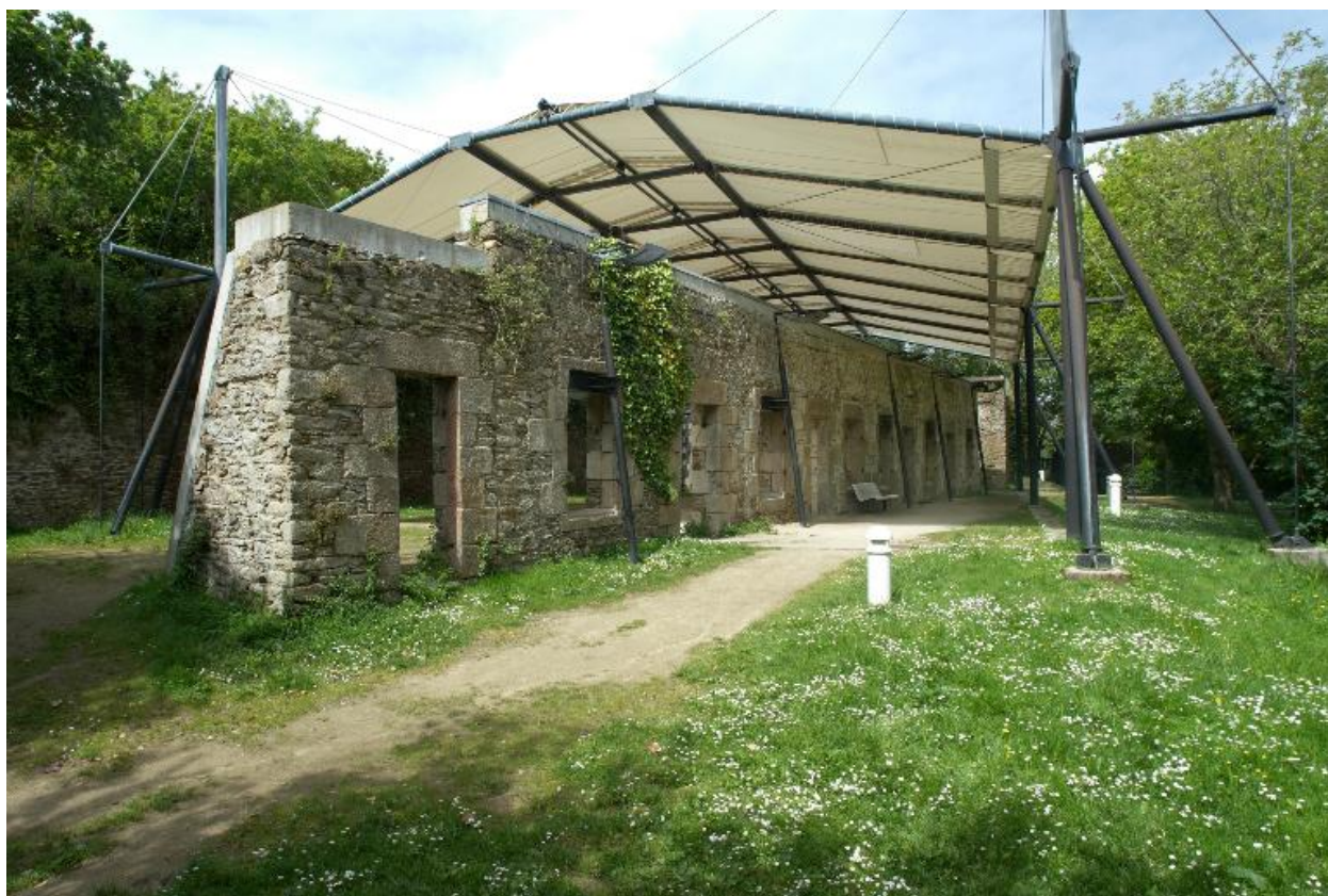
Plouzané : vue du fort du Dellec
