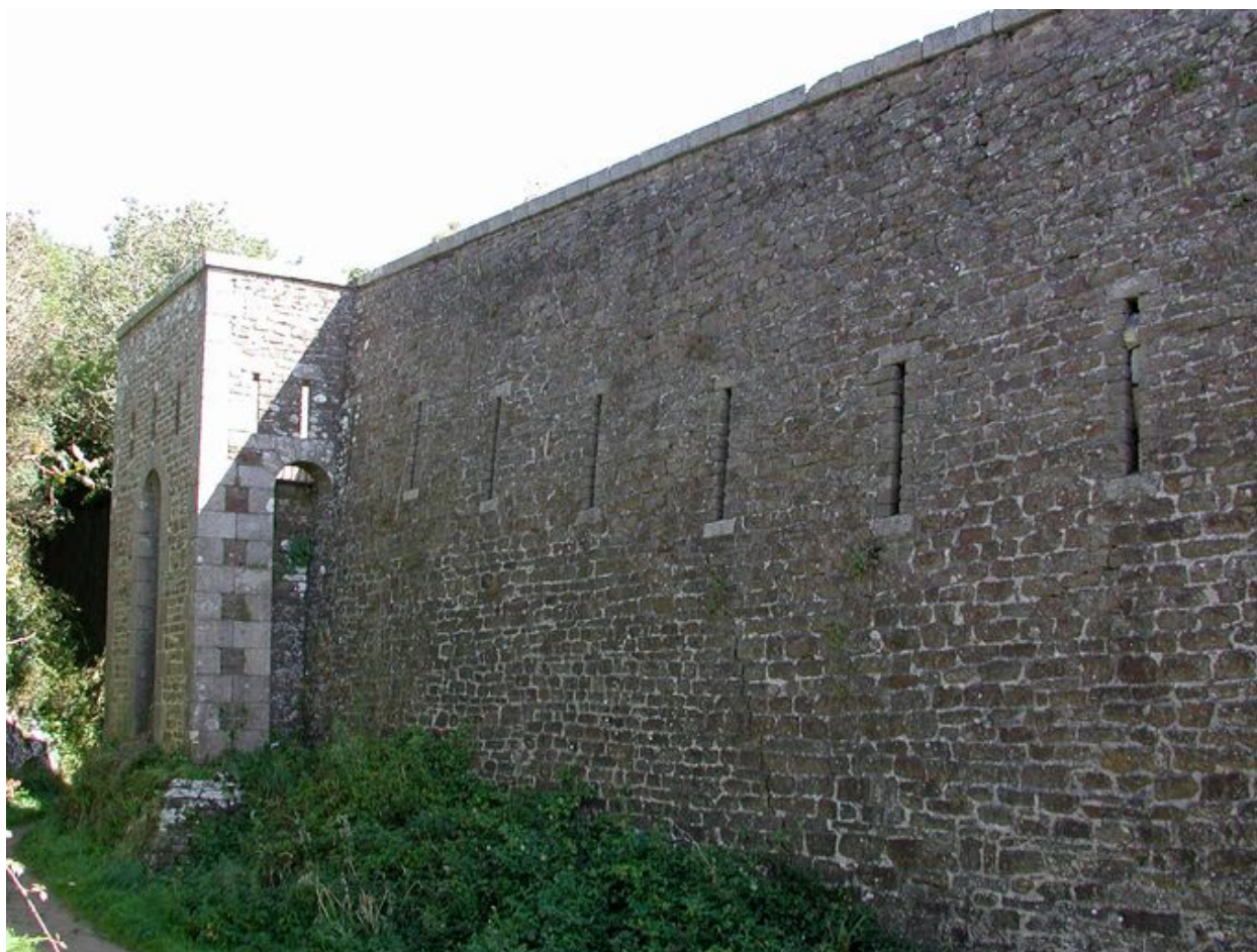
Vue du fort du Dellec : fossé sec flanqué par un bastionnet percé de créneaux de fusillade et doté de mâchicoulis ou créneaux de pied
