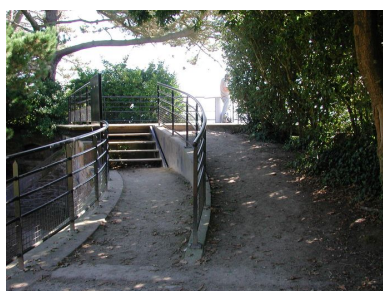
Vue du fort du Dellec : exemple de double accès : adapté aux personnes à mobilité réduite (rampe inclinée) et aux personnes valides (escalier) Phot. Guillaume Lécueillier IVR53_20052903445NUCA
