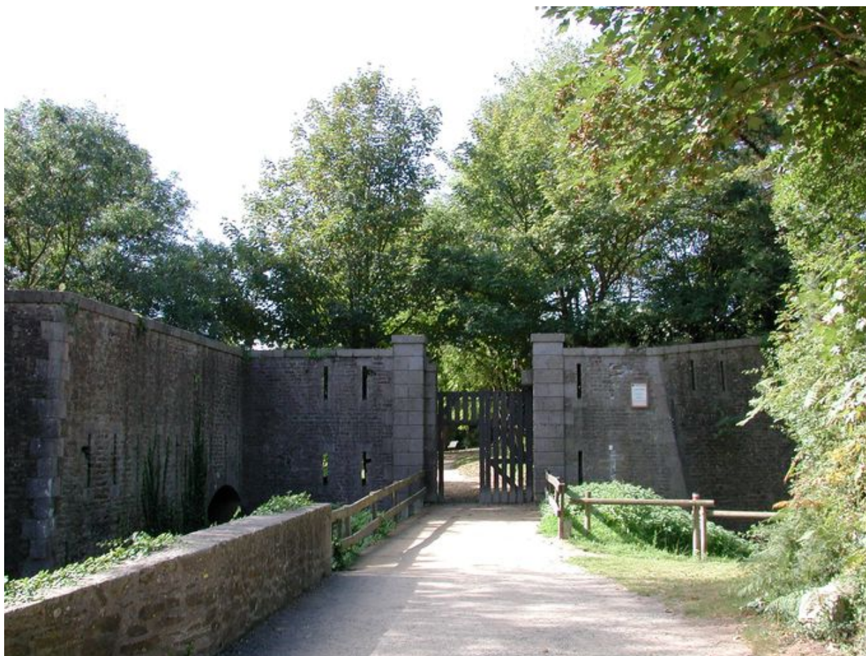
Vue du fort du Dellec : entrée monumentale et enceinte percée de créneaux de fusillade
