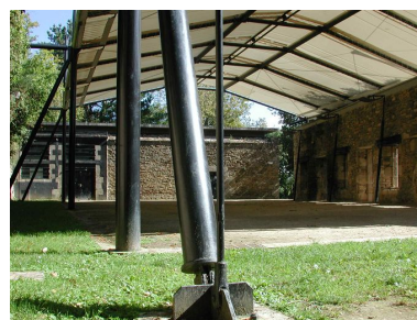
Vue du fort du Dellec : structure légère et toile assurant l'étanchéité de l'espace de la caserne aujourd'hui réhabilité Phot. Guillaume Lécueillier IVR53_20052903411NUCA
