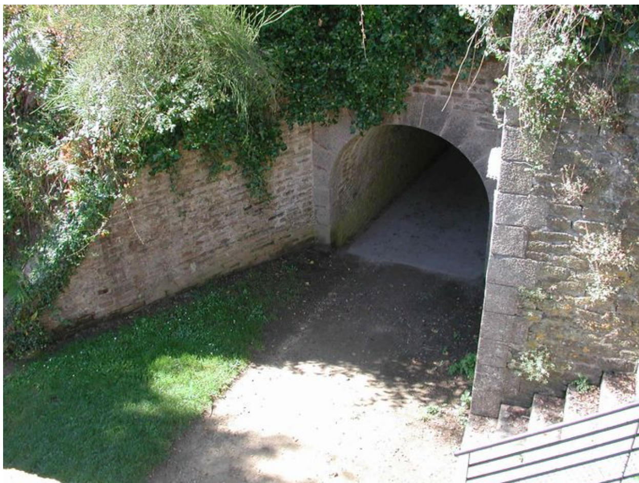
Vue du fort du Dellec : passage couvert menant à la deuxième batterie
