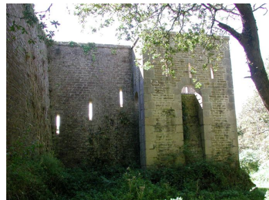
Vue du fort du Dellec : fossé sec flanqué par un bastionnet percé de créneaux de fusillade et doté d'un mâchicoulis ou créneau de pied Phot. Guillaume Lécueillier IVR53_20052903492NUCA
