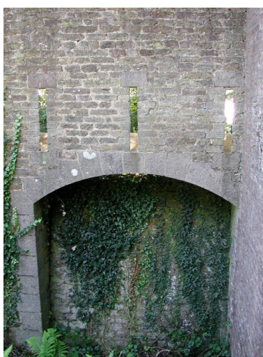
Vue du fort du Dellec : mur d'enceinte est. Mâchicoulis sur arc défendant le fossé sec sous le pont-levis Phot. Guillaume Lécueillier IVR53_20052903380NUCA
