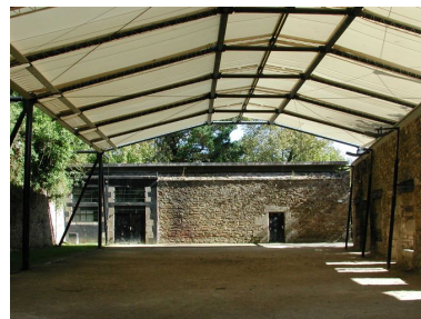
Vue du fort du Dellec : structure légère et toile assurant l'étanchéité de l'espace de la caserne aujourd'hui réhabilité Phot. Guillaume Lécueillier IVR53_20052903402NUCA
