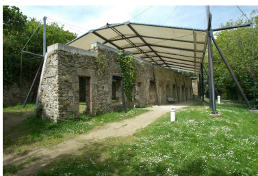
Plouzané : vue du fort du Dellec Phot. Bernard Bègne IVR53_20122901570NUCA
