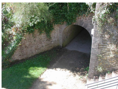
Vue du fort du Dellec : passage couvert menant à la deuxième batterie Phot. Guillaume Lécueillier IVR53_20052903416NUCA
