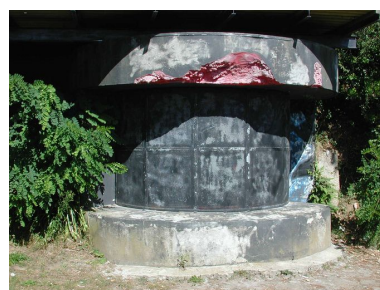
Vue du fort du Dellec : abri de jour et de combat du projecteur (casemate française en béton armé) Phot. Guillaume Lécueillier IVR53_20052903459NUCA
