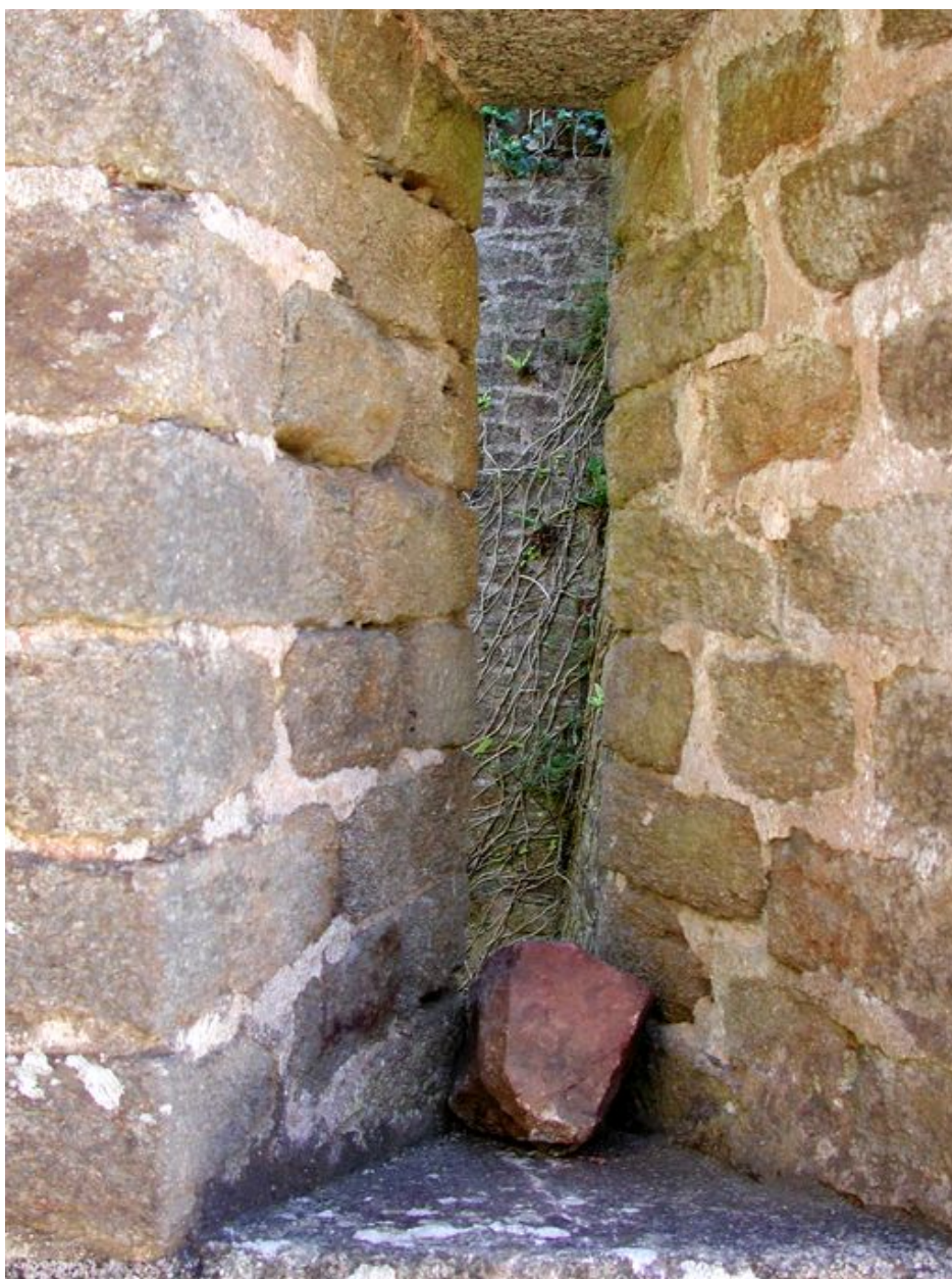
Vue du fort du Dellec : créneau de fusillade
