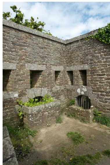
Plouzané : vue du fort du Dellec, mur d'enceinte ouest percé de créneaux de fusillade. Bastionnet à mâchicoulis ou créneaux de pied Phot. Bernard Bègne IVR53_20122901577NUCA
