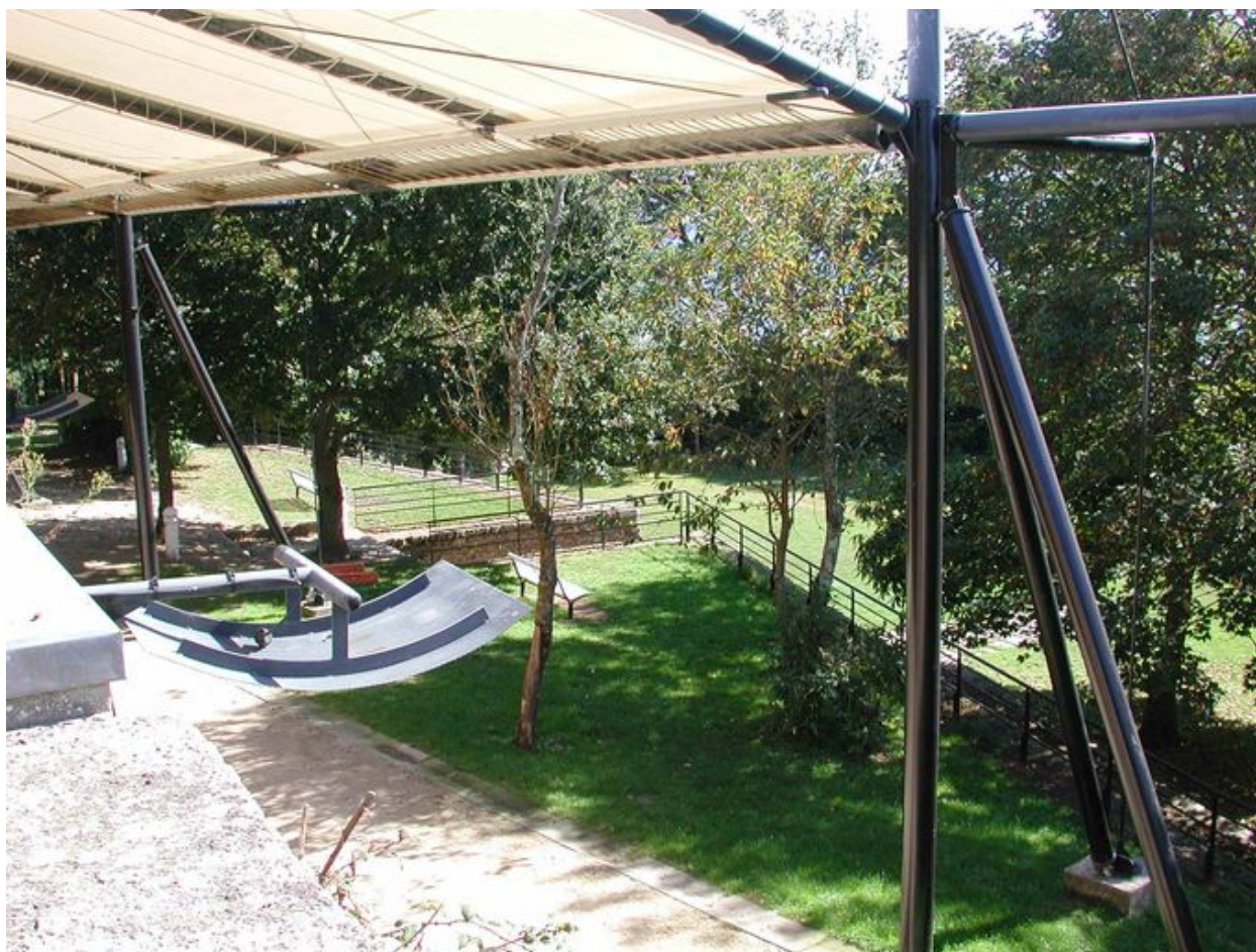
Vue du fort du Dellec : structure légère et toile assurant le couvert de l'espace de la caserne aujourd'hui réhabilité
