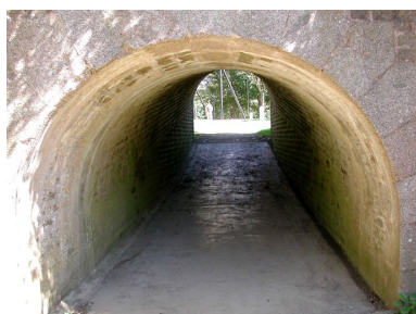
Vue du fort du Dellec : passage couvert menant de la deuxième batterie Phot. Guillaume Lécueillier IVR53_20052903481NUCA
