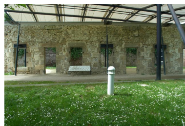
Plouzané : vue du fort du Dellec Phot. Bernard Bègne IVR53_20122901571NUCA
