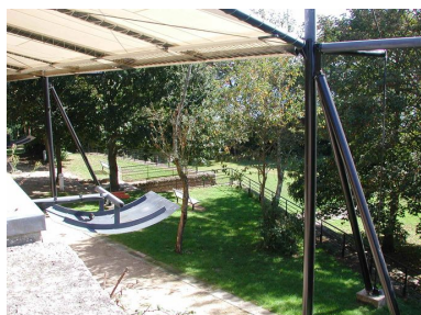
Vue du fort du Dellec : structure légère et toile assurant le couvert de l'espace de la caserne aujourd'hui réhabilité Phot. Guillaume Lécueillier IVR53_20052903415NUCA
