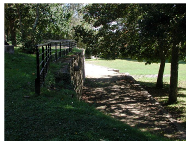
Vue du fort du Dellec : rampe inclinée, plate-forme et escalier de la batterie
