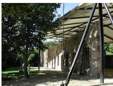
Vue du fort du Dellec : exemple de réhabilitation d'une caserne Phot. Guillaume Lécueillier IVR53_20022903031NUCA
