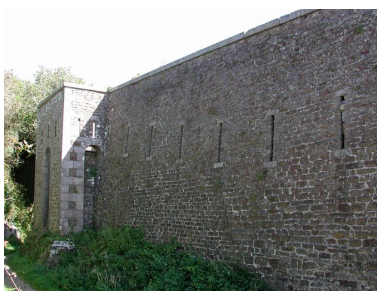
Vue du fort du Dellec : fossé sec flanqué par un bastionnet percé de créneaux de fusillade et doté de mâchicoulis ou créneaux de pied Phot. Guillaume Lécueillier IVR53_20052903494NUCA
