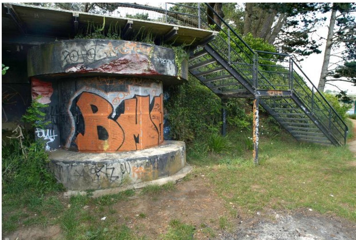
Plouzané : vue du fort du Dellec, abri de jour et de combat du projecteur (casemate française en béton armé)
