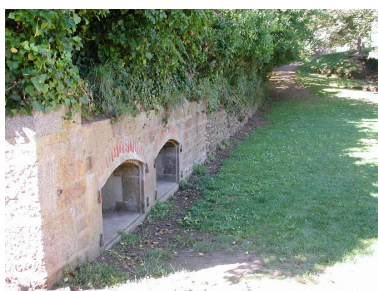
Vue du fort du Dellec : niches à munitions de la batterie de 4 canons Marine à tir modèle 1885 sur affûts M modèle 1885 crinoline Phot. Guillaume Lécueillier IVR53_20052903443NUCA
