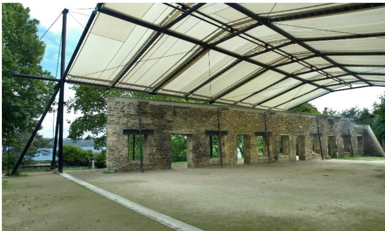
Plouzané : vue du fort du Dellec
