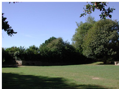
Vue du fort du Dellec : plate-forme de la batterie Phot. Guillaume Lécueillier IVR53_20052903427NUCA
