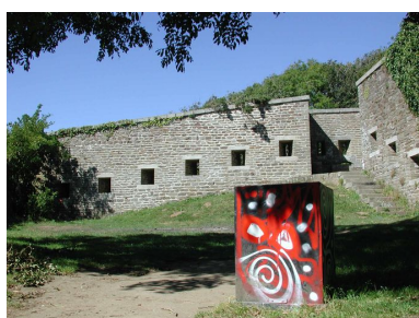
Vue du fort du Dellec : mur d'enceinte ouest percé de créneaux de fusillade. Bastionnet à mâchicoulis ou créneaux de pied Phot. Guillaume Lécueillier IVR53_20022903033NUCA
