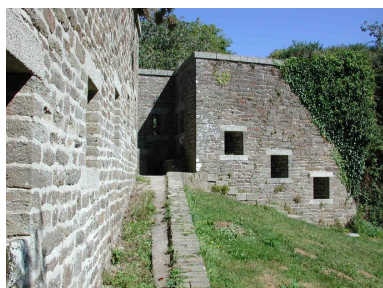
Vue du fort du Dellec : mur d'enceinte ouest percé de créneaux de fusillade. Bastionnet à mâchicoulis ou créneaux de pied Phot. Guillaume Lécueillier IVR53_20052903472NUCA
