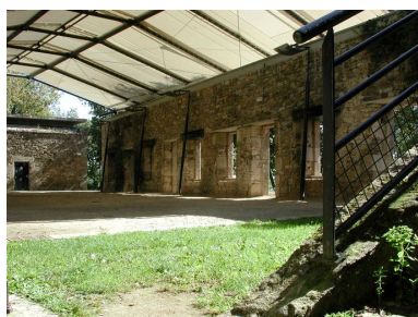
Vue du fort du Dellec : structure légère et toile assurant l'étanchéité de l'espace de la caserne aujourd'hui réhabilité Phot. Guillaume Lécueillier IVR53_20052903409NUCA
