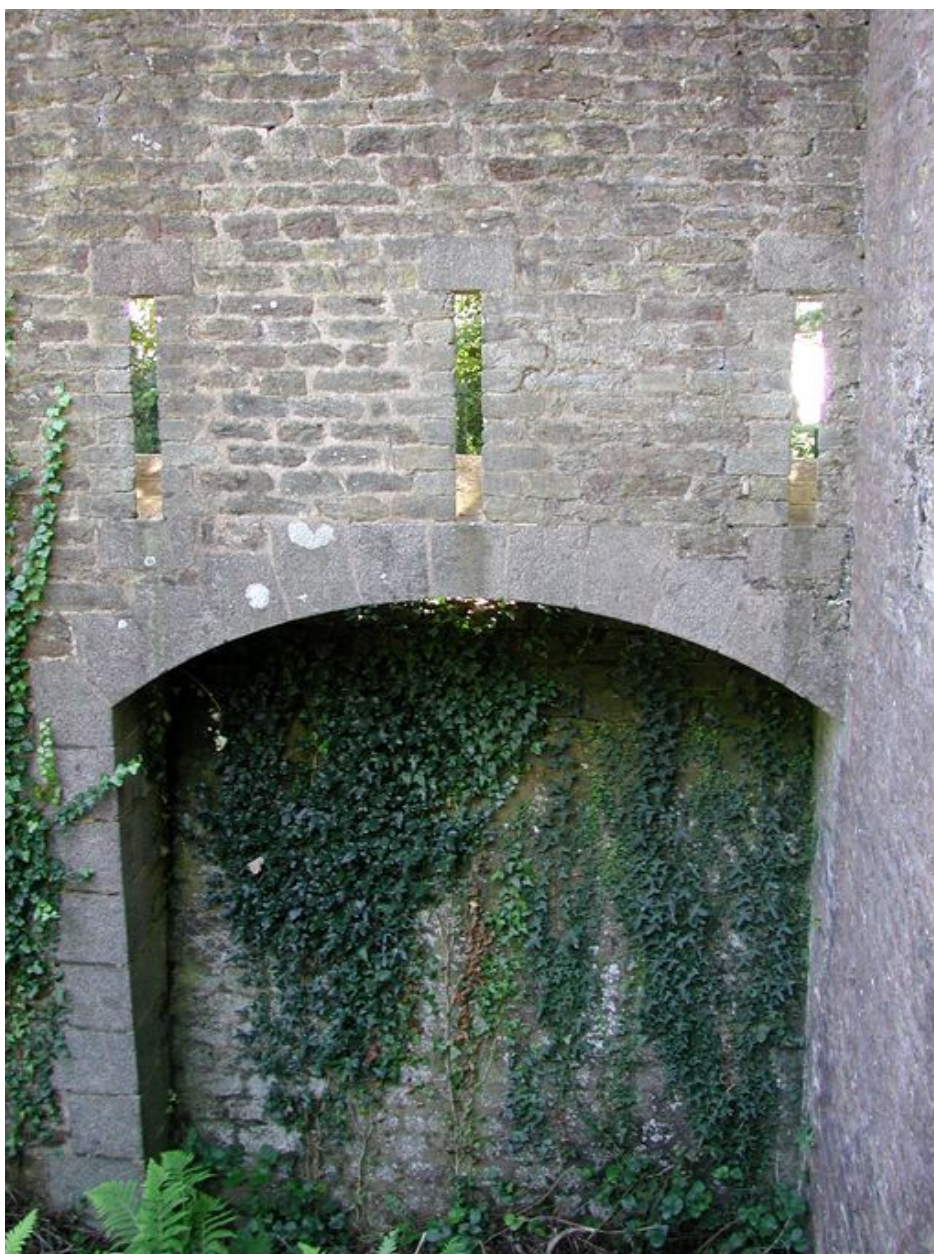
Vue du fort du Dellec : mur d'enceinte est. Mâchicoulis sur arc défendant le fossé sec sous le pont-levis
