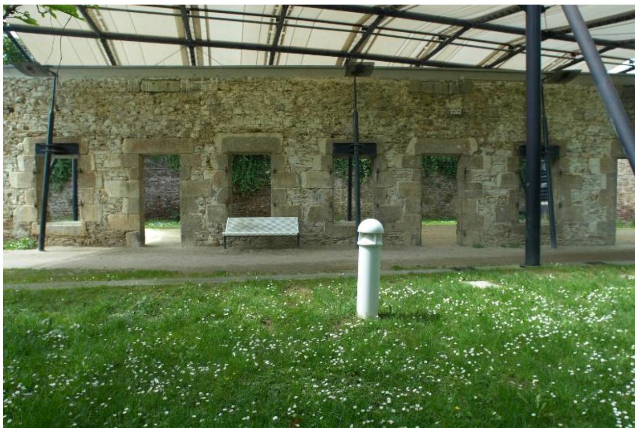
Plouzané : vue du fort du Dellec
