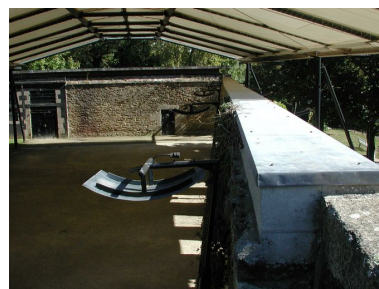
Vue du fort du Dellec : structure légère et toile assurant le couvert de l'espace de la caserne aujourd'hui réhabilité. Apperçu des travaux d'étanchéité des maçonnerie Phot. Guillaume Lécueillier IVR53_20052903414NUCA
