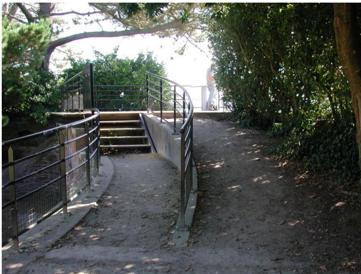
Vue du fort du Dellec : exemple de double accès : adapté aux personnes à mobilité réduite (rampe inclinée) et aux personnes valides (escalier)
