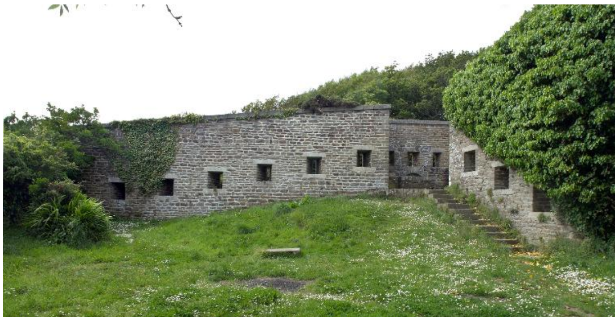
Plouzané : vue du fort du Dellec
