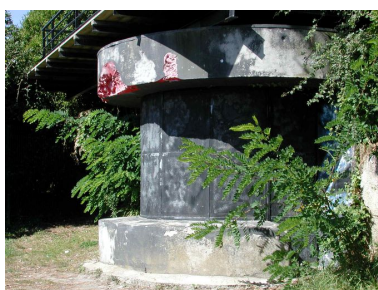
Vue du fort du Dellec : abri de jour et de combat du projecteur (casemate française en béton armé) Phot. Guillaume Lécueillier IVR53_20052903458NUCA
