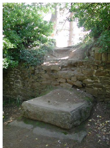
Vue du fort du Dellec : dé et boulons de sellette Phot. Guillaume Lécueillier IVR53_20052903435NUCA
