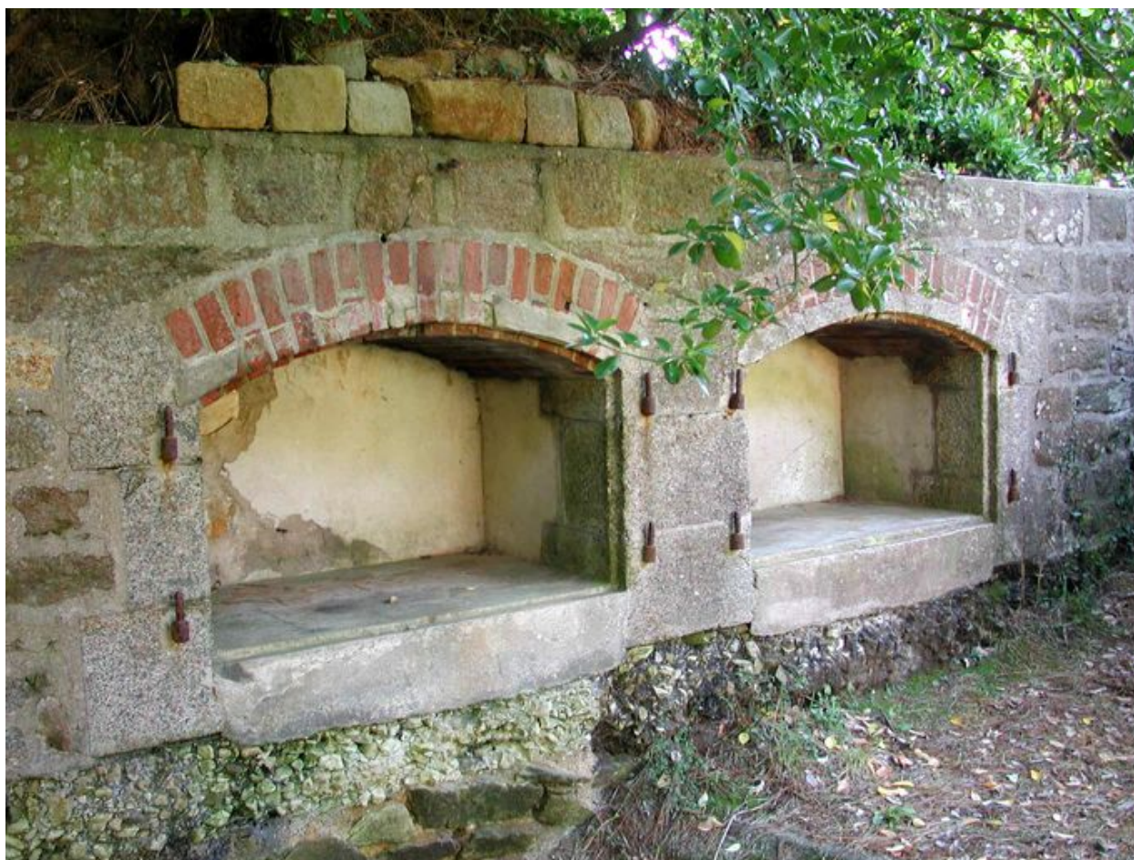
Vue du fort du Dellec : niches à munitions de la batterie de 4 canons Marine à tir modèle 1885 sur affûts M modèle 1885 crinoline
