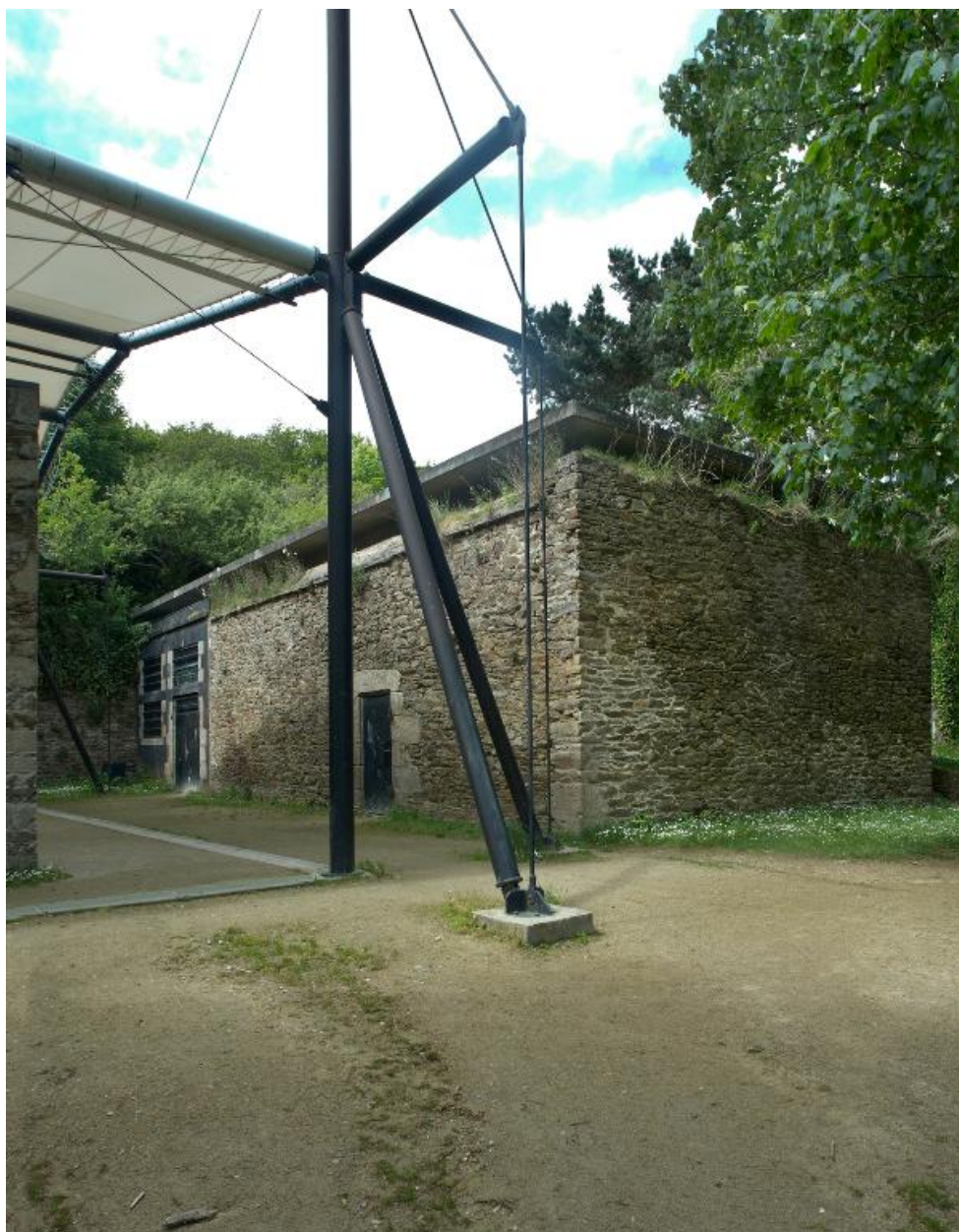
Plouzané : vue du fort du Dellec
