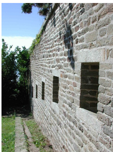
Vue du fort du Dellec : mur d'enceinte ouest percé de créneaux de fusillade Phot. Guillaume Lécueillier IVR53_20052903479NUCA
