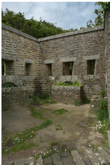
Plouzané : vue du fort du Dellec, mur d'enceinte ouest percé de créneaux de fusillade. Bastionnet à mâchicoulis ou créneaux de pied Phot. Bernard Bègne IVR53_20122901576NUCA
