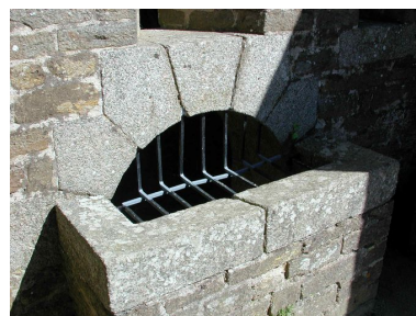
Vue du fort du Dellec : mâchicoulis ou créneaux de pied Phot. Guillaume Lécueillier IVR53_20052903474NUCA
