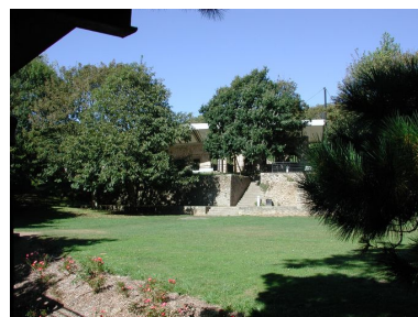
Vue du fort du Dellec : plate-forme de la batterie Phot. Guillaume Lécueillier IVR53_20052903438NUCA
