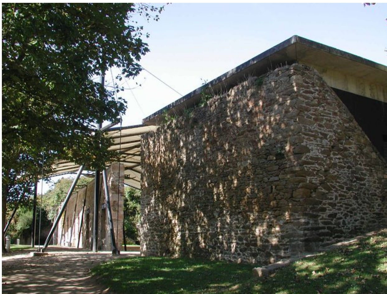
Vue du fort du Dellec : caserne
