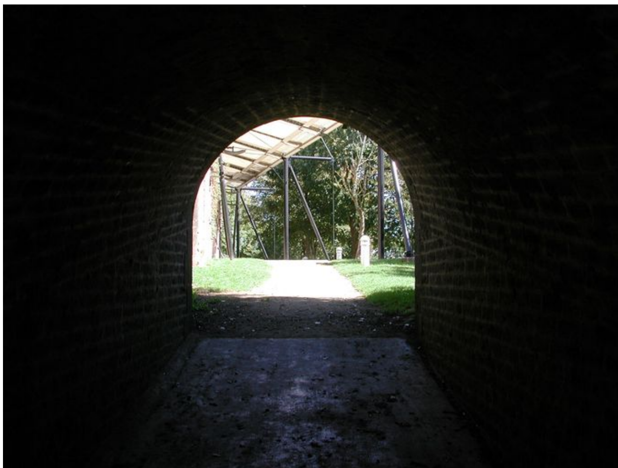
Vue du fort du Dellec : passage couvert menant de la deuxième batterie
