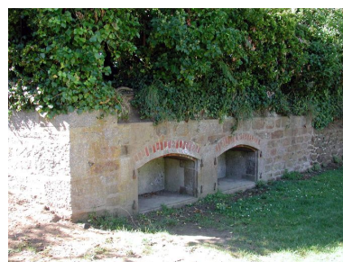
Vue du fort du Dellec : niches à munitions de la batterie de 4 canons Marine à tir modèle 1885 sur affûts M modèle 1885 crinoline Phot. Guillaume Lécueillier IVR53_20052903441NUCA
