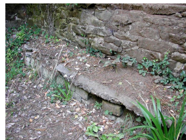
Vue du fort du Dellec : mur de genouillère de la batterie Phot. Guillaume Lécueillier IVR53_20052903432NUCA
