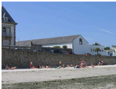
Conserverie Camus, actuellement école Notre-Dame-de-Larmor Phot. Françoise Péron IVR53_20075605621NUCA
