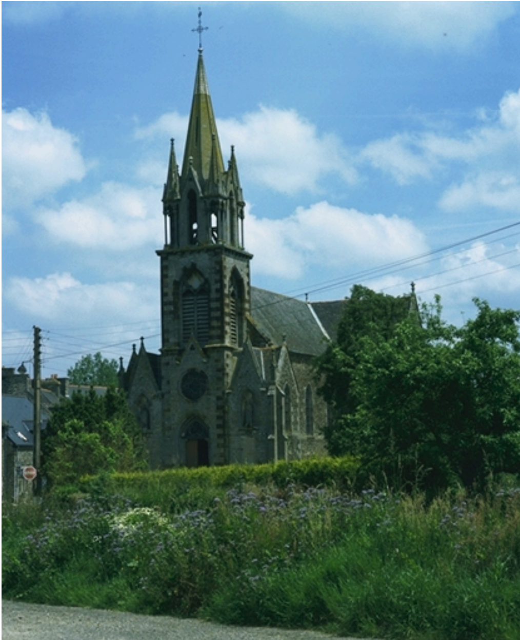
Vue de situation sud-ouest
