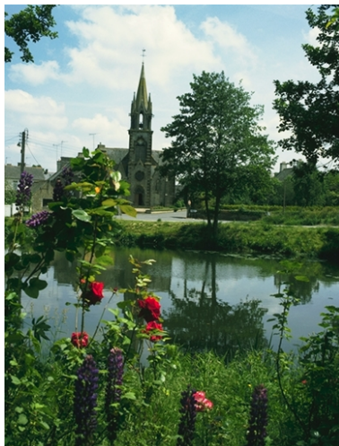
Vue de situation ouest Phot. Guy Artur, Phot. Norbert Lambart IVR53_19993500602XA
