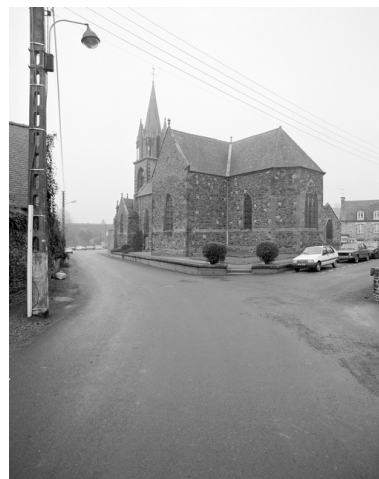
Vue générale sud-est Phot. Alain Boden IVR53_19943500006X
