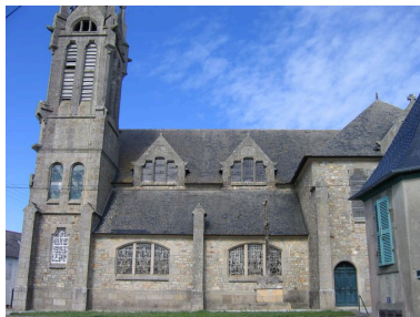
Elévation sud de la nef de l'église Saint-Rémi Phot. Guillaume Marie IVR53_20062908328NUCA
