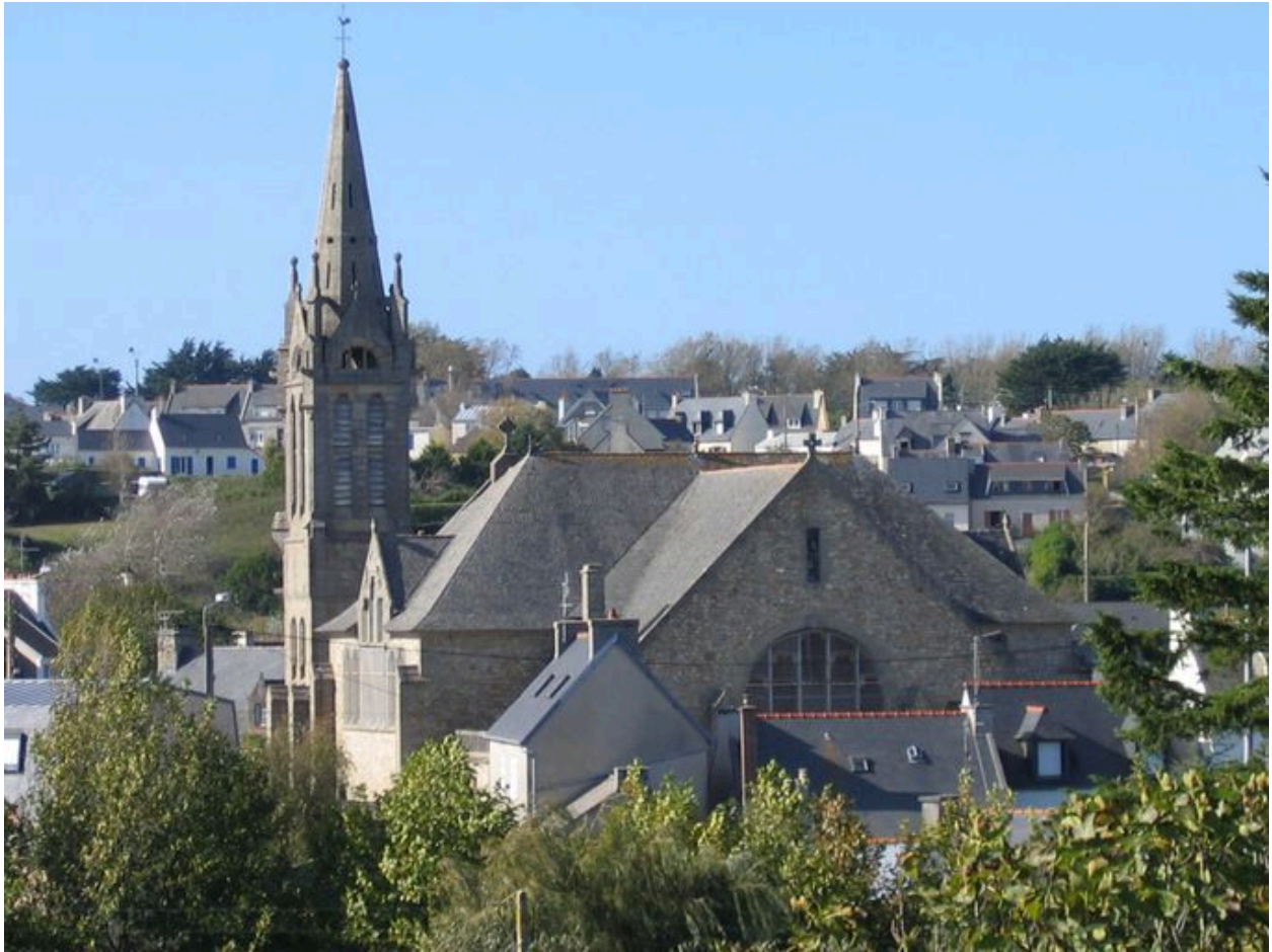
Vue générale de l'église Saint-Rémi depuis l'est
