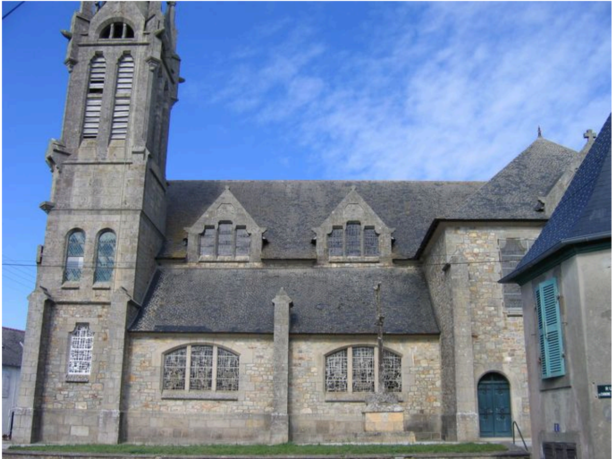
Elévation sud de la nef de l'église Saint-Rémi
