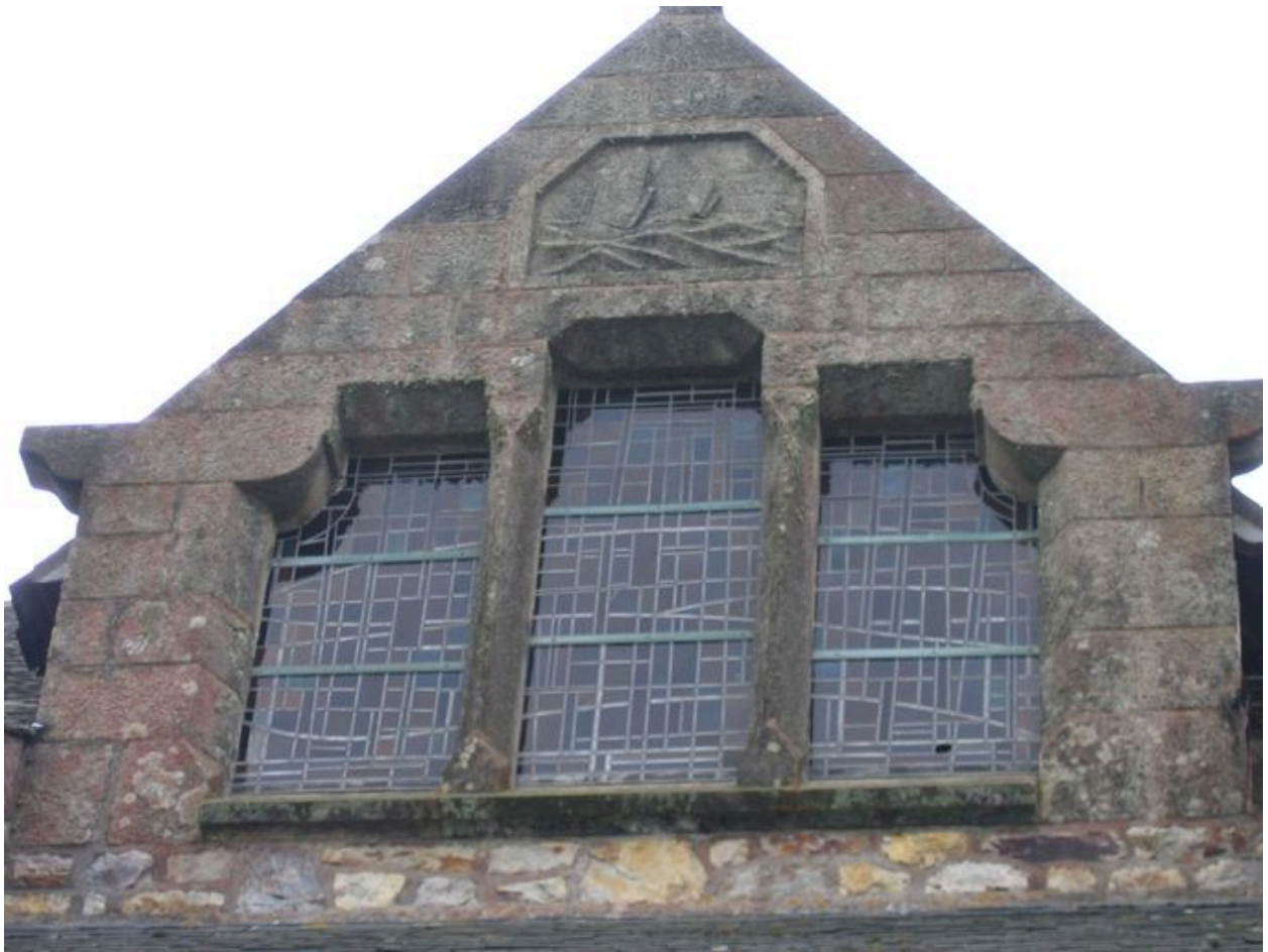
Elévation sud de l'église Saint-Rémi, détail d'une baie ; relief avec bateaux
