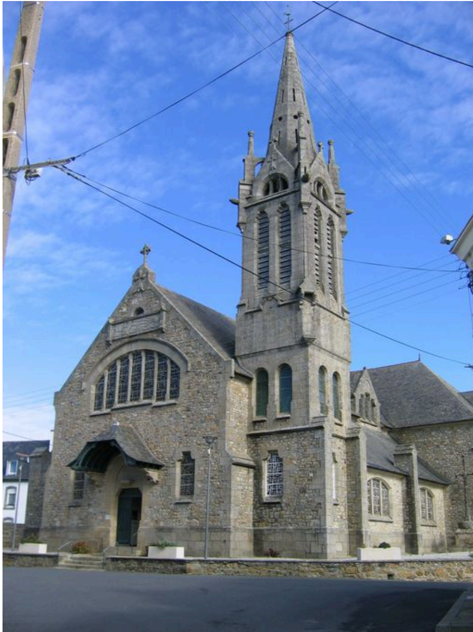
Vue générale de l'église Saint-Rémi, élévation ouest
