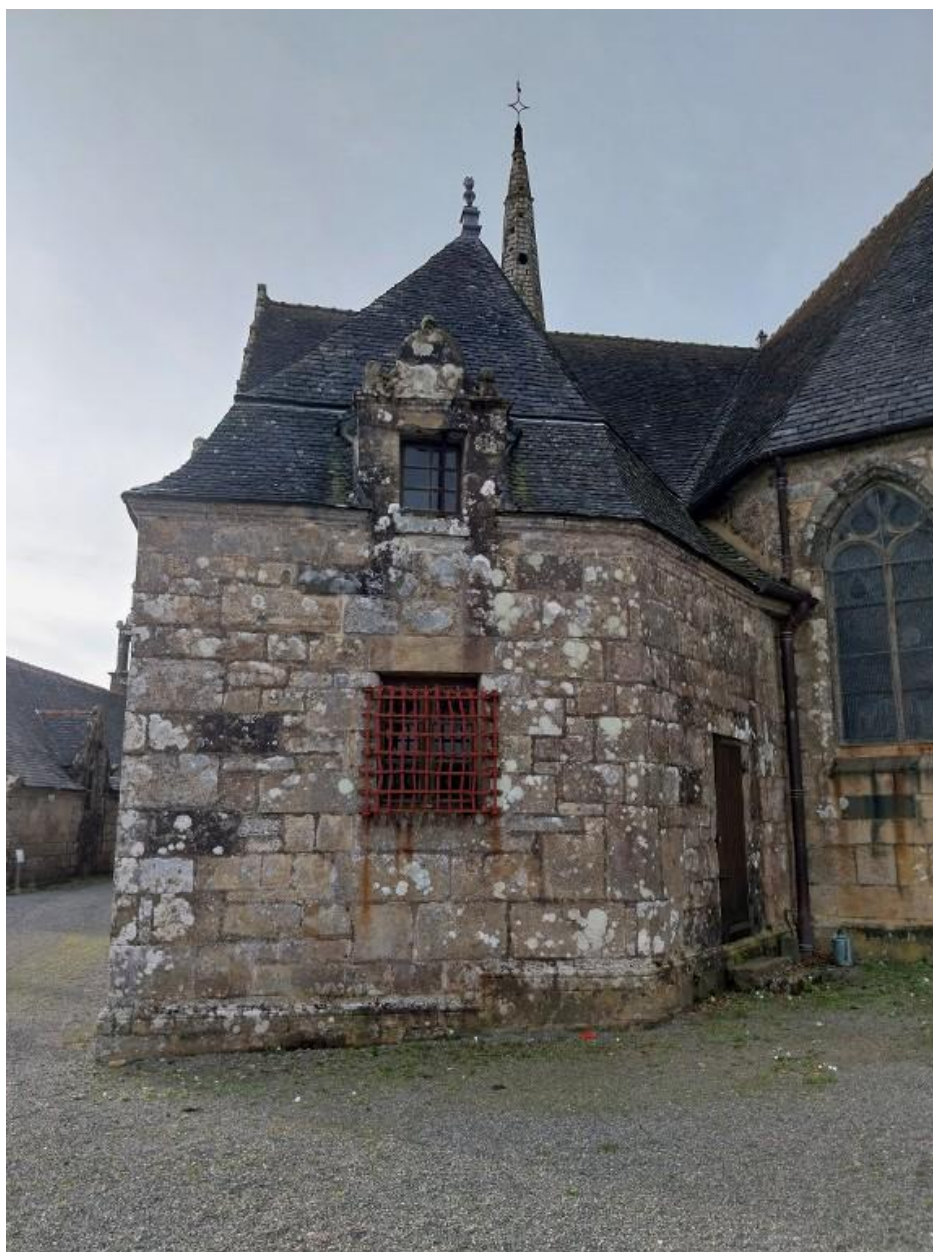
Sacristie vue depuis l'est
