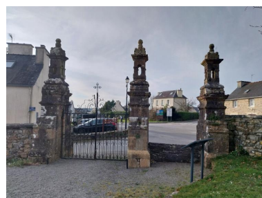
Vue de l'entrée à piliers et échaliers nord-ouest depuis l'intérieur de l'enclos Phot. Valentine Guillevic IVR53_20252910657NUCA
