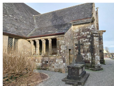
Ossuaire d'attache, vue depuis le sud-ouest Phot. Valentine Guillevic IVR53_20252910649NUCA
