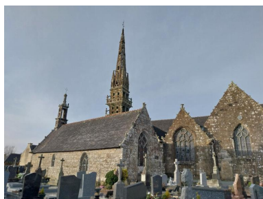
Vue du sud avec la chapelle, le clocher et la façade sud de l'église Phot. Valentine Guillevic IVR53_20252910658NUCA
