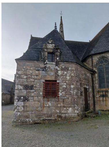
Sacristie vue depuis l'est Phot. Valentine Guillevic IVR53_20252910654NUCA
