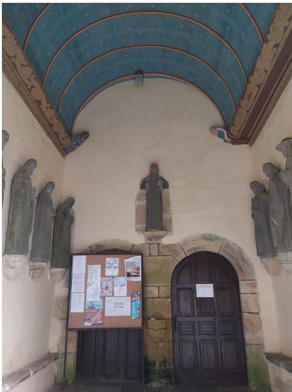
Intérieur du porche sud
