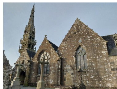
Vue de la façade sud avec le clocher et le proche sud Phot. Valentine Guillevic IVR53_20252910656NUCA
