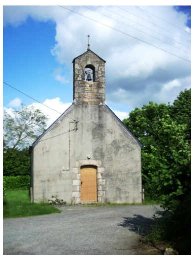
Chapelle Sainte-Anne : élévation ouest Phot. Gwénaél Fauchille IVR53_20082906050NUCA
