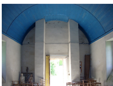
Chapelle Sainte-Anne : vue axiale ouest Phot. Gwénaél Fauchille IVR53_20082906053NUCA
