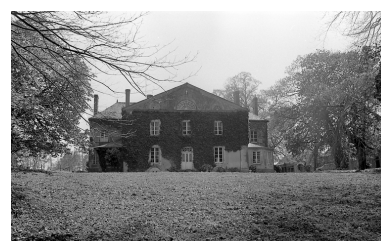
Logis : élévation postérieure Phot. Denise Dufief IVR53_19815600132Z
