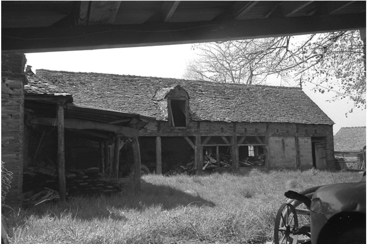
Dépendances : vue du sud-est
