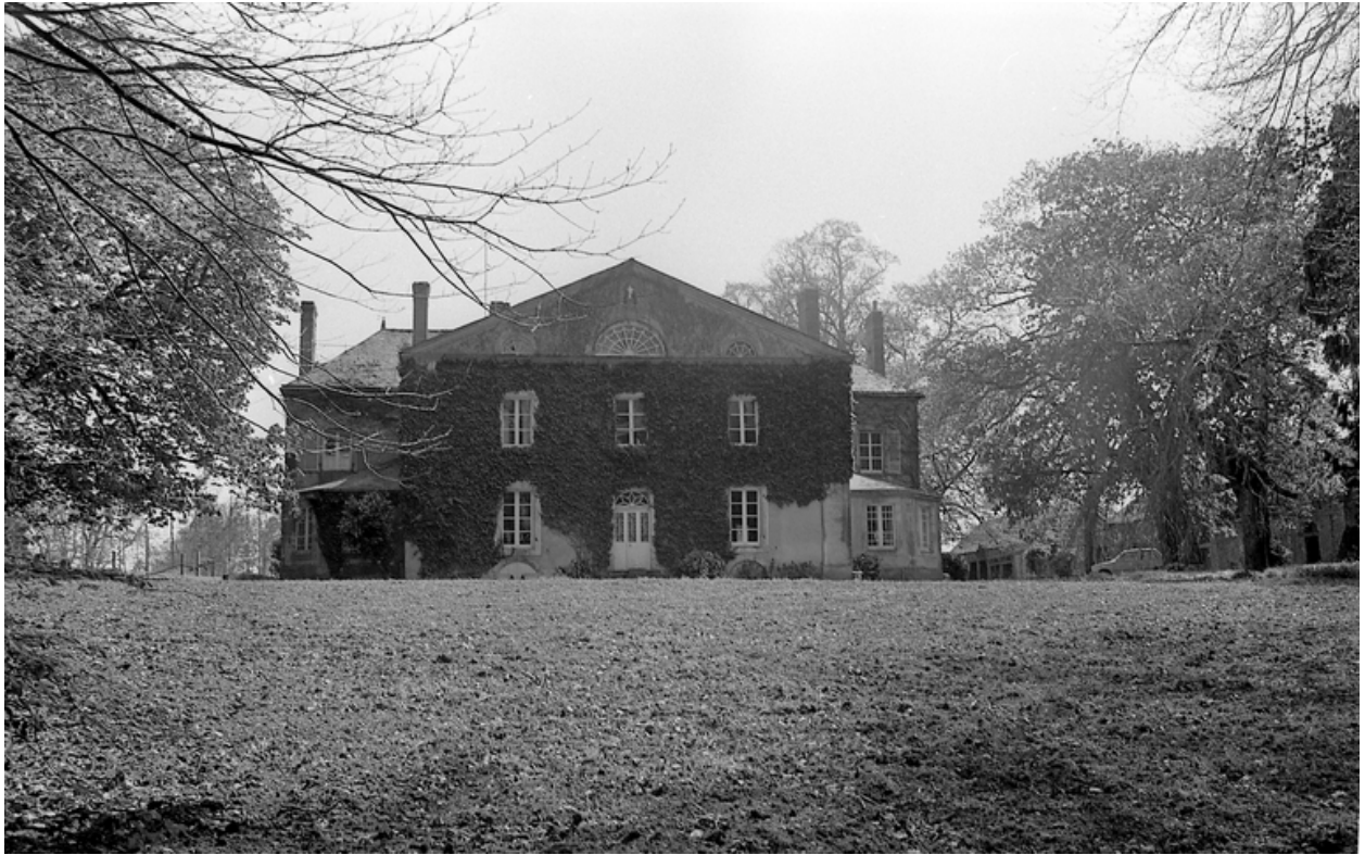
Logis : élévation postérieure
