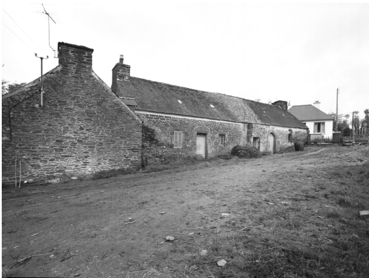
Vue générale ouest
