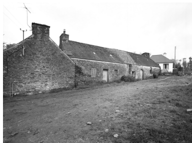
Vue générale ouest Phot. François Dagorn IVR53_19662200346V
