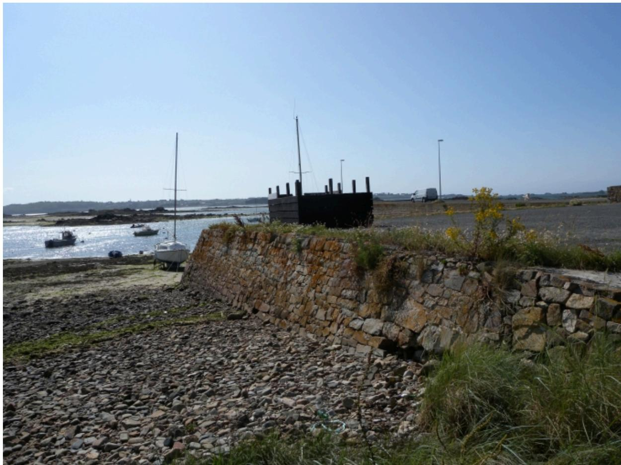
Vue du mur de soutènement Sud (en mauvais état) et de la plate-forme
