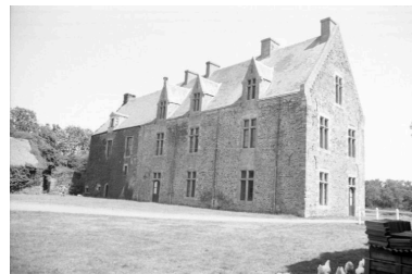
Vue générale Phot. Auteur inconnu IVR53_19745605446Z
