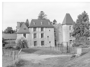
Château, vue générale nord-est. Phot. Jean-Pierre Ducouret IVR53_19843501455X
