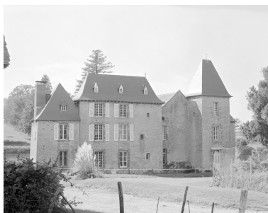
Château, vue générale nord. Phot. Guy Artur, Phot. Norbert Lambart IVR53_19873500257X
