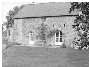
Vue générale de l'ancienne étable. Phot. Jean-Pierre Ducouret IVR53_19843501454X
