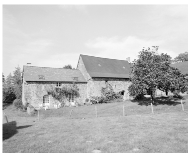
Vue générale est de la ferme et des étables. Phot. Guy Artur, Phot. Norbert Lambart IVR53_19873500254X
