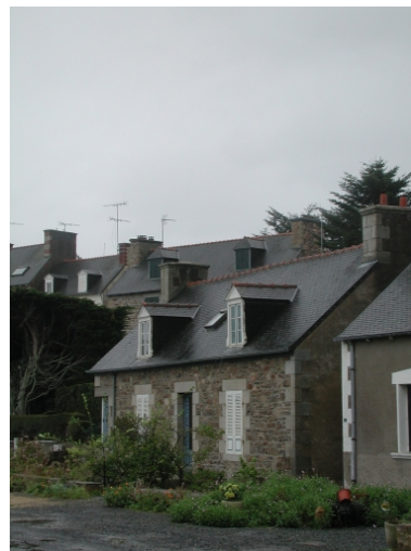
Maison traditionnelle à l'Est et à l'entrée du port de Loguivy Phot. Guy Prigent IVR53_20082208187NUCA
