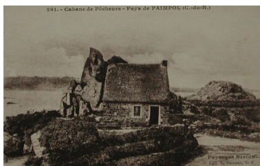
Chaumière à l'entrée du port de Loguivy (carte postale, collection particulière) Phot. Guy Prigent, Phot. Auteur inconnu IVR53_20082208157NUCB
