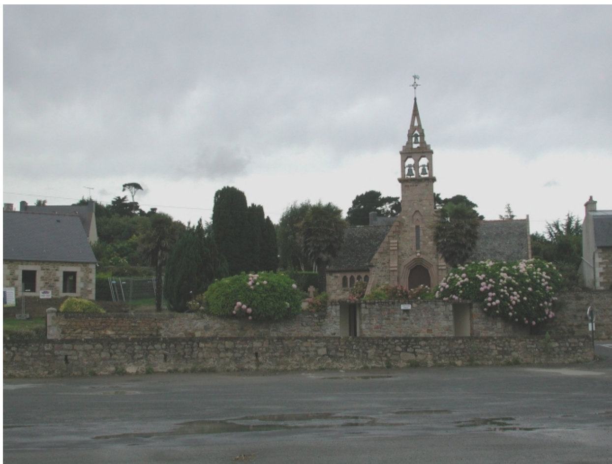
Vue de l'église de Saint-Ivy et de la maison paroissiale en construction
