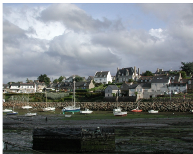
Bâti littoral du front de mer Est du port de Loguivy Phot. Guy Prigent IVR53_20082208150NUCA
