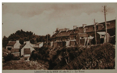
Vue des maisons alignés du quartier du Torot, 2ème quart 20ème siècle (carte postale, collection particulière) Phot. Guy Prigent, Phot. Auteur inconnu IVR53_20082207588NUCB
