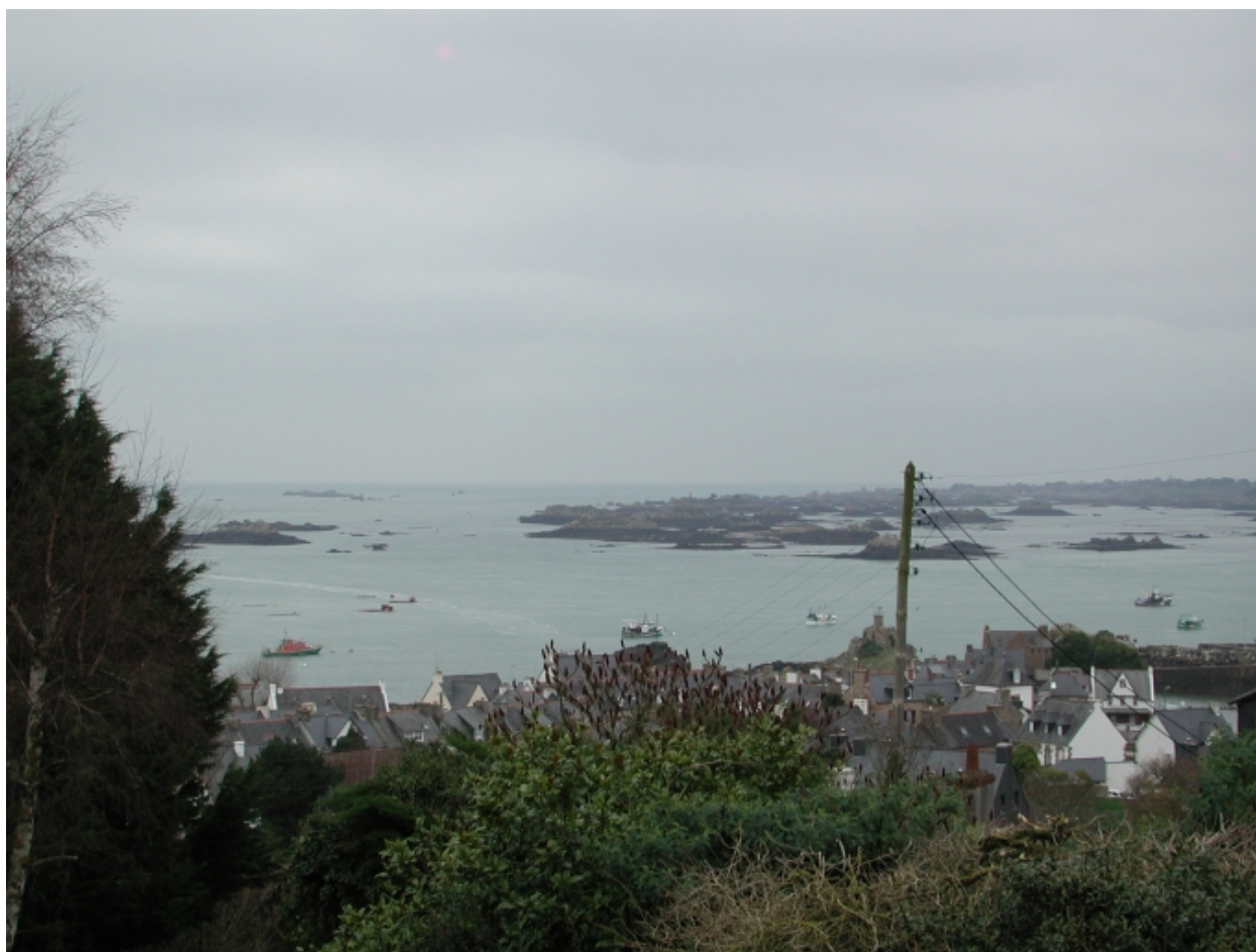
Vue de l'habitat groupé à l'Ouest au-dessus du port de Loguivy
