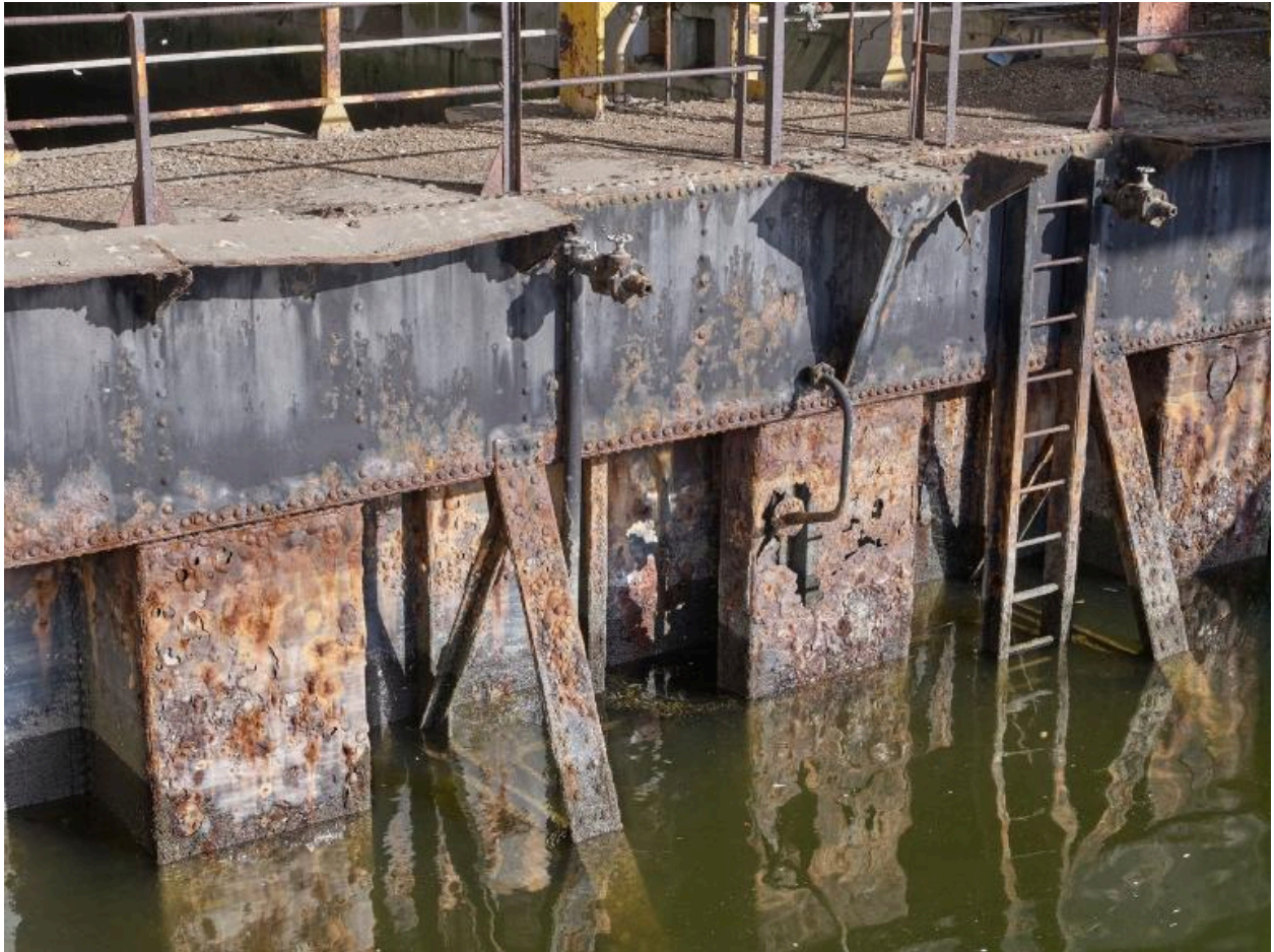
Vue de détail du bateau-porte fermant le bassin : prises d'air pour le remplissage du ballast ?
