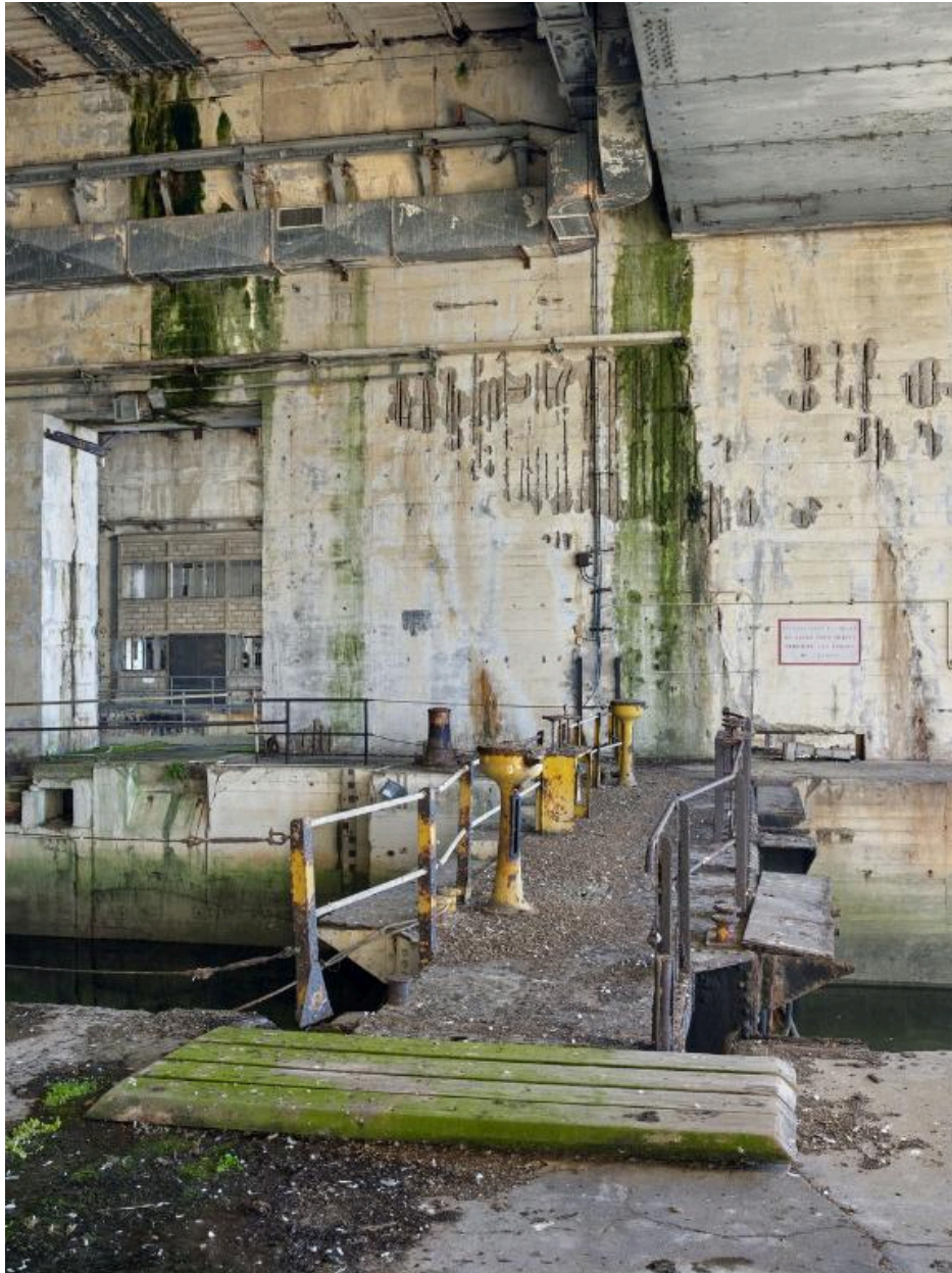
Vue de l'entrée de l'alvéole : bateau-porte fermant le bassin et porte blindée de protection
