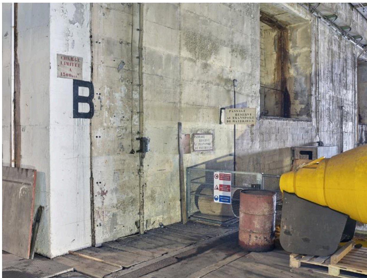
Vue du marquage alphabétique de l'alvéole et signalétiques du quai : CHARGE LIMITEE A 1300 KGS M2 / PASSAGE RESERVE AU TRANSPORT DE MATERIELS
