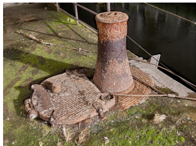
Vue de l'un des deux cabestans électriques à commande à pédale. L'inscription HILLAIRET PARIS-PERSAN est moulée sur le marchepied du cabestan et sur chacune des poupées Phot. Bernard Bègne IVR53_20235600624NUCA
