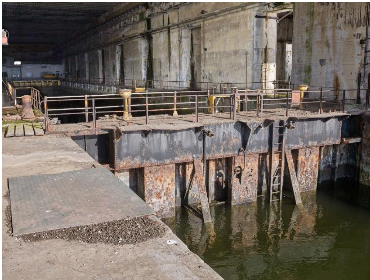
Vue du bateau-porte fermant le bassin depuis l'extérieur
