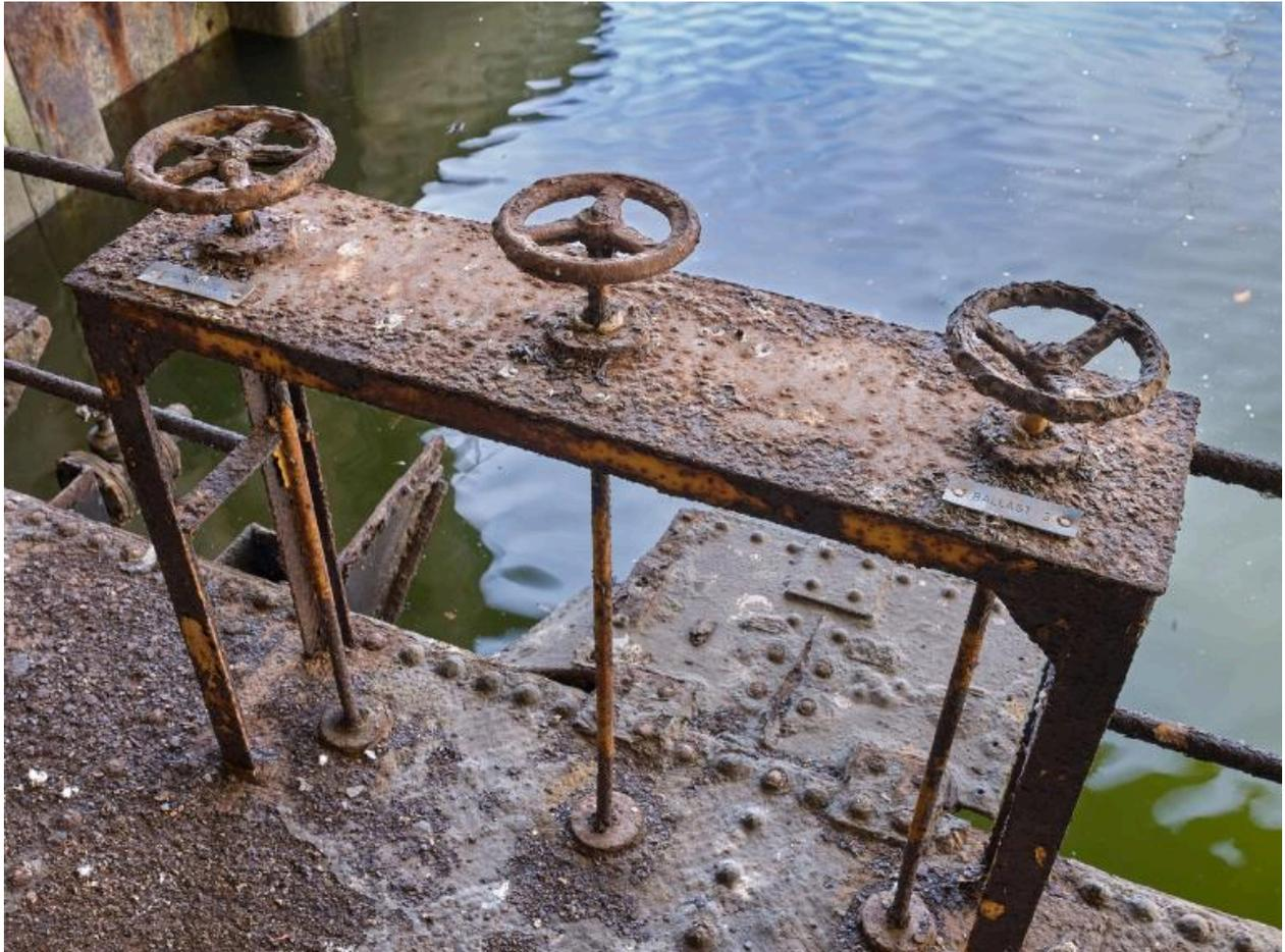
Vue des commandes des vannes du bateau-porte fermant le bassin (vers l'extérieur). On peut lire de gauche à droite :
