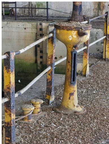
Vue de l'une des deux commandes de pompe sur le bateau-porte fermant le bassin. Elle fonctionnait avec une manivelle
