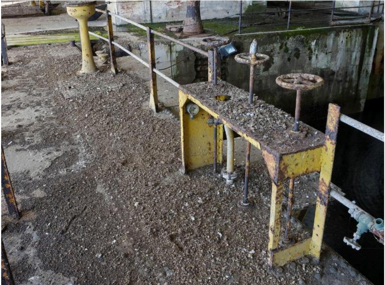
Vue des commandes des vannes de ballast du bateau-porte fermant le bassin (vers l'intérieur)
