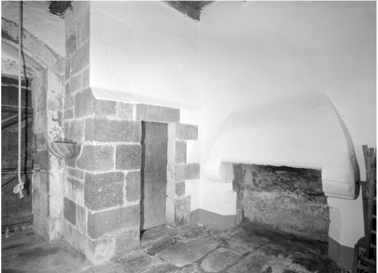
Vue de la cheminée et porte de la tour
