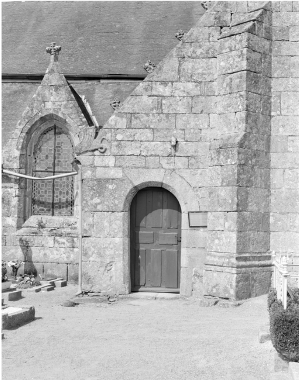
Porte dans le transept sud
