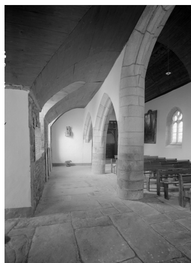
Bas-côté sud d'est en ouest Phot. Guy Artur IVR53_19742200387V
