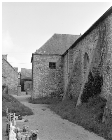
Transept : vue ouest Phot. Guy Artur IVR53_19742200379X
