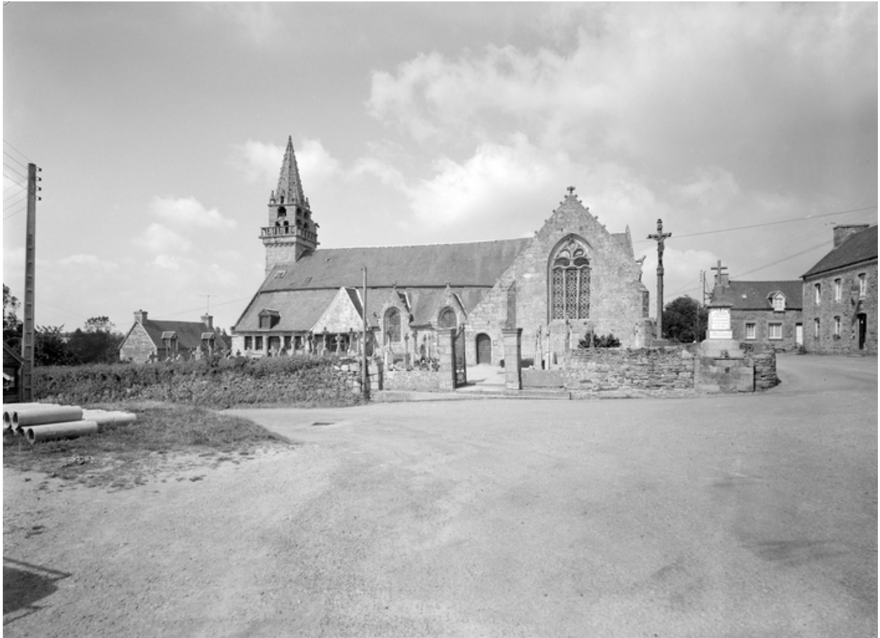
Vue générale sud
