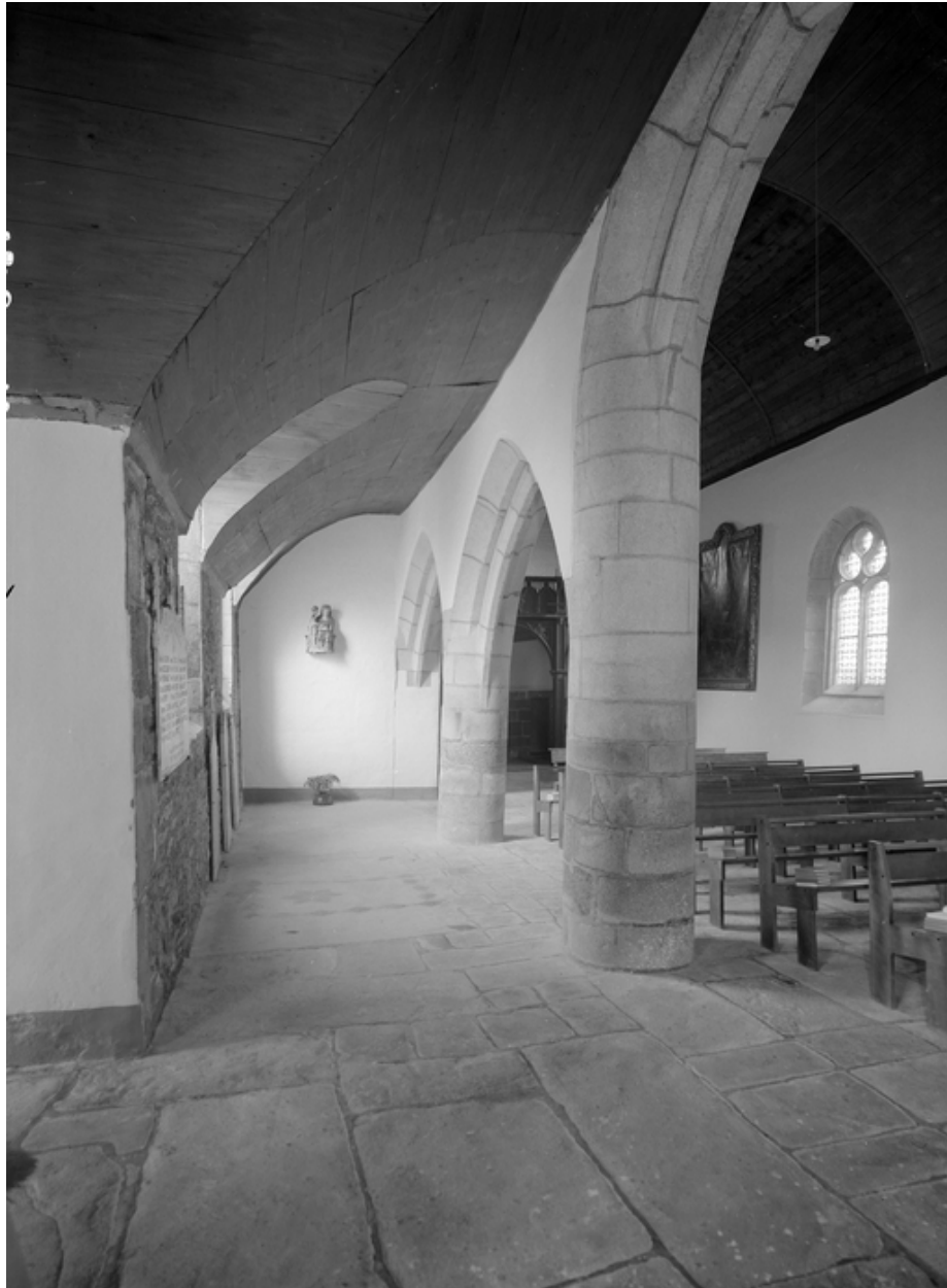
Bas-côté sud d'est en ouest
