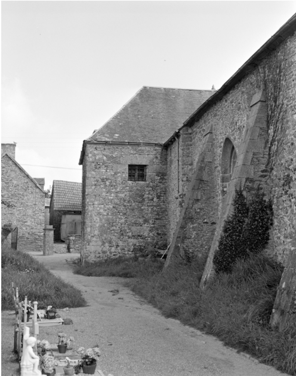
Transept : vue ouest
