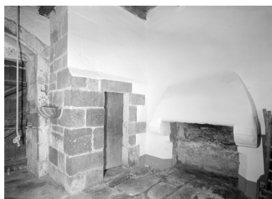
Vue de la cheminée et porte de la tour Phot. Guy Artur IVR53_19742200391V
