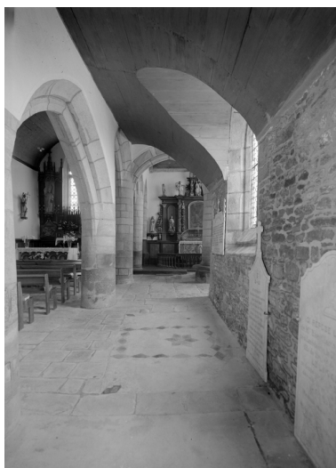
Bas-côté sud d'ouest en est Phot. Guy Artur IVR53_19742200392V
