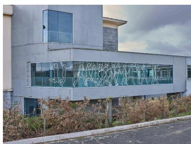
Galerie de liaison entre le lycée et le collège. Façade nord. Ouvrage rendu nécessaire pour la mise en accessibilité. Noter l'encorbellement et le traitement du grand bandeau vitré en angle, support d'une fresque.
