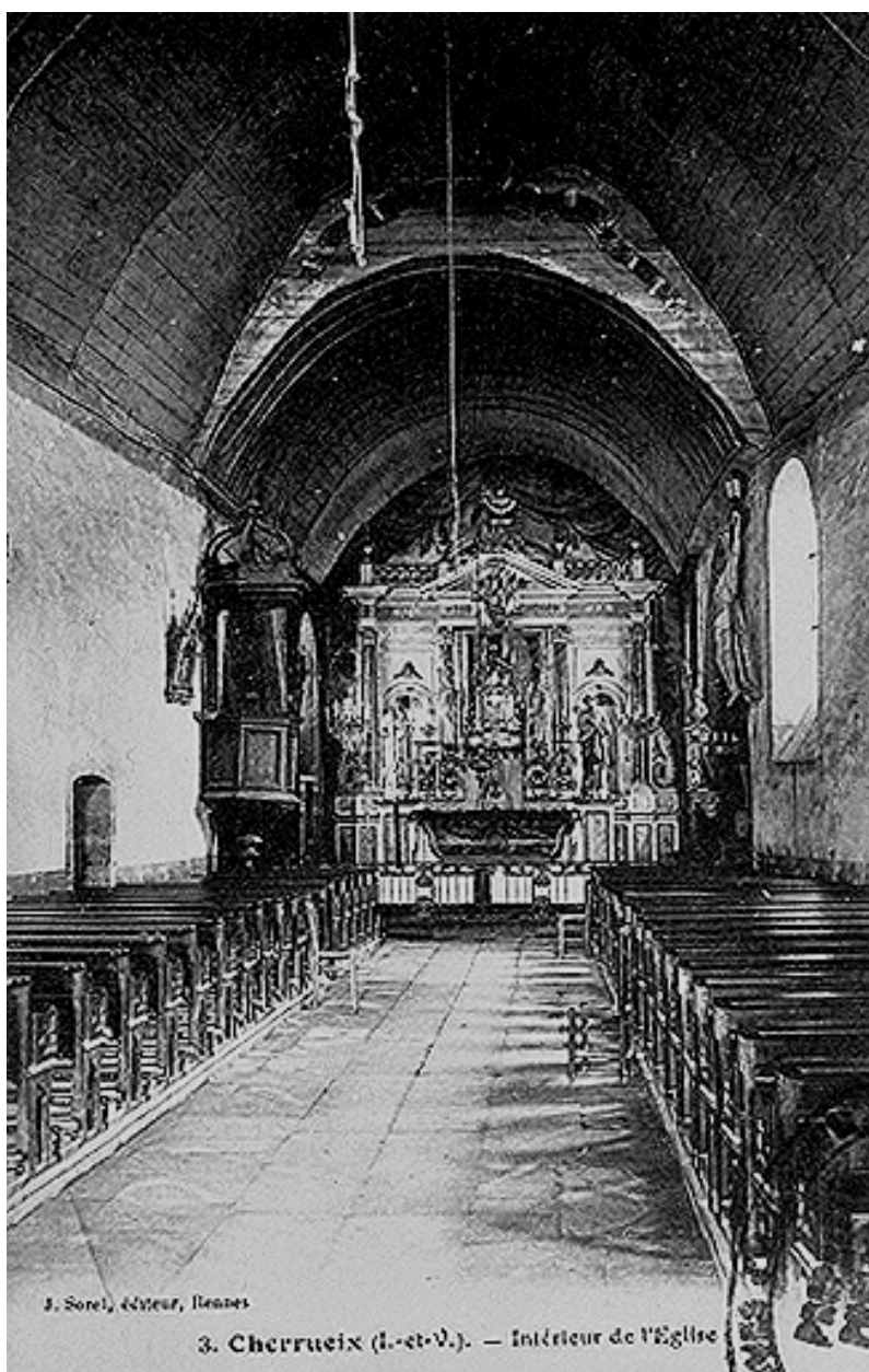
Carte postale ancienne : vue générale vers le choeur
