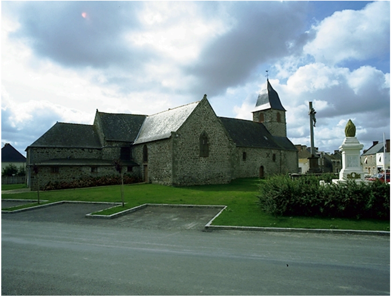
Vue générale nord-est
