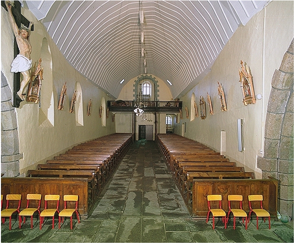
Vue générale vers la nef
