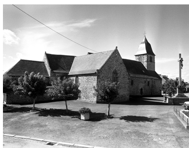
Vue générale nord-est Phot. Guy Artur, Phot. Norbert Lambart IVR53_19943501829X
