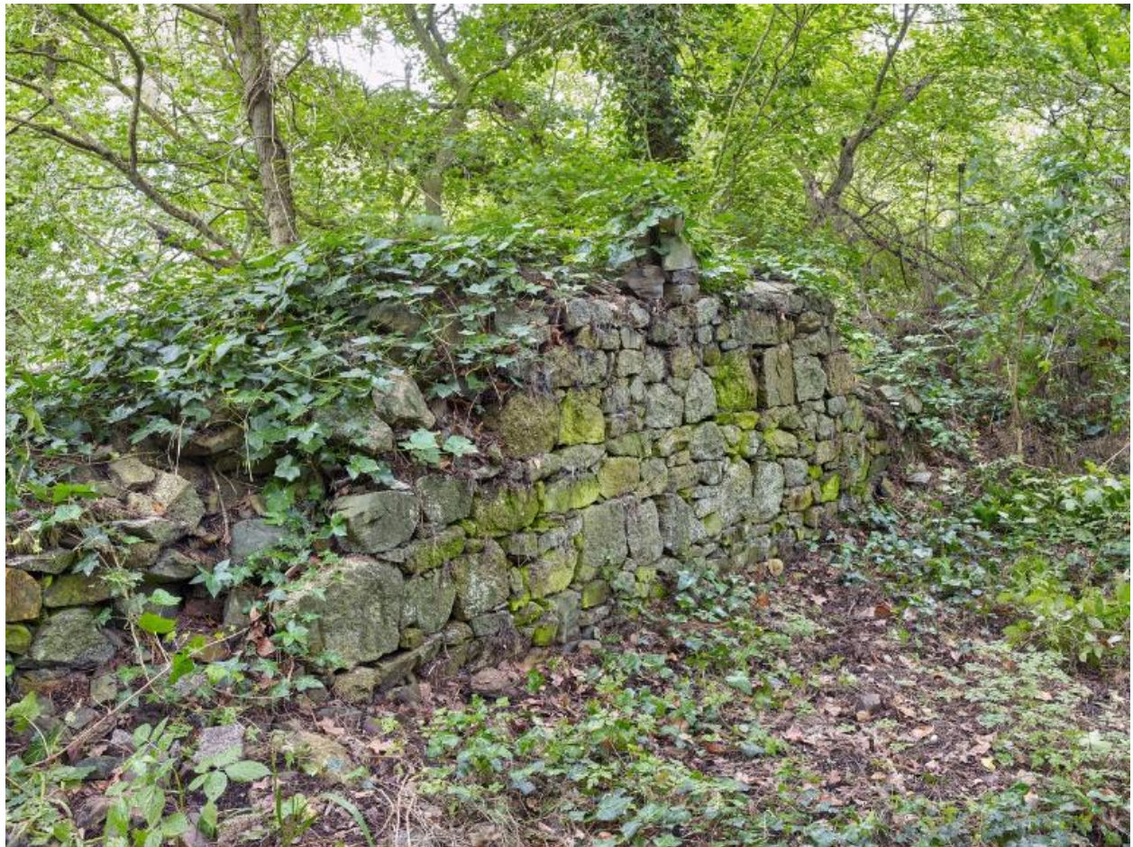
Vue du parapet du mur de soutènement au Nord côté Gouët : appareillage de moellon de granite
