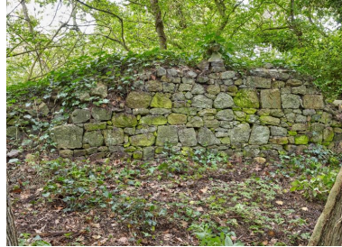
Vue du parapet du mur de soutènement au Nord côté Gouët : appareillage de moellon de granite Phot. Bernard Bègne IVR53_20232200665NUCA
