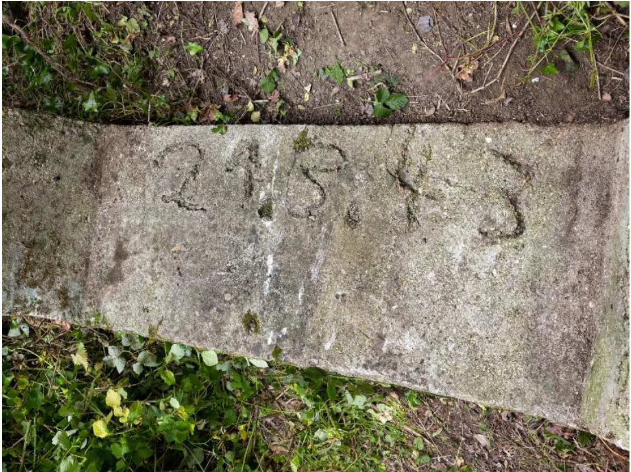
Vue du parapet du mur de clôture ceinturant le domaine : emplacement de tir situé à l'extrémité Est de la pointe près du bunker - casemate VF, date de construction dessinée dans le béton frais, 21.3.43
