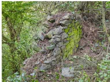
Vue du parapet du mur de soutènement au Nord côté Gouët : appareillage de moellon de granite (au niveau de la base du sol, 0,9 à 1 mètre d'épaisseur ; au plus haut, 0,6 mètre d'épaisseur) Phot. Bernard Bègne IVR53_20232200668NUCA
