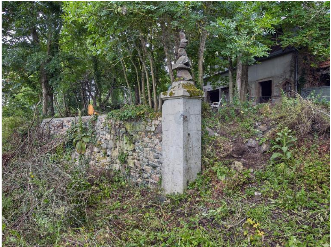
Vue de l'entrée Sud aménagée dans le mur de clôture : pilier Ouest en ciment armé
