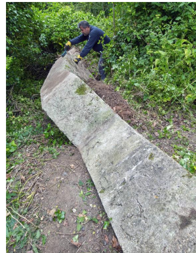
Vue du parapet du mur de clôture ceinturant le domaine : emplacement de tir situé à l'extrémité Est de la pointe près du bunker - casemate VF. L'ensemble a basculé : les traces d'un impact sont visibles. Sur cette photographie, Guillaume Lécueillier, chargé d'études Phot. Bernard Bègne IVR53_20232200387NUCA
