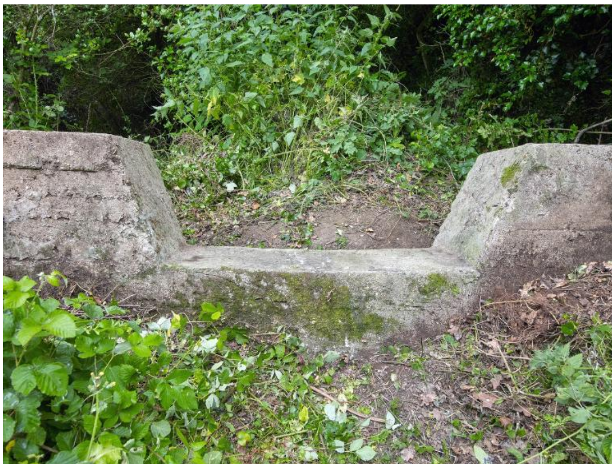
Vue du parapet du mur de clôture ceinturant le domaine : emplacement de tir situé à l'extrémité Est de la pointe près du bunker - casemate VF
