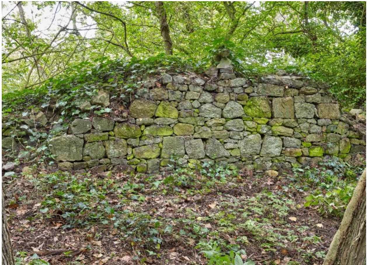
Vue du parapet du mur de soutènement au Nord côté Gouët : appareillage de moellon de granite
