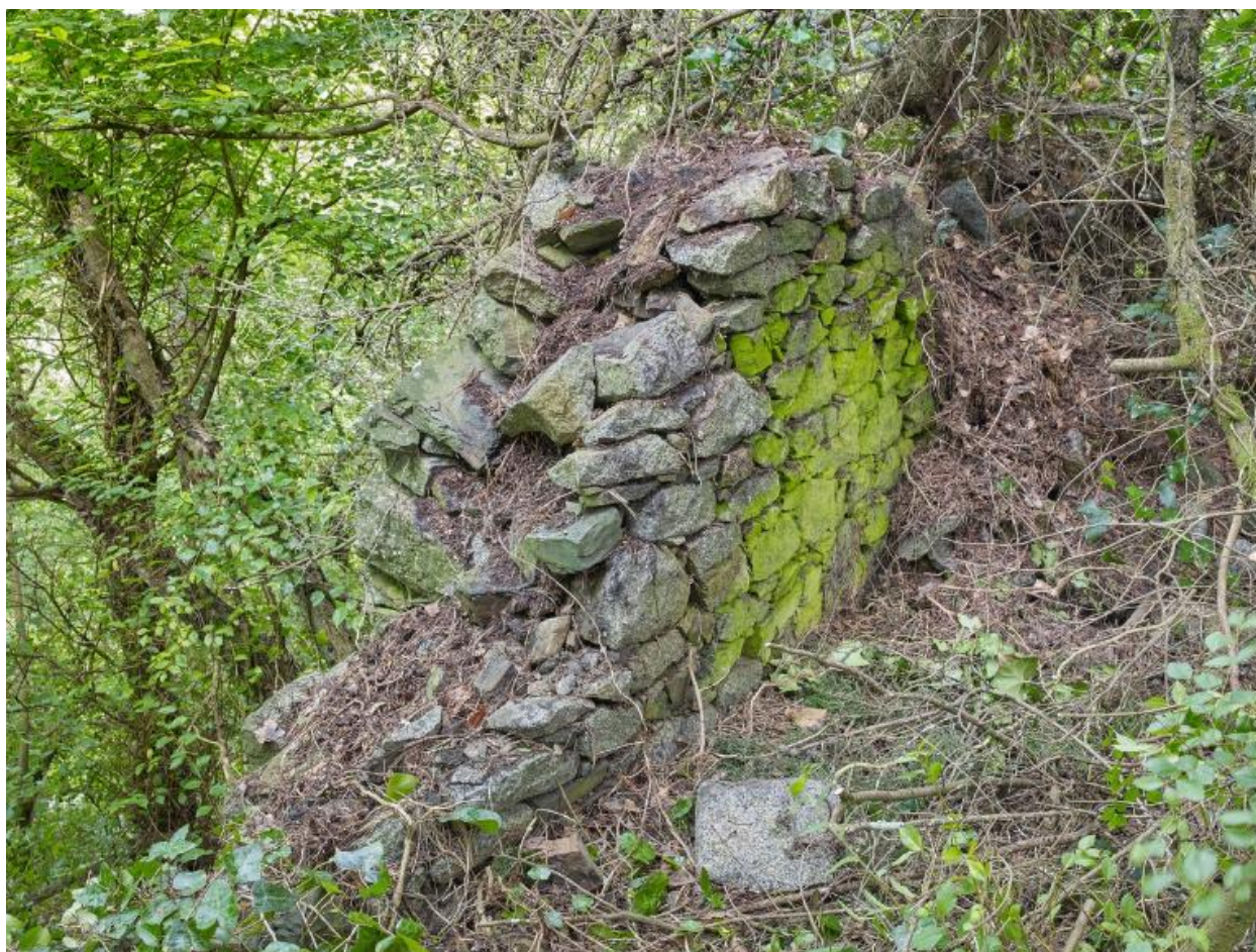
Vue du parapet du mur de soutènement au Nord côté Gouët : appareillage de moellon de granite (au niveau de la base du sol, 0,9 à 1 mètre d'épaisseur ; au plus haut, 0,6 mètre d'épaisseur)
