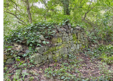
Vue du parapet du mur de soutènement au Nord côté Gouët : appareillage de moellon de granite Phot. Bernard Bègne IVR53_20232200666NUCA
