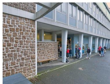
Façade sud-est de l'externat. Noter les pilotis du rez-de-chaussée, rappelant les tins de ber. La partie centrale du préau était à l'origine ouverte des deux côtés. L'atelier ramandage a été construit ultérieurement.
