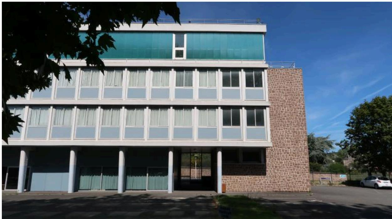
Externat, détail de la façade sud-est. Une cloison verte, translucide, a été installée devant la coursive du dernier étage. Sous le préau ouvert sur deux côtés à l'origine, a été installé l'atelier de ramandage. L'esprit paquebot voulu par l'architecte Roger Hummel en est atténué.
