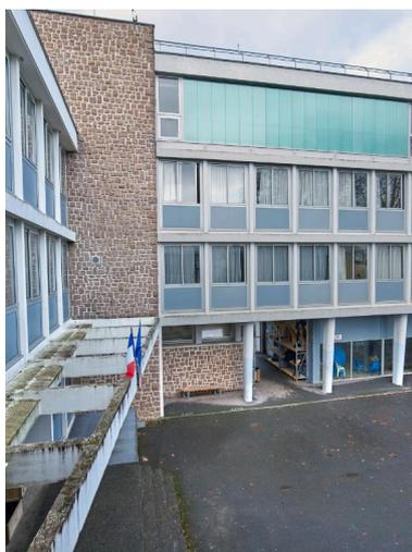
Entrée de l'internat-externat, située dans le retour d'équerre reliant les deux barres. Noter le auvent ajouré. La coursive du dernier étage a disparu derrière une cloison.
