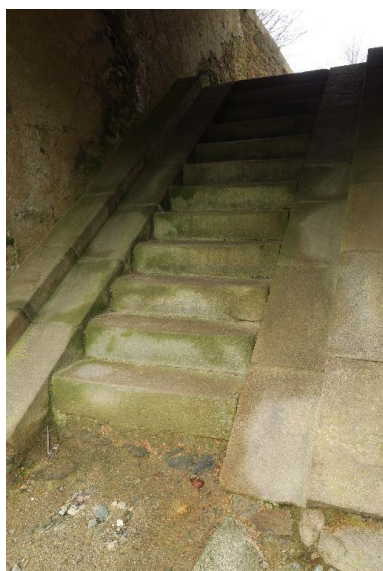
Le Palais, citadelle, escalier-rampe dans le cavalier du bastion 2. Phot. Lionel Duigou IVR53_20175606724NUCA
