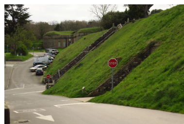
Le Palais, enceinte urbaine, courtine 20-21, talus côté ville. Phot. Lionel Duigou IVR53_20175608304NUCA
