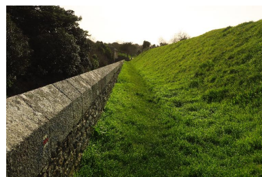
Le Palais, enceinte urbaine, courtine 18, mur à bahut et cavalier d'artillerie terrassé. Phot. Lionel Duigou IVR53_20175608048NUCA
