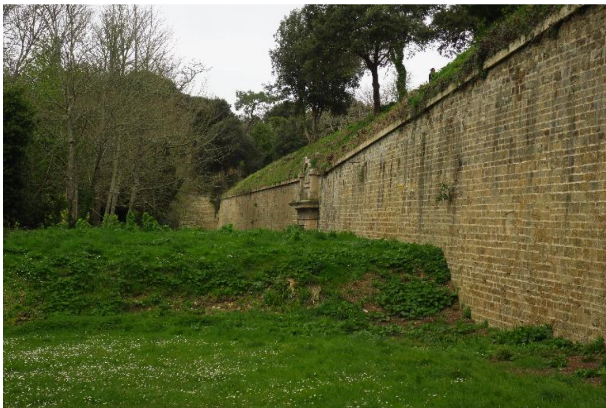
Le Palais, enceinte urbaine, courtine 20-21, escarpe maçonnée côté campagne.
