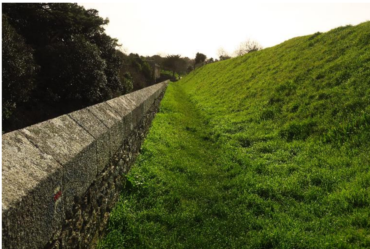
Le Palais, enceinte urbaine, courtine 18, mur à bahut et cavalier d'artillerie terrassé.
