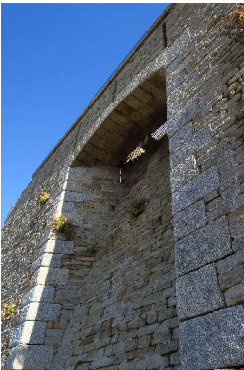
Saint-Pierre-Quiberon, fort de Penthièvre, créneau de pied.
