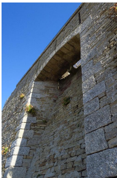
Saint-Pierre-Quiberon, fort de Penthievre, créneau de pied. Phot. Lionel Duigou IVR53_20175606670NUCA
