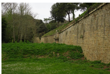
Le Palais, enceinte urbaine, courtine 20-21, escarpe maçonnée côté campagne. Phot. Lionel Duigou IVR53_20175608294NUCA
