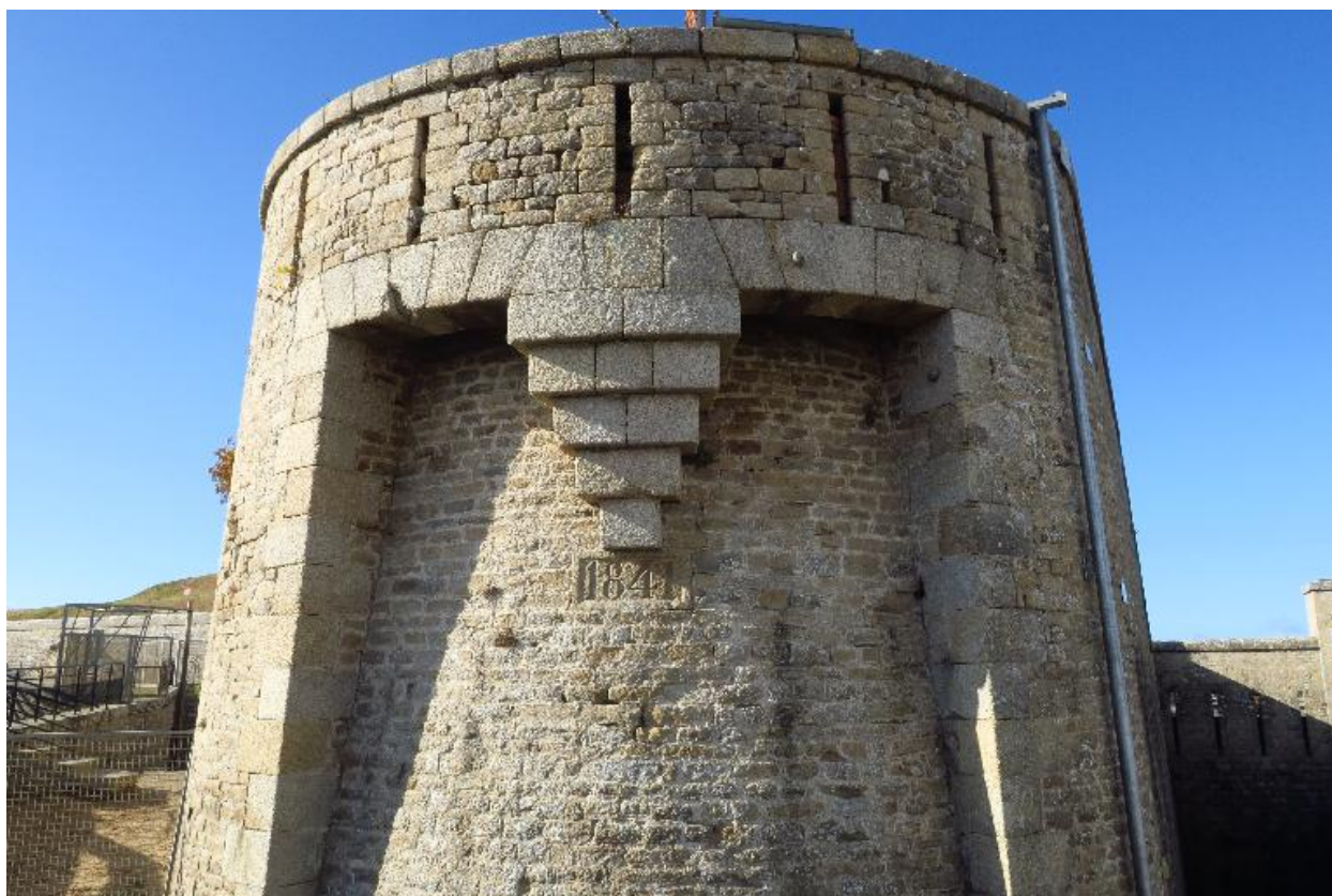
Saint-Pierre-Quiberon, fort de Penthievre, créneaux de pied et parapet crénelé.
