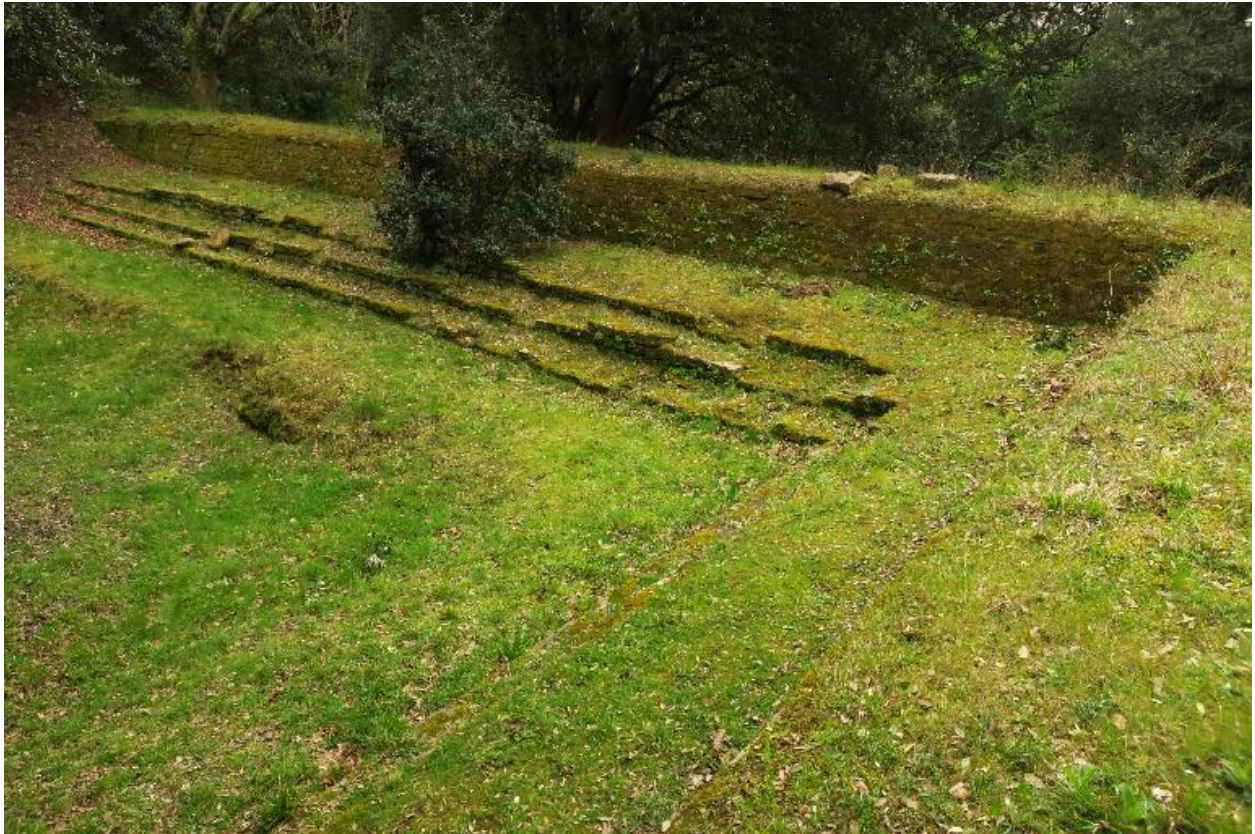
Le Palais, enceinte urbaine, courtine 21-22, parapet d'infanterie avec banquette en maçonnerie.
