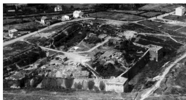
Brest, fort du Guelmeur, 1862. Phot. Archives municipales et communautaires. Brest Métropole Océane, Phot. Guillaume (retouche) Lécueillier, Autr. U.S. Army Signal Corps IVR53_20082909393NUC
