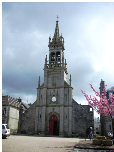
Huelgoat, église paroissiale Saint-Yves : vue générale ouest Phot. Gwénaél Fauchille IVR53_20082905739NUCA
