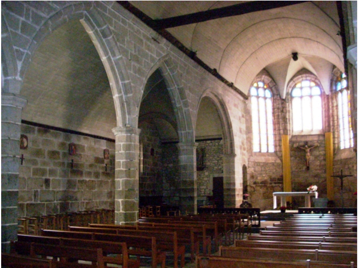
Huelgoat, église paroissiale Saint-Yves : vue transversale nord-est
