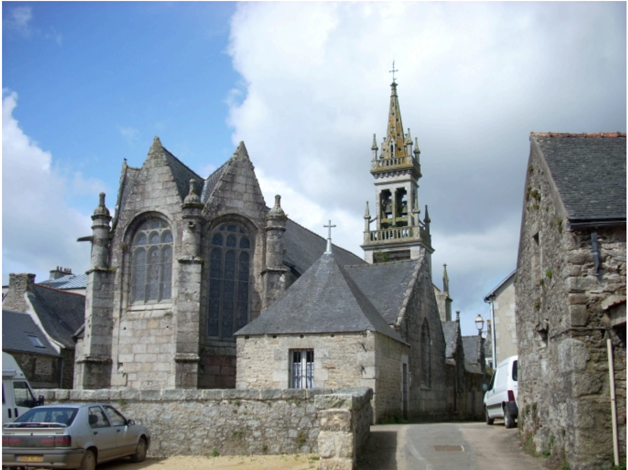
Huelgoat, église paroissiale Saint-Yves : vue générale nord-est
