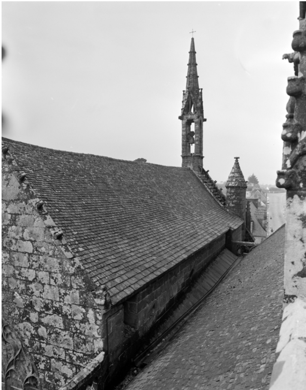
Chapelle du Pénity, toiture, versant nord
