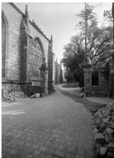
Façade sud Phot. Auteur inconnu IVR53_19712900144V
