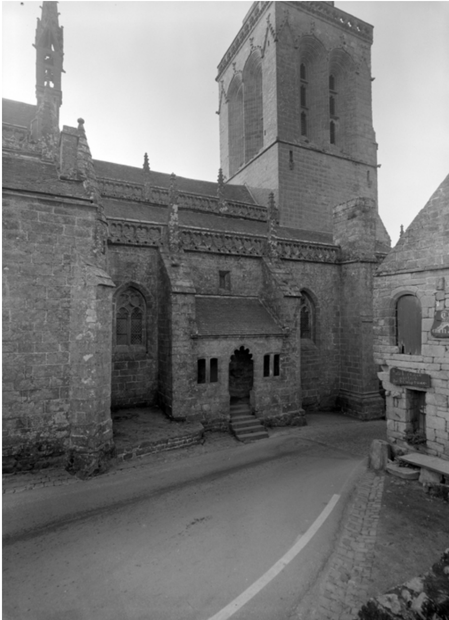
Façade nord, vue générale
