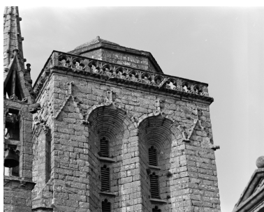
Tour-clocher, face sud Phot. Auteur inconnu IVR53_19742900292X
