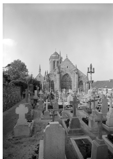
Façade est, vue générale Phot. Auteur inconnu
