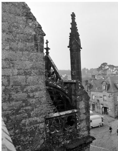
Porche, pignon, vue latérale nord Phot. Auteur inconnu IVR53_19742900299X
