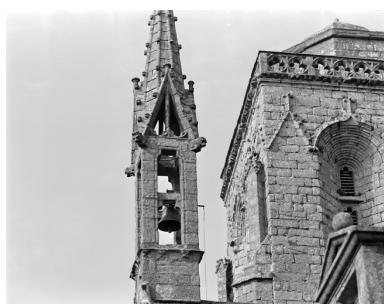
Chapelle du Pénity ; façade ouest, clocher, face sud Phot. Auteur inconnu IVR53_19742900294X
