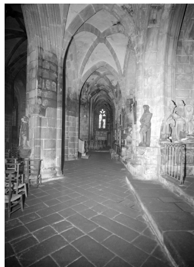
Bas-côté sud, vue ouest-est Phot. Auteur inconnu IVR53_19742900303V
