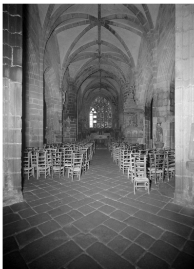
Nef, vue générale vers l'est Phot. Auteur inconnu IVR53_19742900302V
