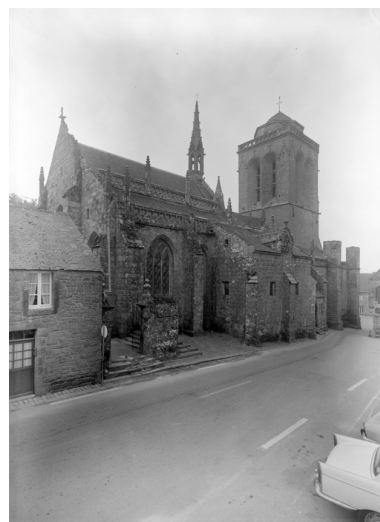
Façade nord, vue générale Phot. Auteur inconnu IVR53_19712900136V
