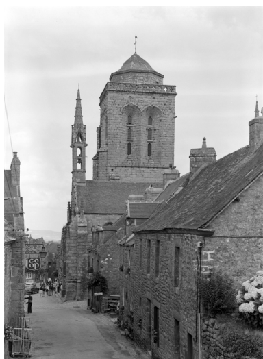
Vue de situation nord Phot. Auteur inconnu IVR53_19722901286V
