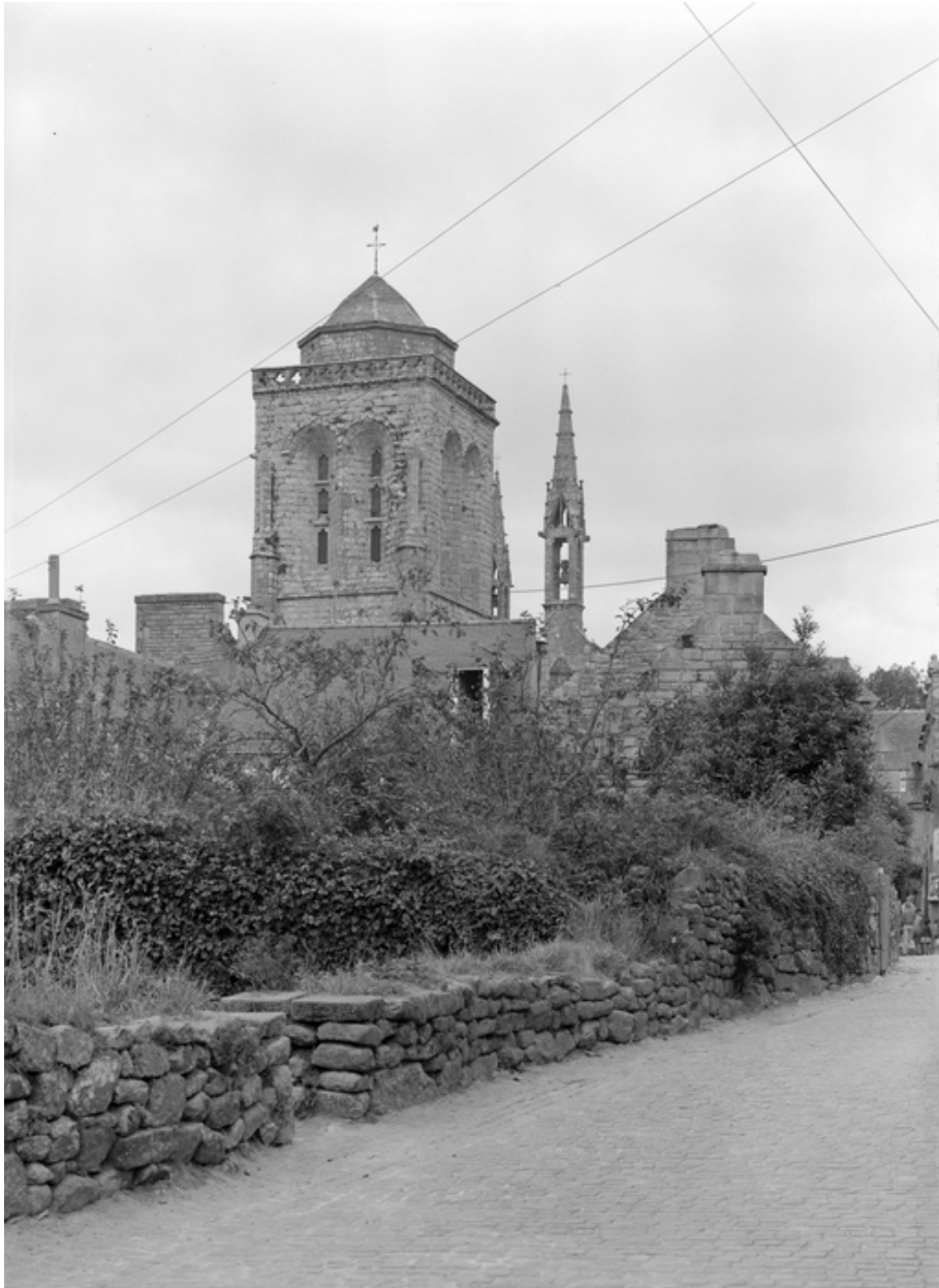
Vue de situation sud-ouest
