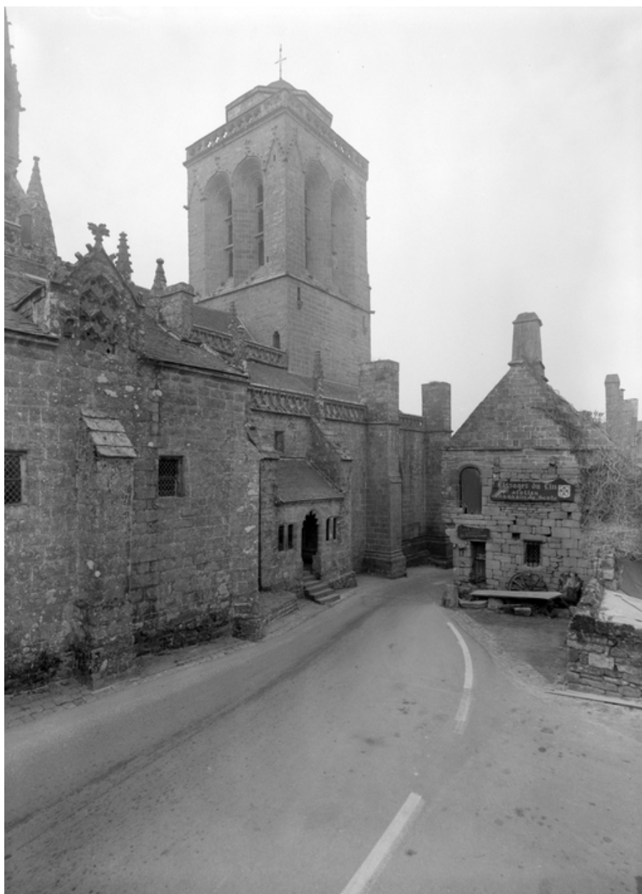
Façade nord, vue générale
