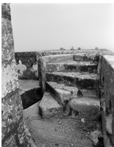
Tour-clocher, escalier de la terrasse Phot. Auteur inconnu IVR53_19742900295X
