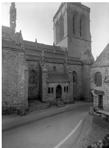
Façade nord, vue générale Phot. Auteur inconnu IVR53_19712900134V
