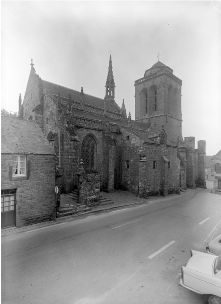
Façade nord, vue générale
