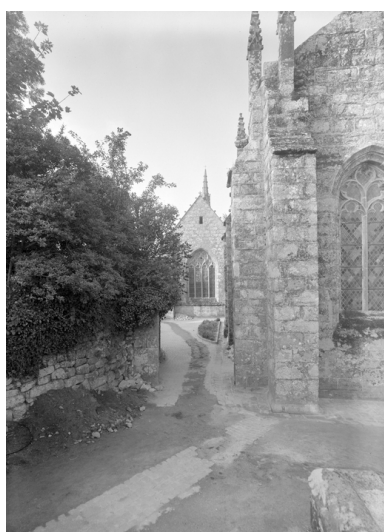
Façade est, vue générale Phot. Auteur inconnu
