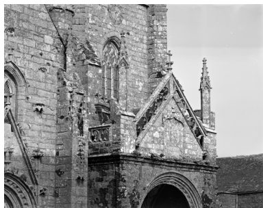
Porche, pignon Phot. Auteur inconnu IVR53_19742900298X
