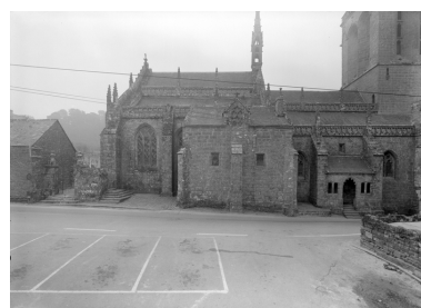
Façade nord, vue générale Phot. Auteur inconnu IVR53_19712900133V
