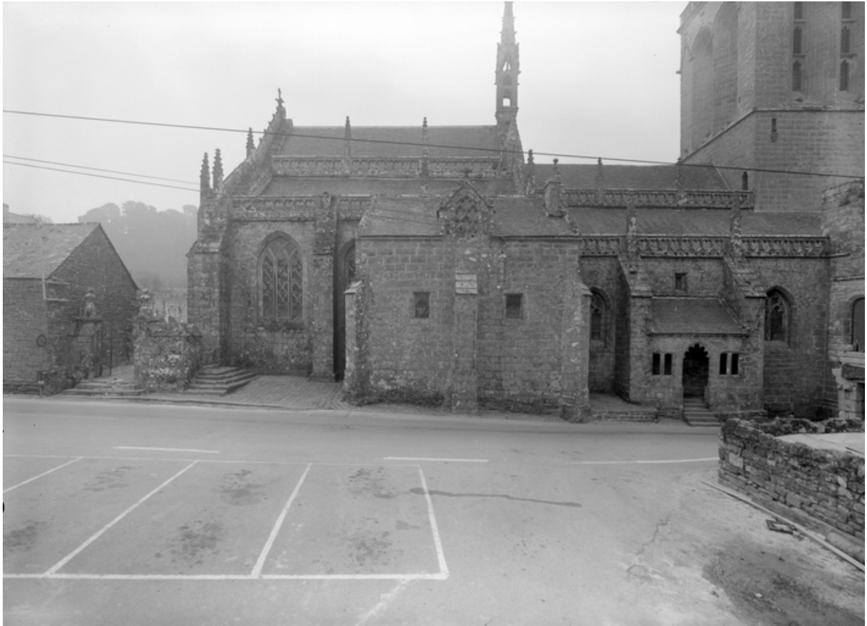
Façade nord, vue générale
