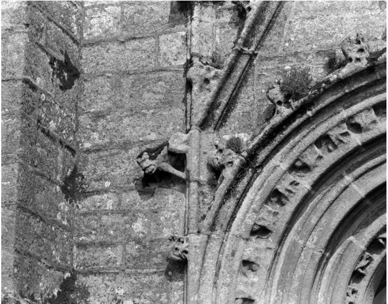
Chapelle du Pénity, façade ouest, détail gauche
