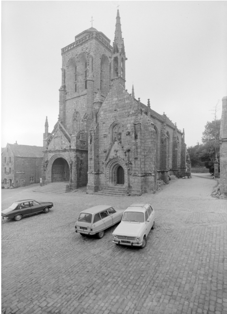
Façade ouest, vue générale
