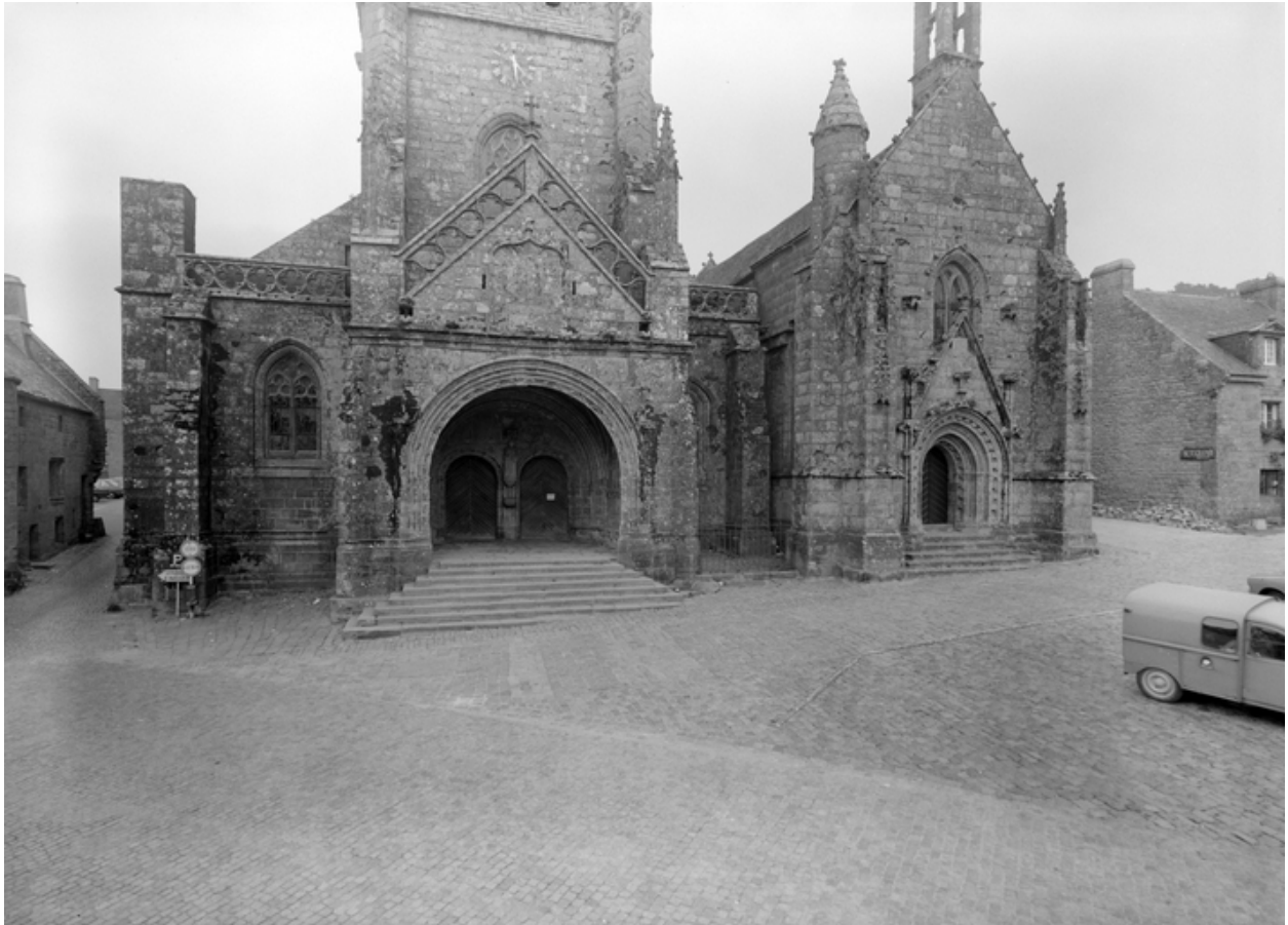
Vue d'ensemble ouest
