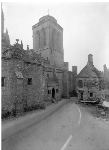
Façade nord, vue générale Phot. Auteur inconnu IVR53_19712900135V
