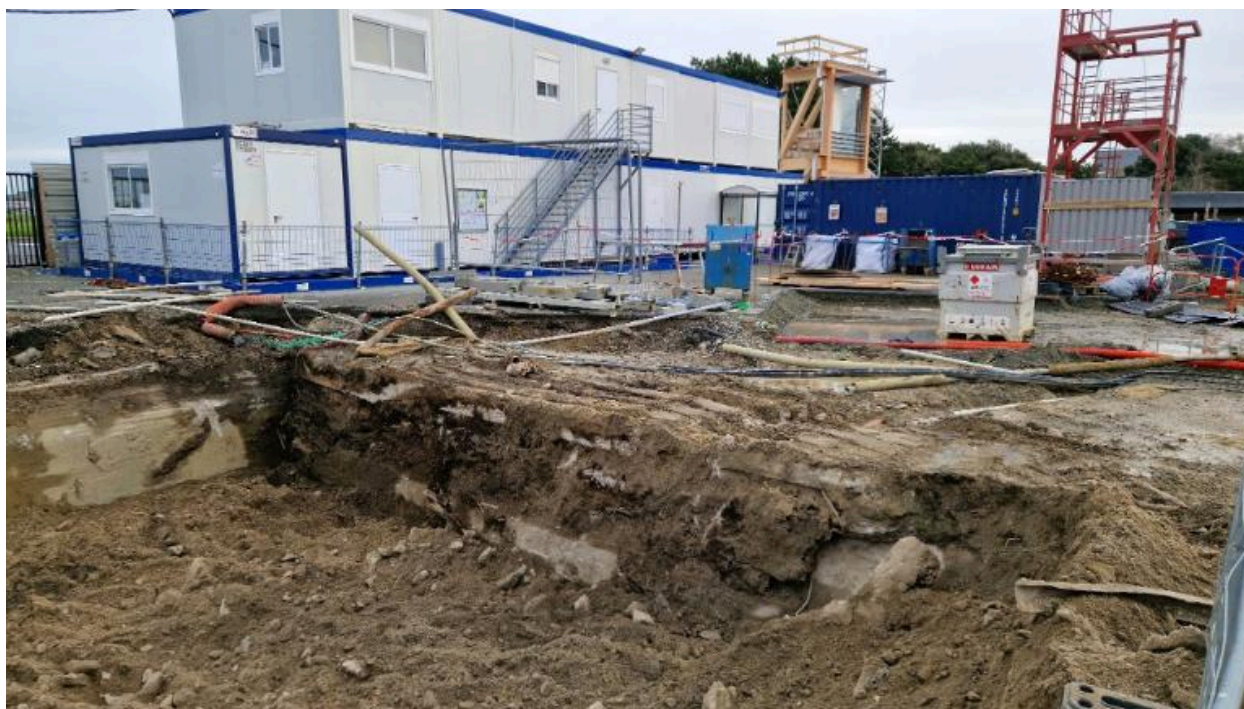
Vue de situation depuis le nord-ouest (couverture photographique du 17 décembre 2025). Seule la dalle de couverture est visible sous le remblai
