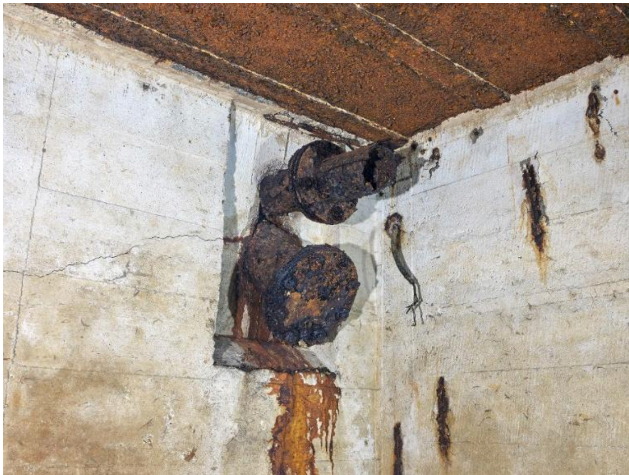
Vue de détail de l'extrémité ouest de la salle de garde : conduit de cheminée (en haut) et conduit de ramonage (en bas) du poêle. Dans le mur, passage de câble électrique du magasin à munitions
