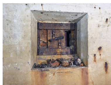
Vue de détail de l'ouverture de tir blindée de l'entrée ouest. Sur le rebord se trouvent regroupés différents artefacts : brosse en bois, cartouches de masque à gaz... Phot. Bernard Bègne IVR53_20253501360NUCA
