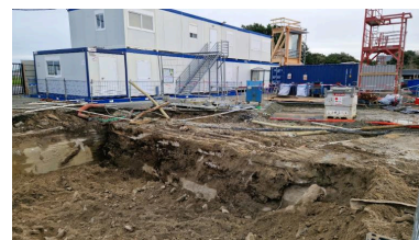
Vue de situation depuis le nord-ouest (couverture photographique du 17 décembre 2025). Seule la dalle de couverture est visible sous le remblai Phot. Guillaume Lécullier IVR53_20263510064NUCA
