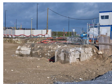
Vue générale depuis le sud (couverture photographique du 22 janvier 2026). La partie en saillie correspond au poste d'observation. Les planches situées à droite servent à étayer l'une des deux entrées du bunker Phot. Bernard Bègne IVR53_20263500067NUCA
