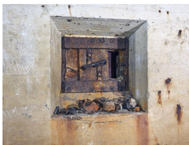
Vue de détail de l'ouverture de tir blindée de l'entrée ouest. Sur le rebord se trouvent regroupés différents artefacts : broches en bois, cartouches de masque à gaz... Phot. Bernard Bègne IVR53_20253501360NUCA
