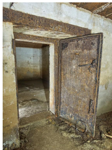
Vue de détail de la porte blindée étanche du magasin à munitions ouest
