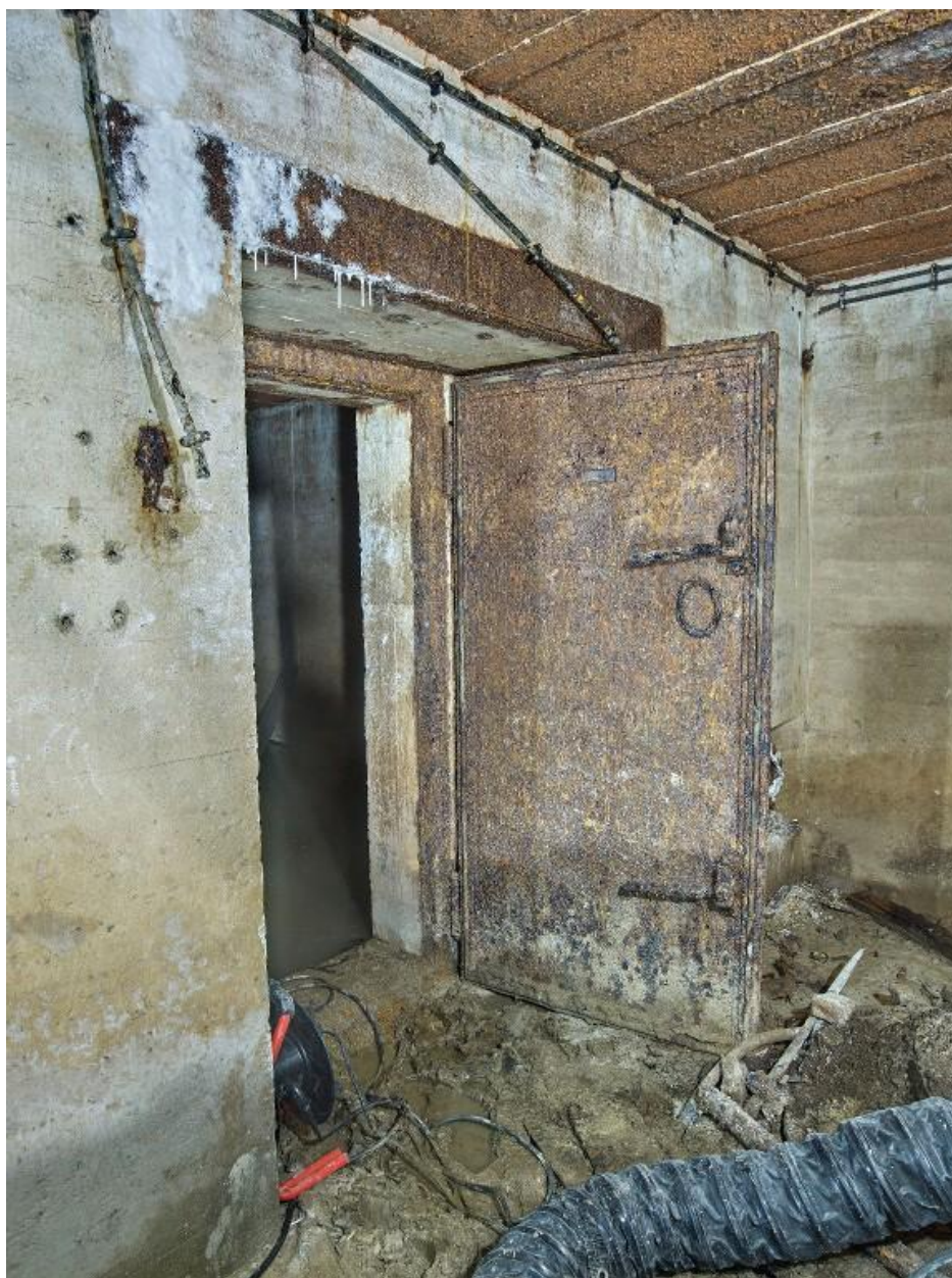
Vue de détail de la porte blindée étanche du magasin à munitions est (cette pièce est partiellement inondée). A gauche, emplacement d'un boîtier électrique : seul le câblage subsiste
