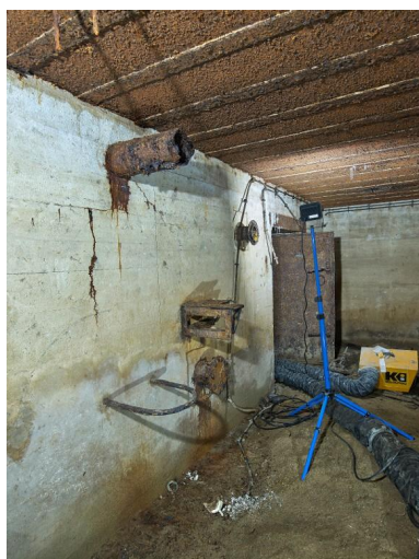
Vue de la salle de garde : emplacement du système de filtration. Au premier plan, l'arceau métallique servant à poser les filtres à charbon. Au fond, la porte étanche du magasin à munitions est visible. Phot. Bernard Bègne IVR53_20253501366NUCA
