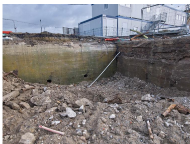
Vue depuis le nord-ouest : deux bunkers sont construits l'un contre l'autre (couverture photographique du 22 janvier 2026). A gauche, le bunker-abri situé sous la chaussée Éric Tabarly ; à droite, le bunker de type L 407a Phot. Bernard Bègne IVR53_20263500064NUCA
