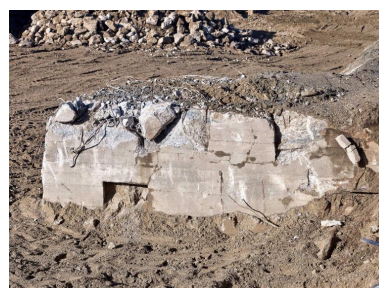
Vue de détail de la partie en saillie : poste d'observation dit Tobruk (couverture photographique du 22 janvier 2026). Au ras-du-sol, l'entrée dédiée du Tobruk. La
