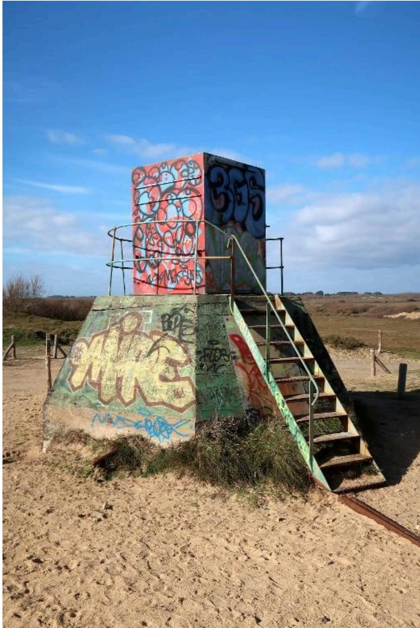
Vue du bunker de type V229 pour radar Würzburg See Riese. Il a été surmonté ultérieurement d'une cabine
