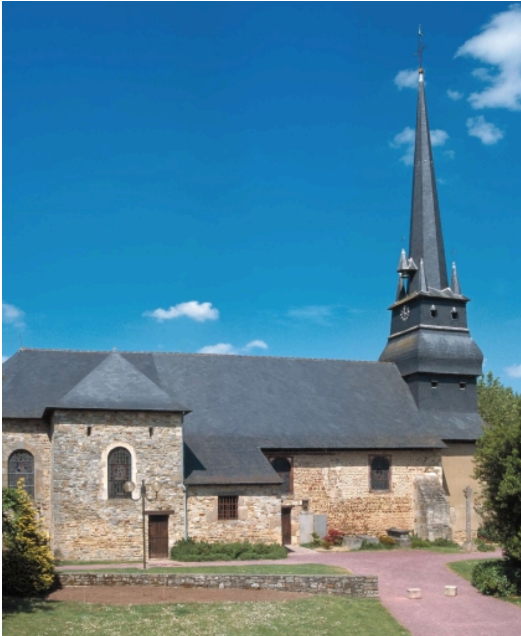
Vue générale de la façade sud
