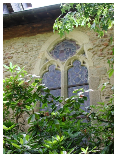
Façade nord : détail de la baie gothique
