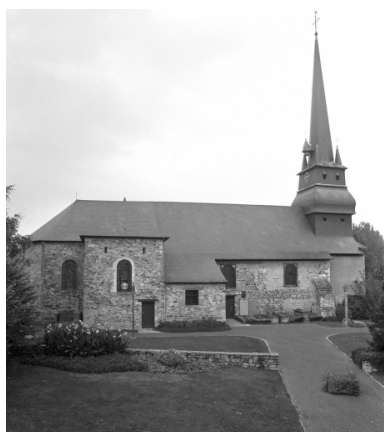
Vue d'ensemble de la façade sud Phot. Y. Desdoigts IVR53_19943501914X
