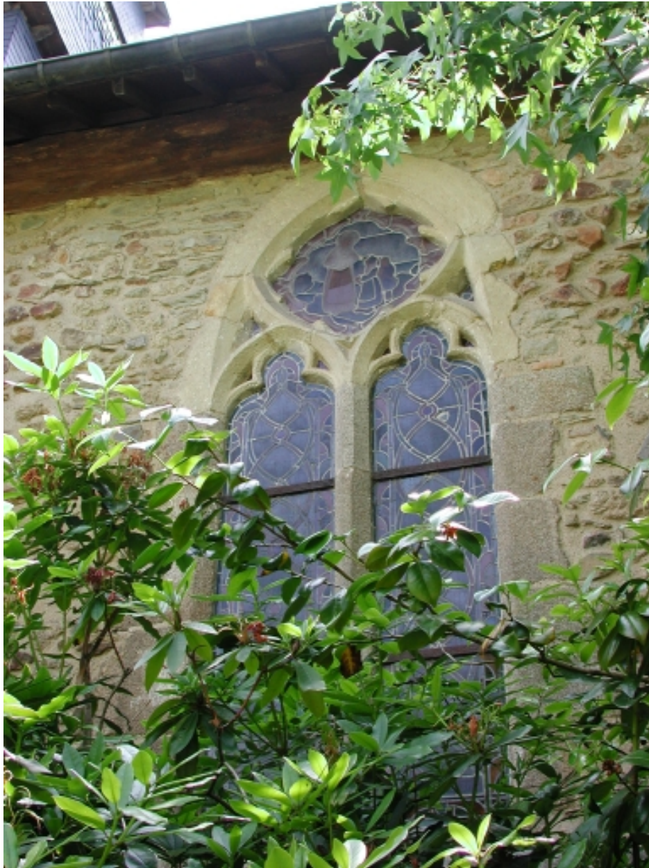
Façade nord : détail de la baie gothique
