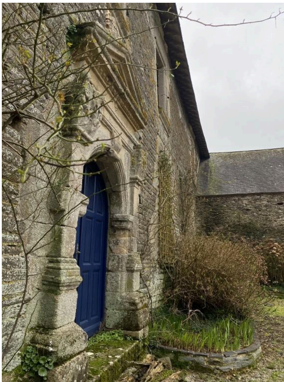
Porte, élévation ouest, détail
