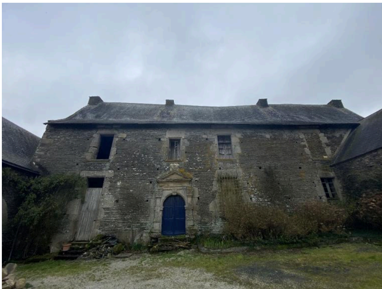
Élévation ouest, vue générale
