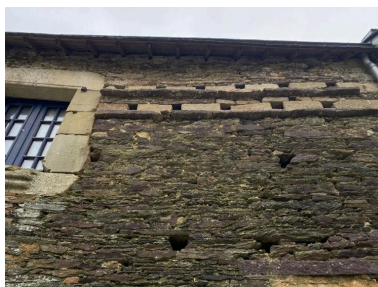
Aile nord, élévation sud, détail Phot. Baptiste Oligo IVR53_20265610246NUCA
