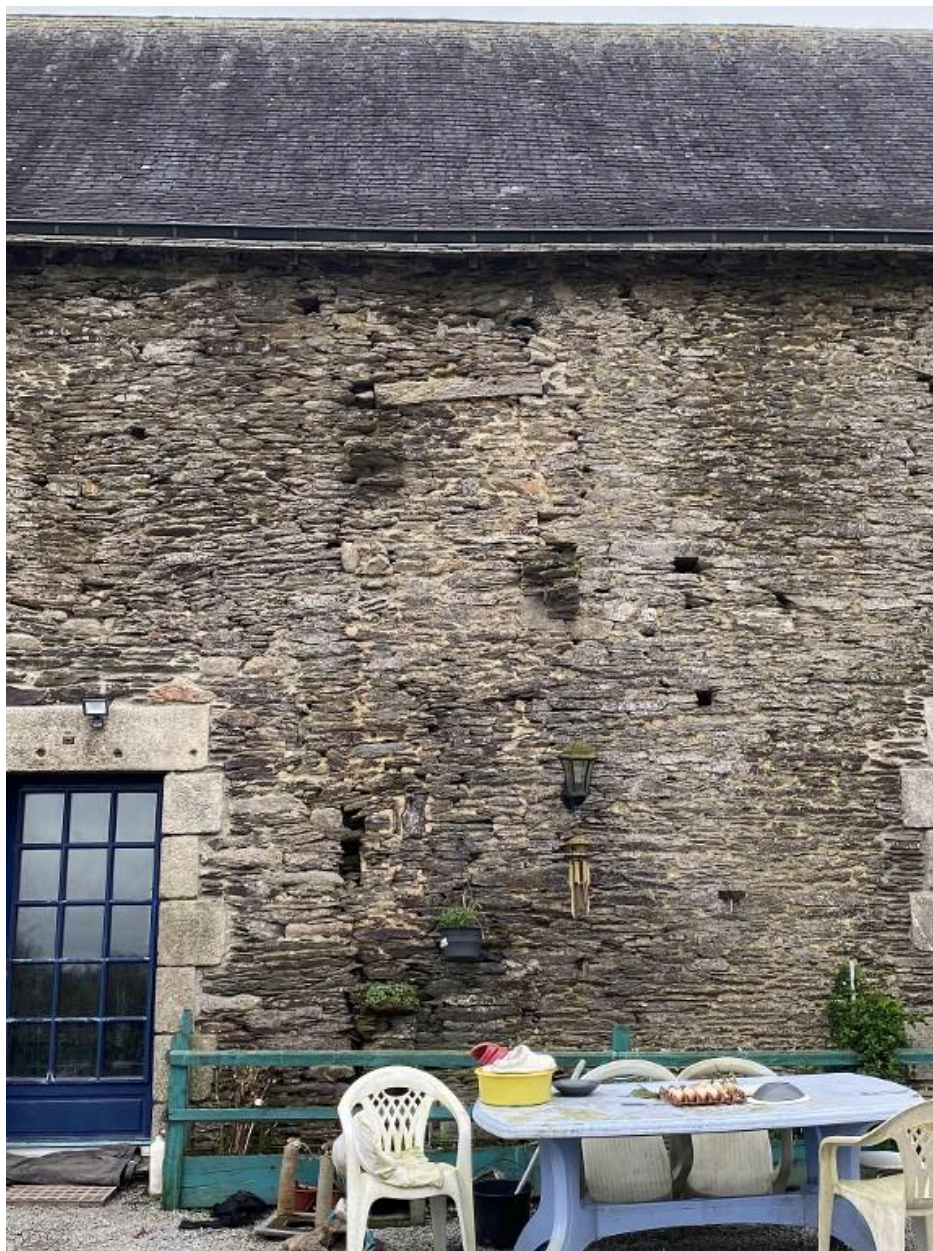
Aile nord, élévation nord, détail
