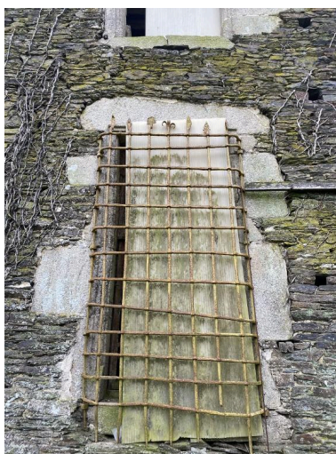
Élévation est, détail Phot. Baptiste Oligo IVR53_20265610224NUCA
