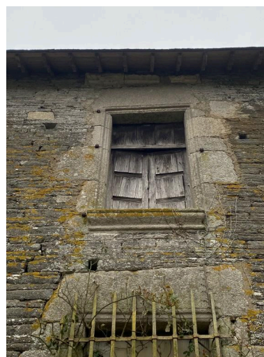
Façade ouest, détail Phot. Baptiste Oligo IVR53_20265610285NUCA
