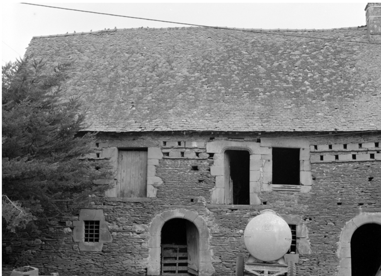
Dépendances nord, élévation sud.
