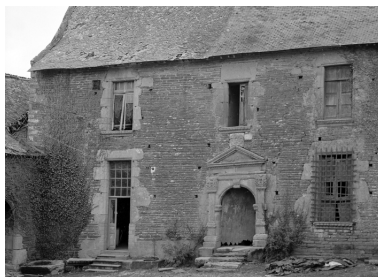
Élévation ouest. Phot. Jean-Pierre Ducouret IVR53_19845601905X
