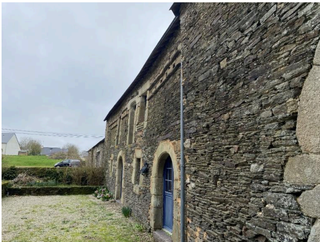
Aile nord, élévation sud
