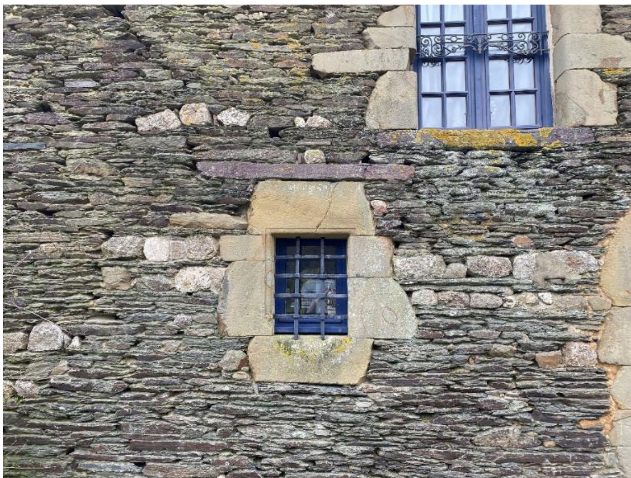
Aile nord, élévation sud, détail
