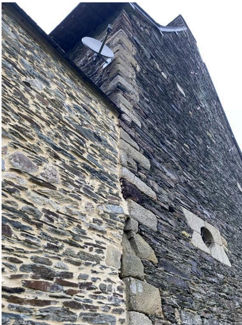
Chaînage d'angle, pignon sud
