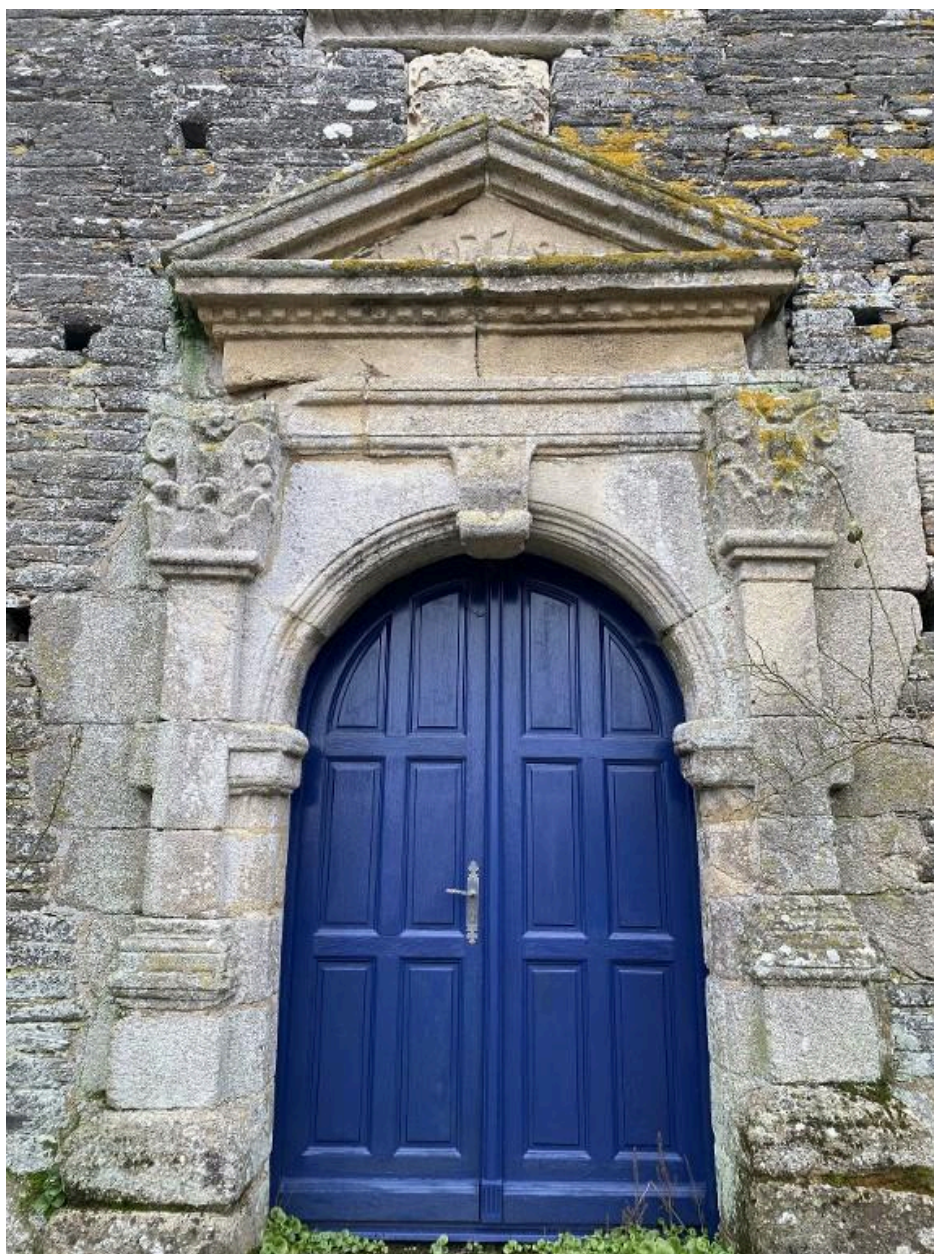
Porte, élévation ouest, détail
