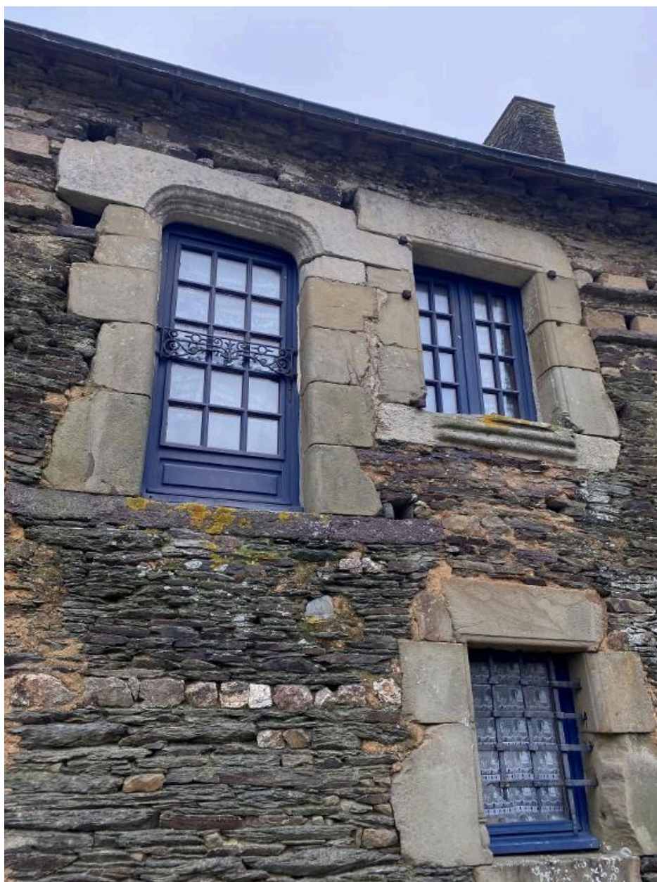
Aile nord, élévation sud, détail
