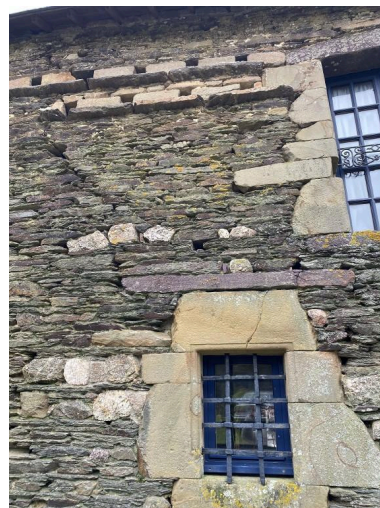
Aile nord, élévation sud, détail Phot. Baptiste Oligo IVR53_20265610247NUCA
