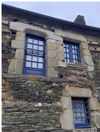
Aile nord, élévation sud, détail Phot. Baptiste Oligo IVR53_20265610249NUCA
