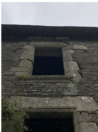
Élévation ouest, détail Phot. Baptiste Oligo IVR53_20265610234NUCA
