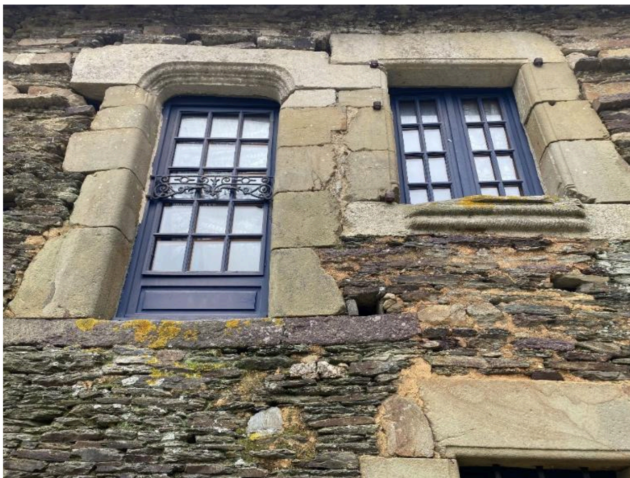
Aile nord, élévation sud, détail
