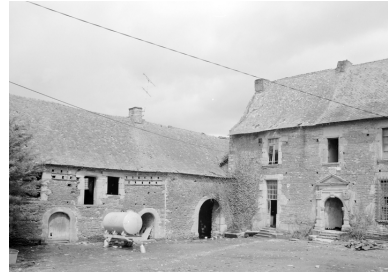
Élévation ouest et dépendance nord. Phot. Norbert Lambart IVR53_19855600301X
