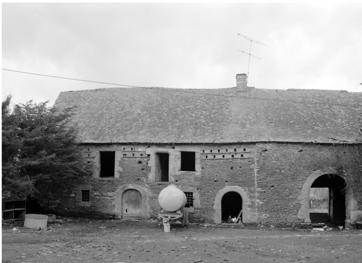
Dépendance nord, élévation sud.
