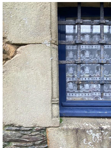
Aile nord, élévation sud, détail Phot. Baptiste Oligo IVR53_20265610254NUCA
