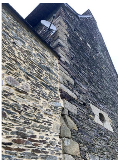
Chaînage d'angle, pignon sud Phot. Baptiste Oligo IVR53_20265610231NUCA
