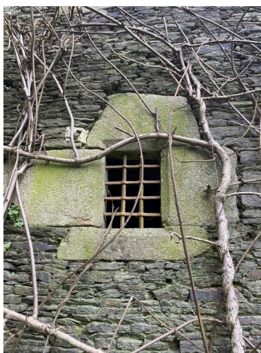
Élévation est, détail Phot. Baptiste Oligo IVR53_20265610275NUCA
