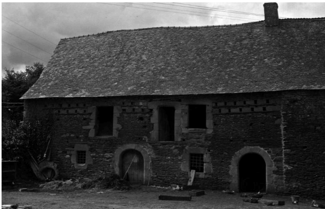
Manoir de la Cour : dépendances nord, élévation sud
