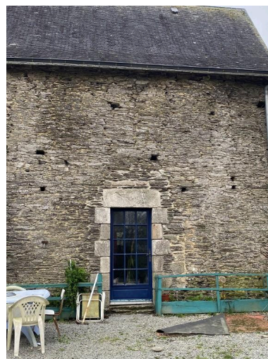
Aile nord, élévation nord, détail Phot. Baptiste Oligo IVR53_20265610260NUCA
