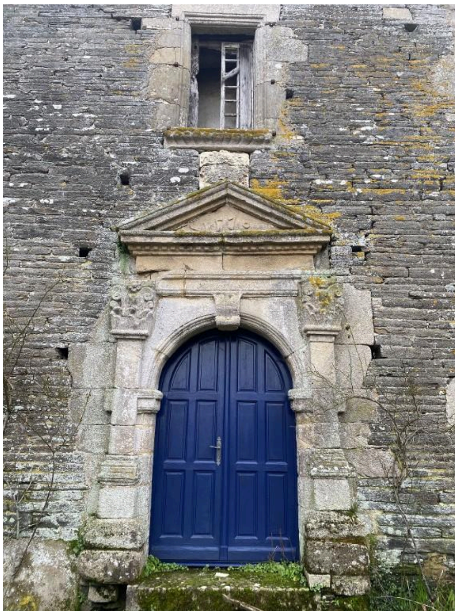
Porte, élévation ouest, détail
