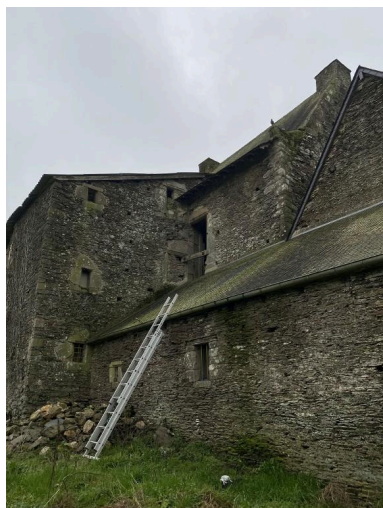
Élévation est, vue nord Phot. Baptiste Oligo IVR53_20265610227NUCA
