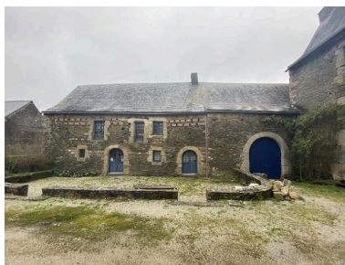
Aile nord, élévation sud, vue générale Phot. Baptiste Oligo IVR53_20265610243NUCA
