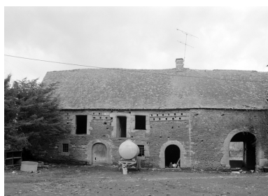
Dépendance nord, élévation sud. Phot. Norbert Lambart IVR53_19855600297X
