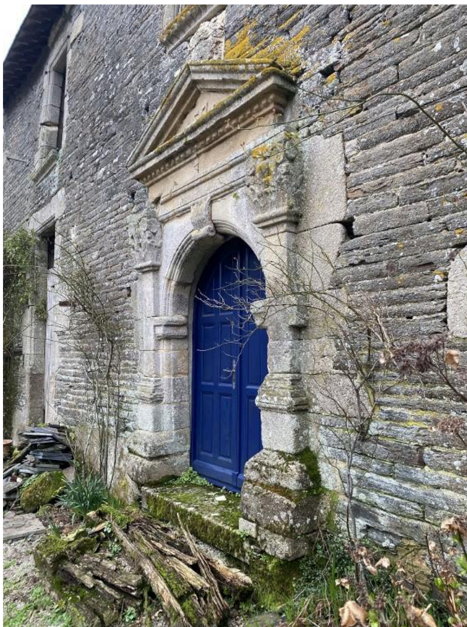
Porte, élévation ouest, détail
