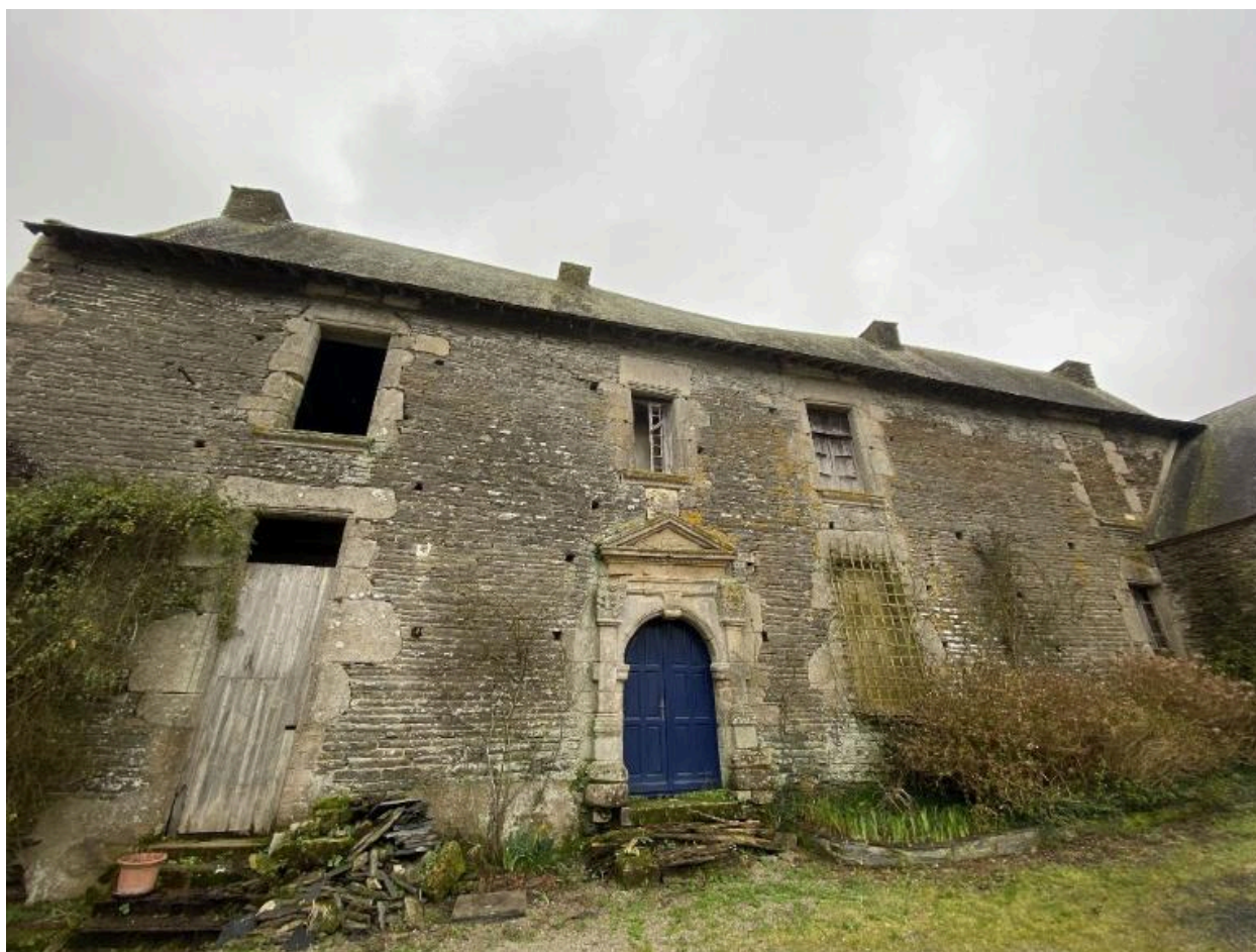
Façade ouest, vue générale
