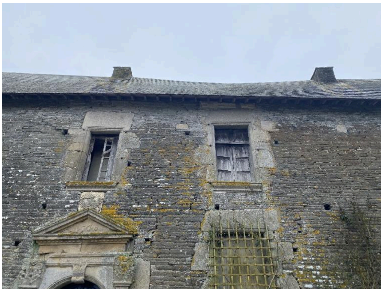
Élévation ouest, détail
