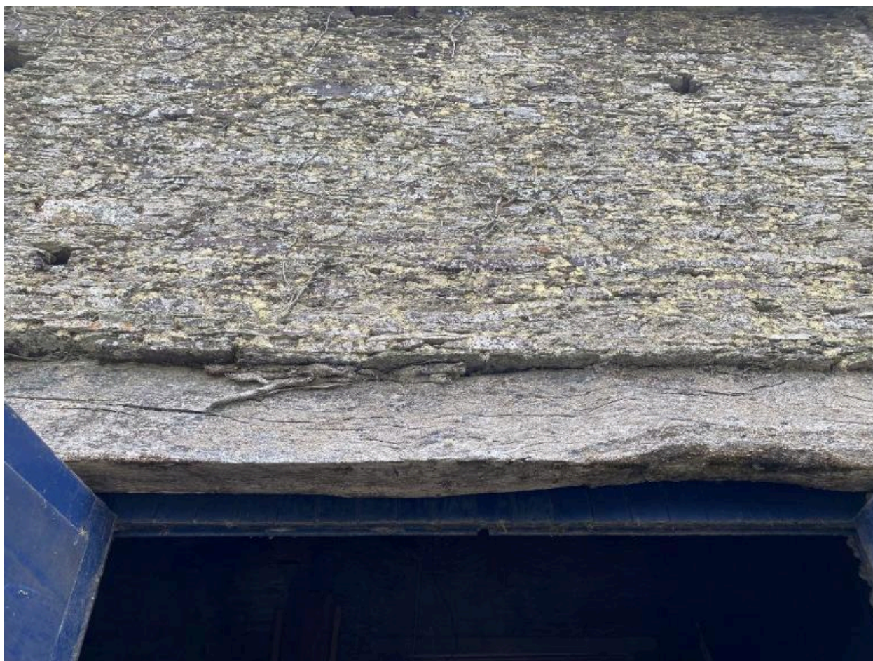
Larmier, aile nord, élévation nord
