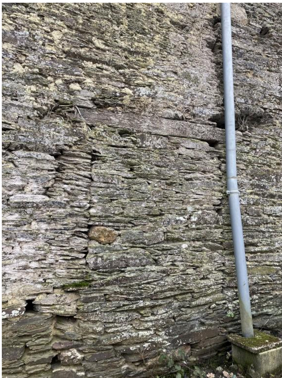
Aile nord, élévation nord, détail
