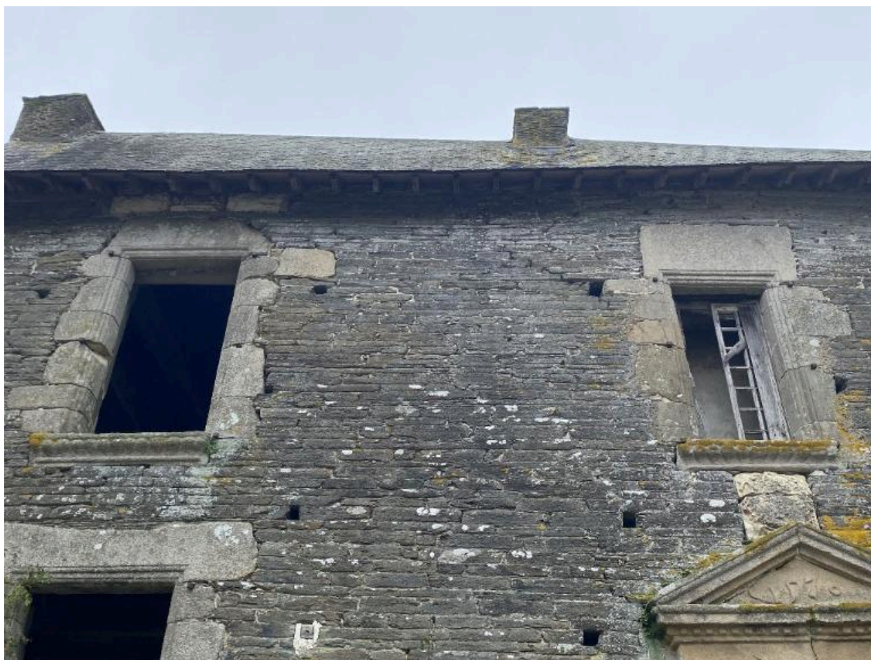
Élévation ouest, détail
