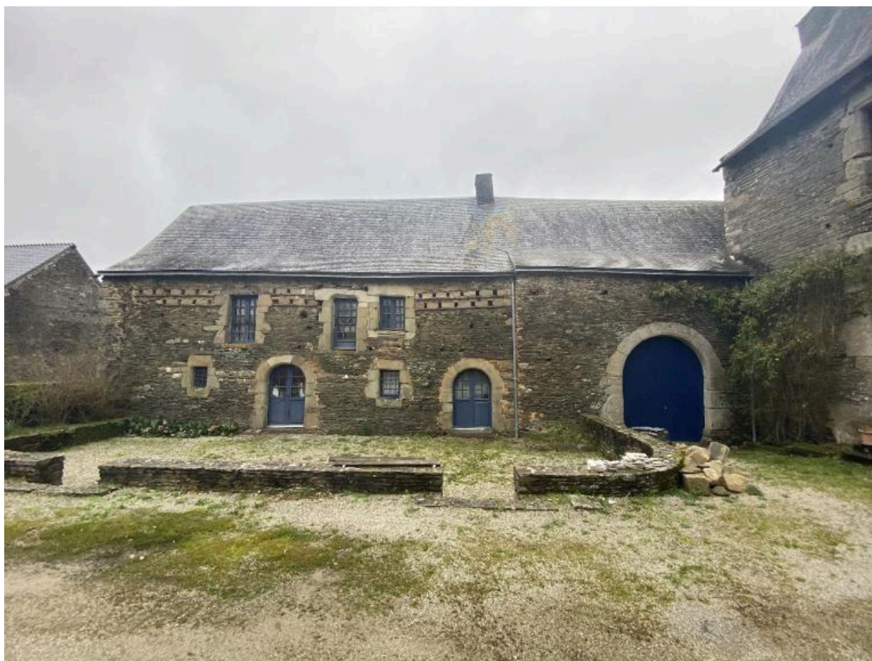
Aile nord, élévation sud, vue générale
