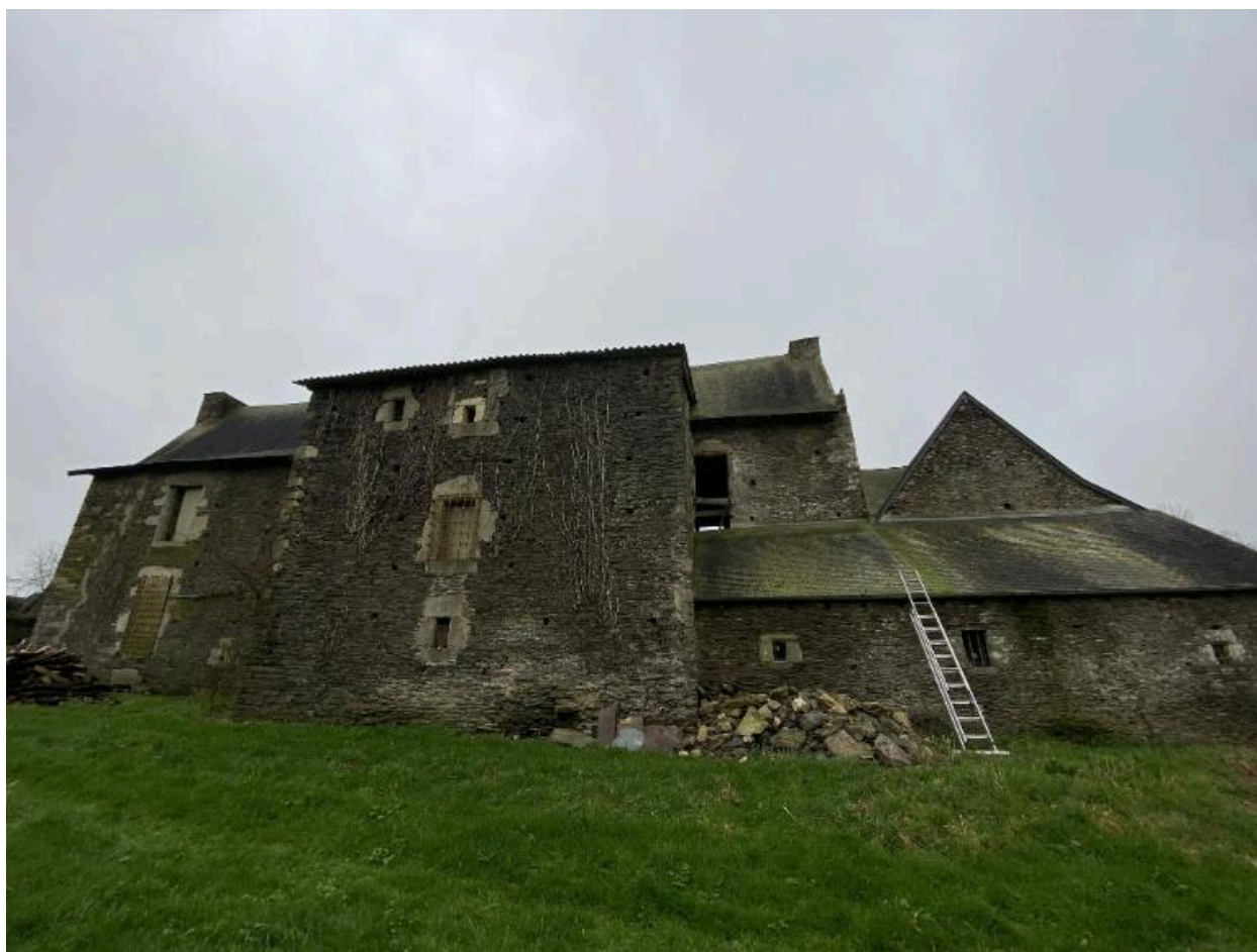
Élévation est, vue générale
