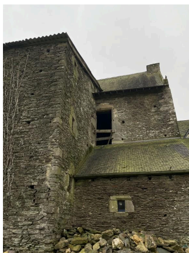
Élévation est, détail Phot. Baptiste Oligo IVR53_20265610278NUCA
