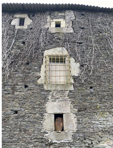
Élévation est, détail Phot. Baptiste Oligo IVR53_20265610277NUCA
