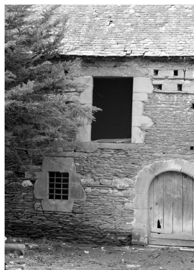
Dépendance nord, détail des baies. Phot. Norbert Lambart IVR53_19855600303X
