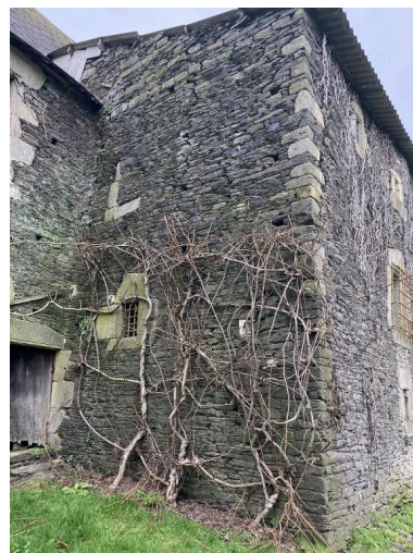
Élévation est, détail Phot. Baptiste Oligo IVR53_20265610219NUCA
