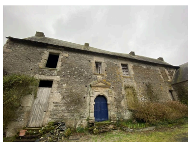
Façade ouest, vue générale Phot. Baptiste Oligo IVR53_20265610286NUCA
