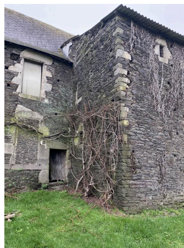
Élévation est, détail Phot. Baptiste Oligo IVR53_20265610272NUCA
