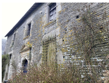
Élévation ouest Phot. Baptiste Oligo IVR53_20265610242NUCA
