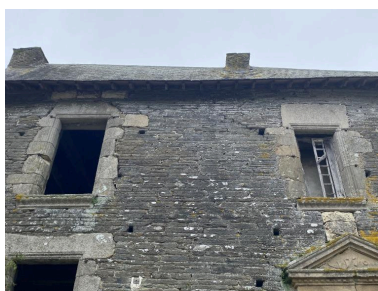
Élévation ouest, détail Phot. Baptiste Oligo IVR53_20265610186NUCA
