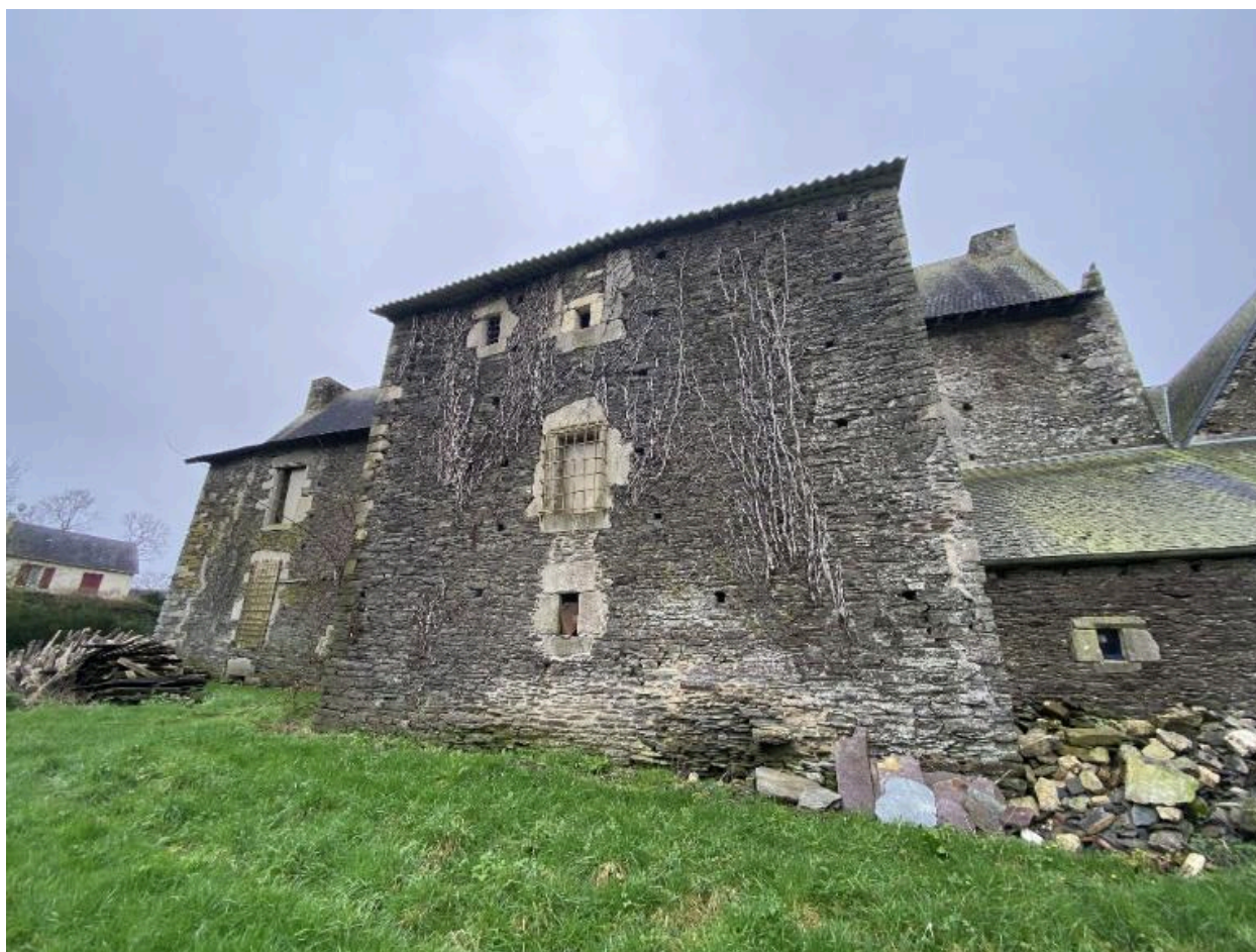
Élévation est, vue générale
