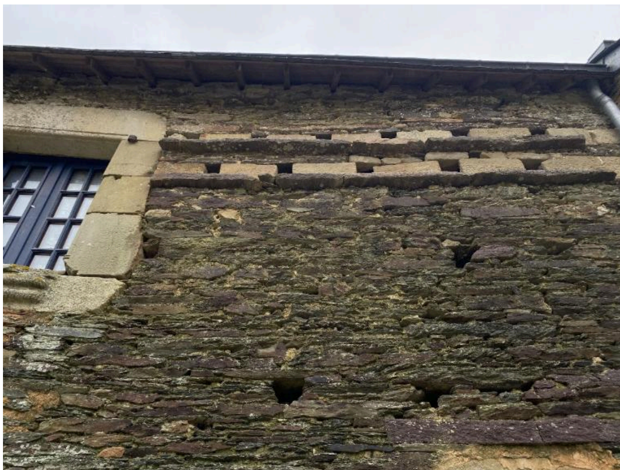
Aile nord, élévation sud, détail
