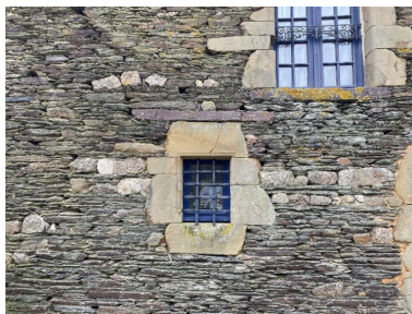
Aile nord, élévation sud, détail Phot. Baptiste Oligo IVR53_20265610250NUCA
