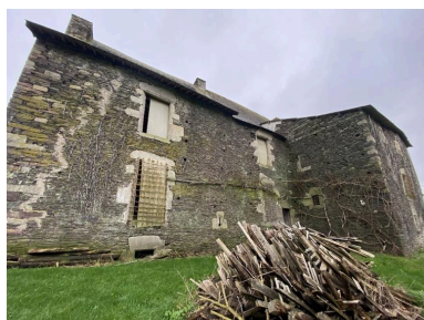
Élévation est, détail Phot. Baptiste Oligo IVR53_20265610271NUCA
