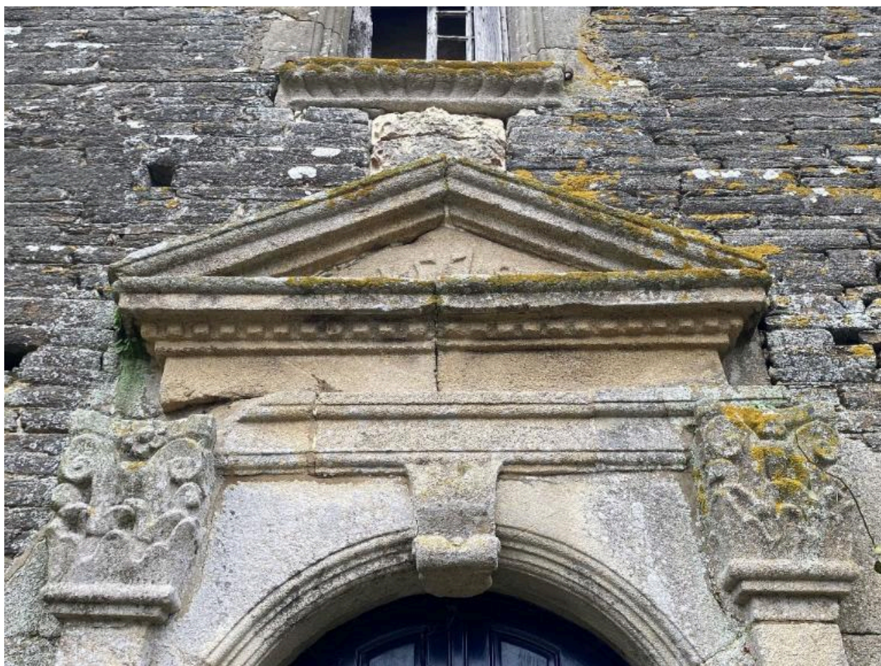
Porte, élévation ouest, détail
