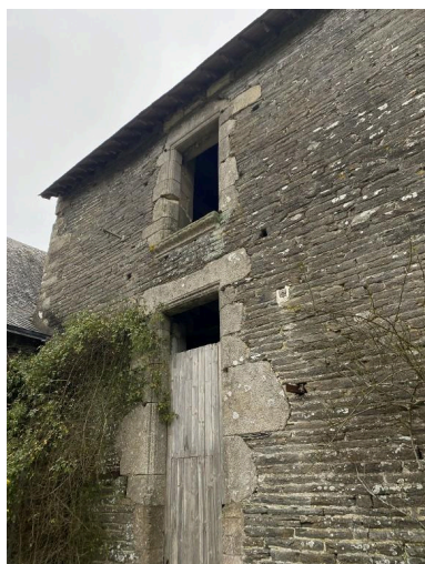
Élévation ouest, détail Phot. Baptiste Oligo IVR53_20265610192NUCA
