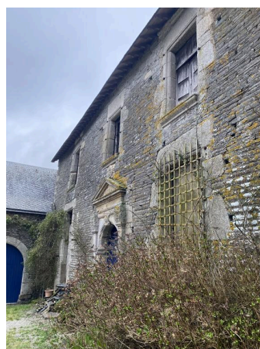
Élévation ouest Phot. Baptiste Oligo IVR53_20265610191NUCA
