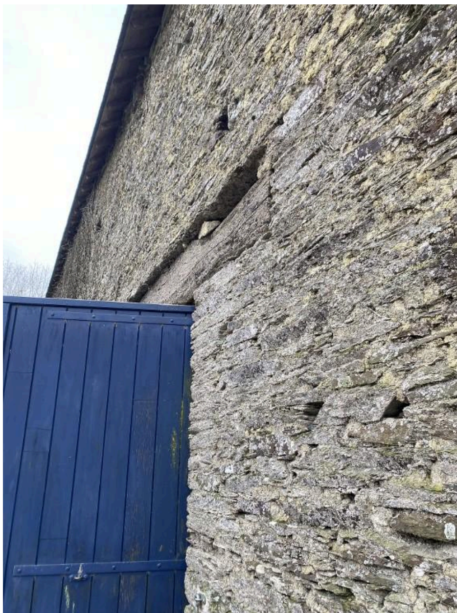
Larmier, aile nord, élévation nord
