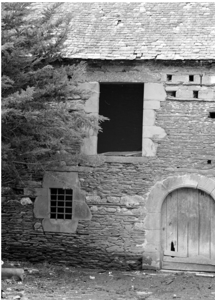
Dépendance nord, détail des baies.
