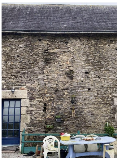
Aile nord, élévation nord, détail Phot. Baptiste Oligo IVR53_20265610208NUCA
