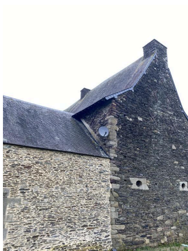
Chaînage d'angle, pignon sud Phot. Baptiste Oligo IVR53_20265610283NUCA
