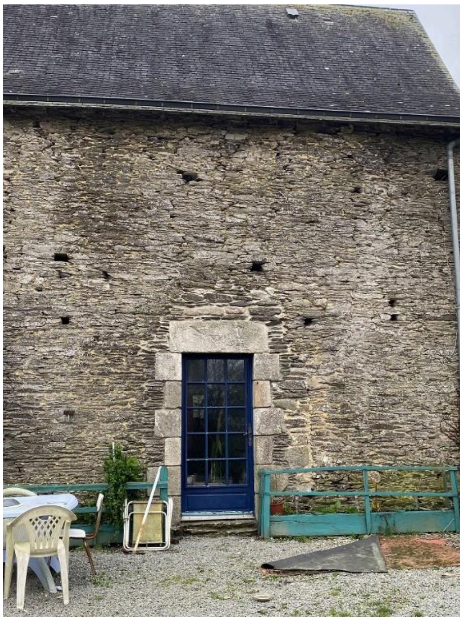
Aile nord, élévation nord, détail
