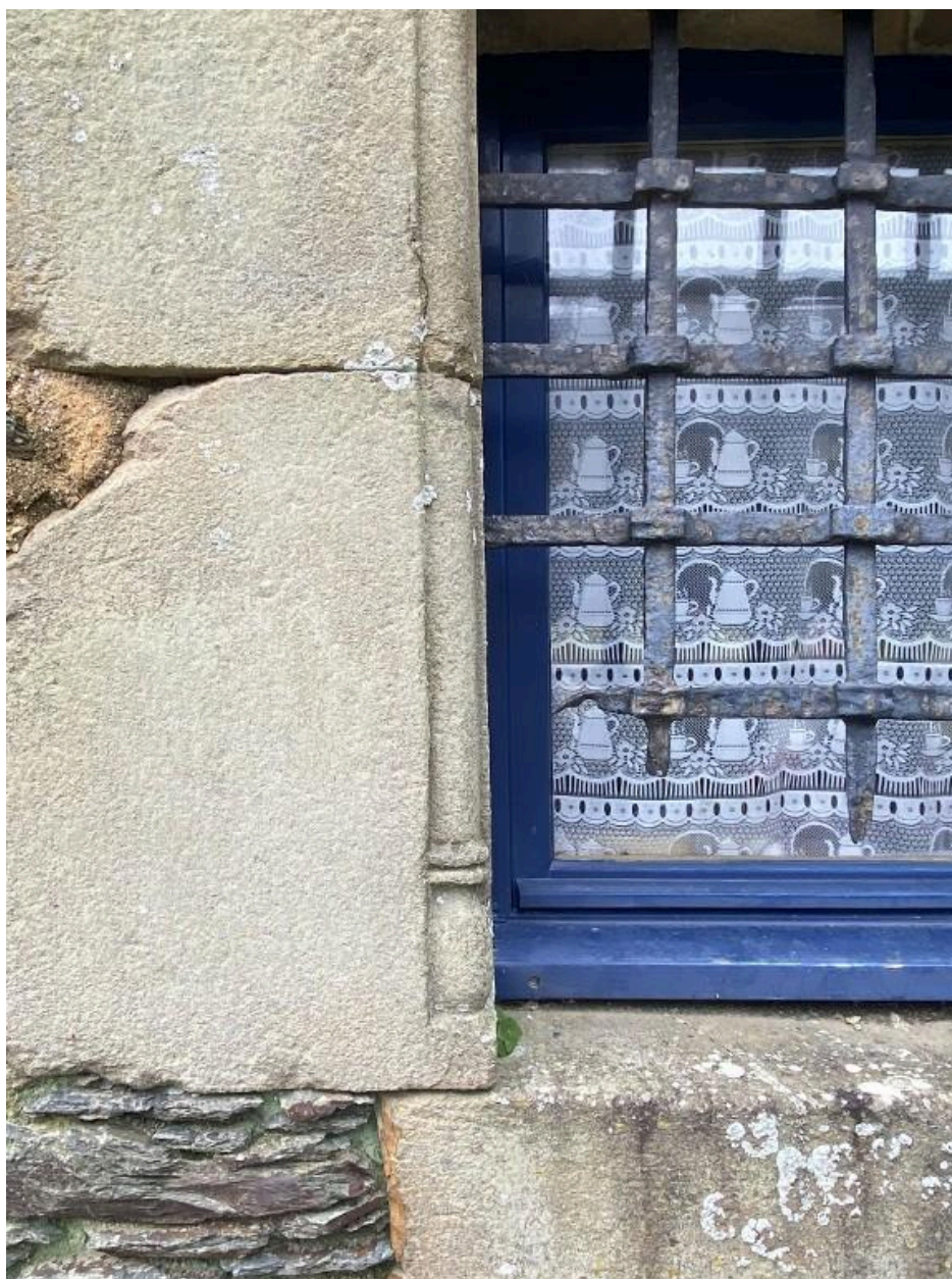
Aile nord, élévation sud, détail
