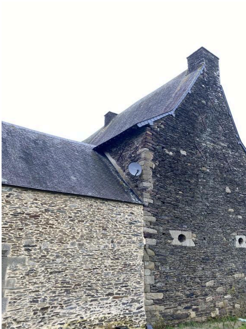
Chaînage d'angle, pignon sud
