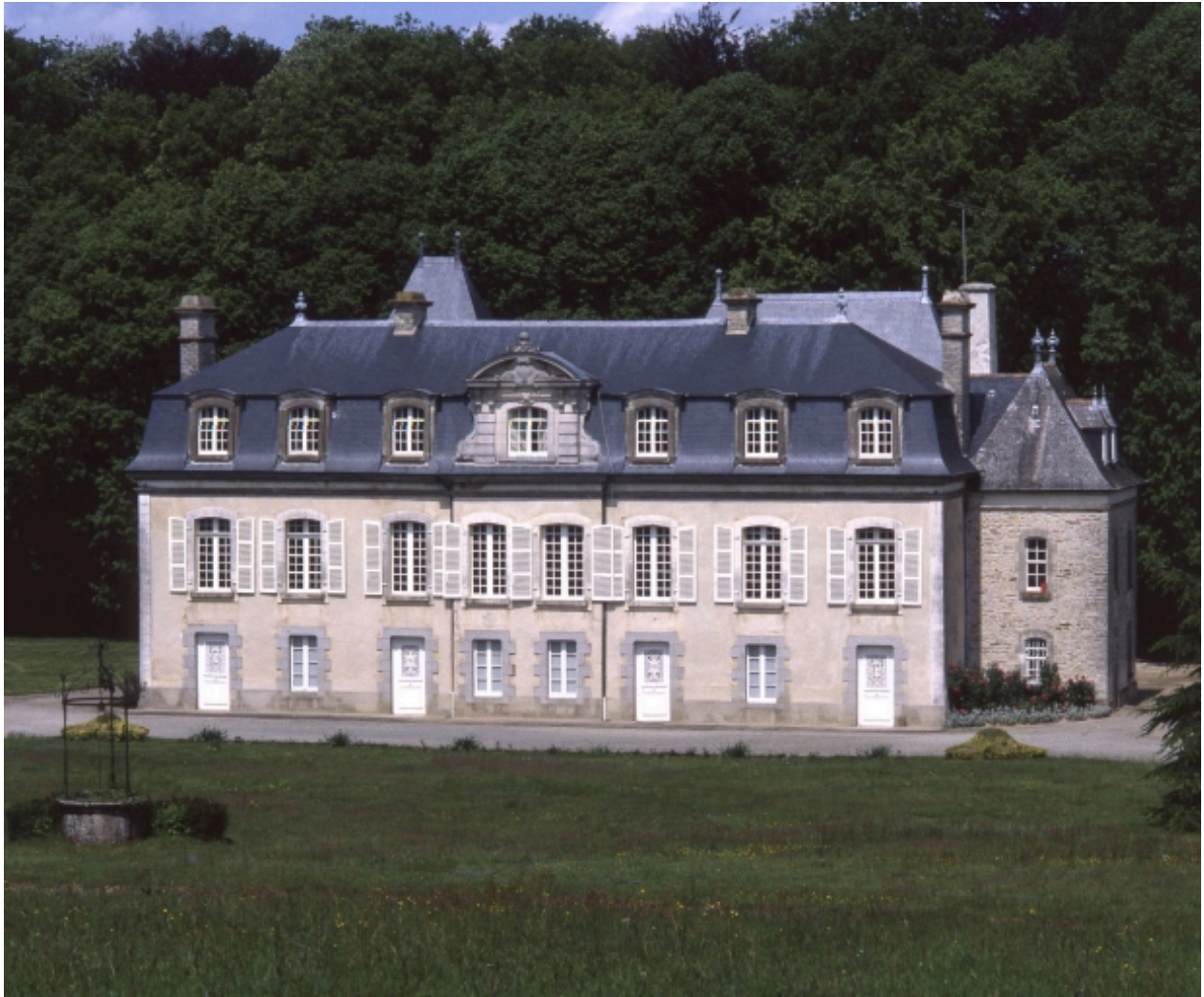
Vue générale de la façade antérieure
