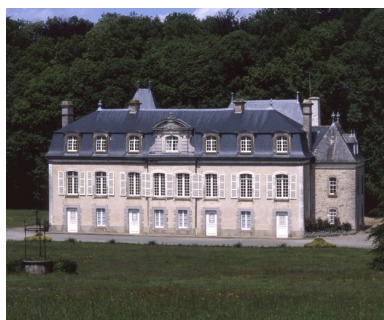
Vue générale de la façade antérieure
