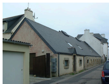
Vue arrière de l'ancienne conserverie Phot. Julien Amghar IVR53_20062908645NUCA
