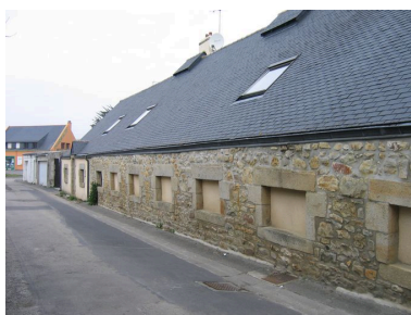
Vue arrière de l'ancienne conserverie Phot. Françoise Péron IVR53_20062908647NUCA
