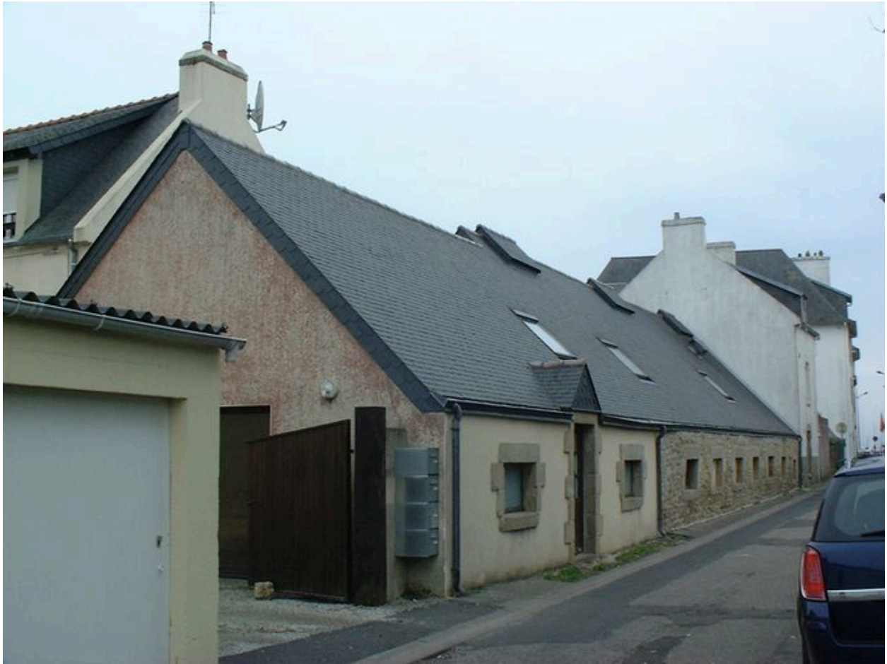
Vue arrière de l'ancienne conserverie
