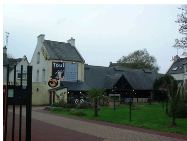
Vue générale avant de l'ancienne conserverie Phot. Julien Amghar IVR53_20062908646NUCA
