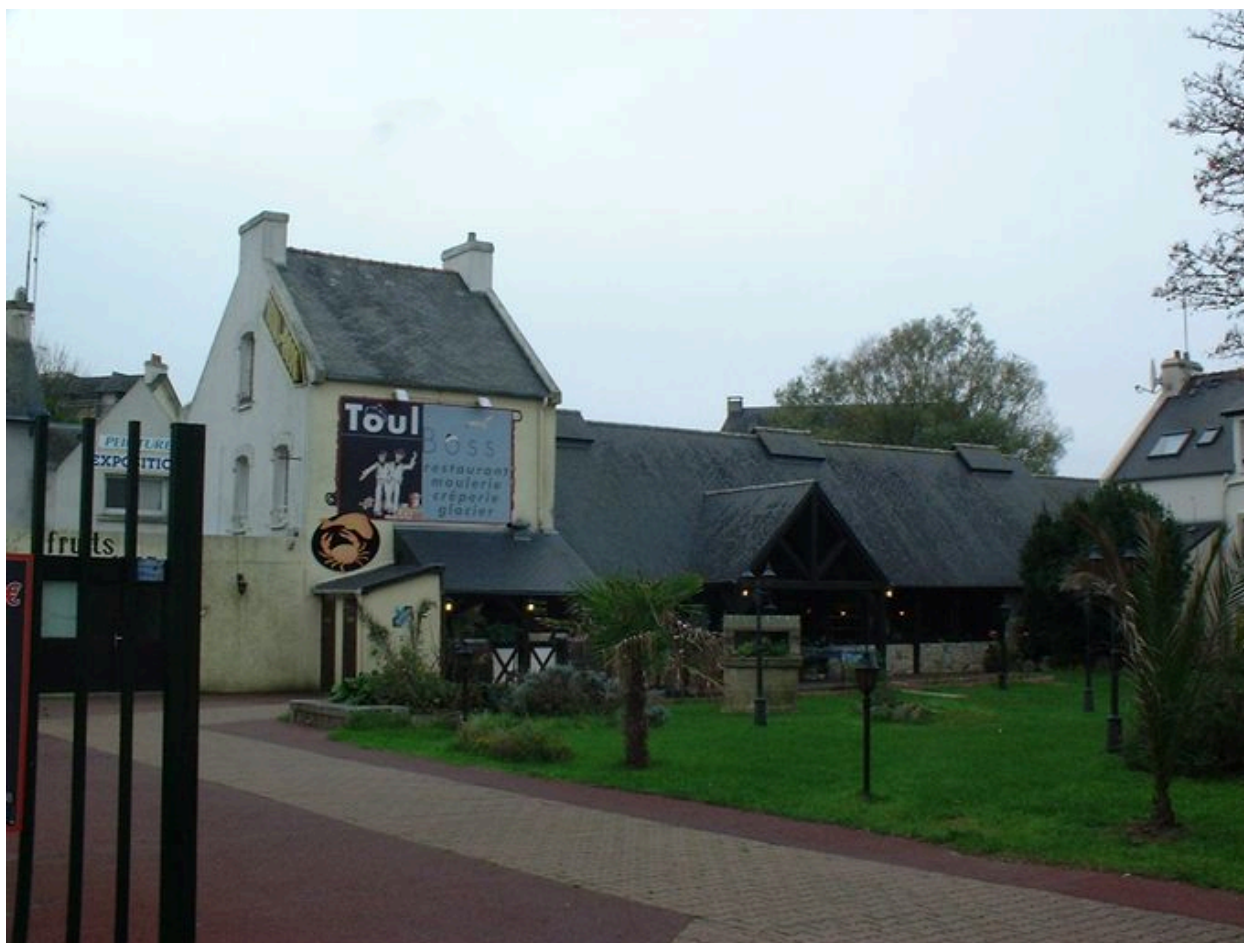
Vue générale avant de l'ancienne conserverie
