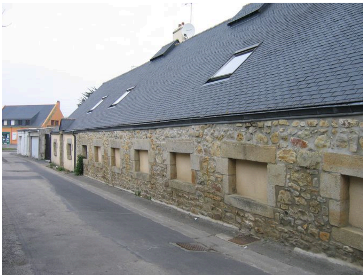
Vue arrière de l'ancienne conserverie
