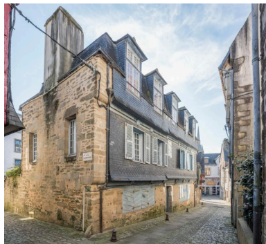
Ensemble du bâtiment à gouttereau sur rue. Le pignon intègre plusieurs conduits de cheminée dans sa maçonnerie. Phot. Charlotte Barraud IVR53_20252900699NUCA
