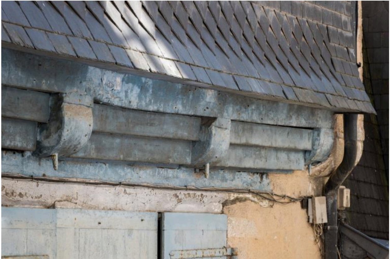
Encorbellement avec entretoises en escalier.
