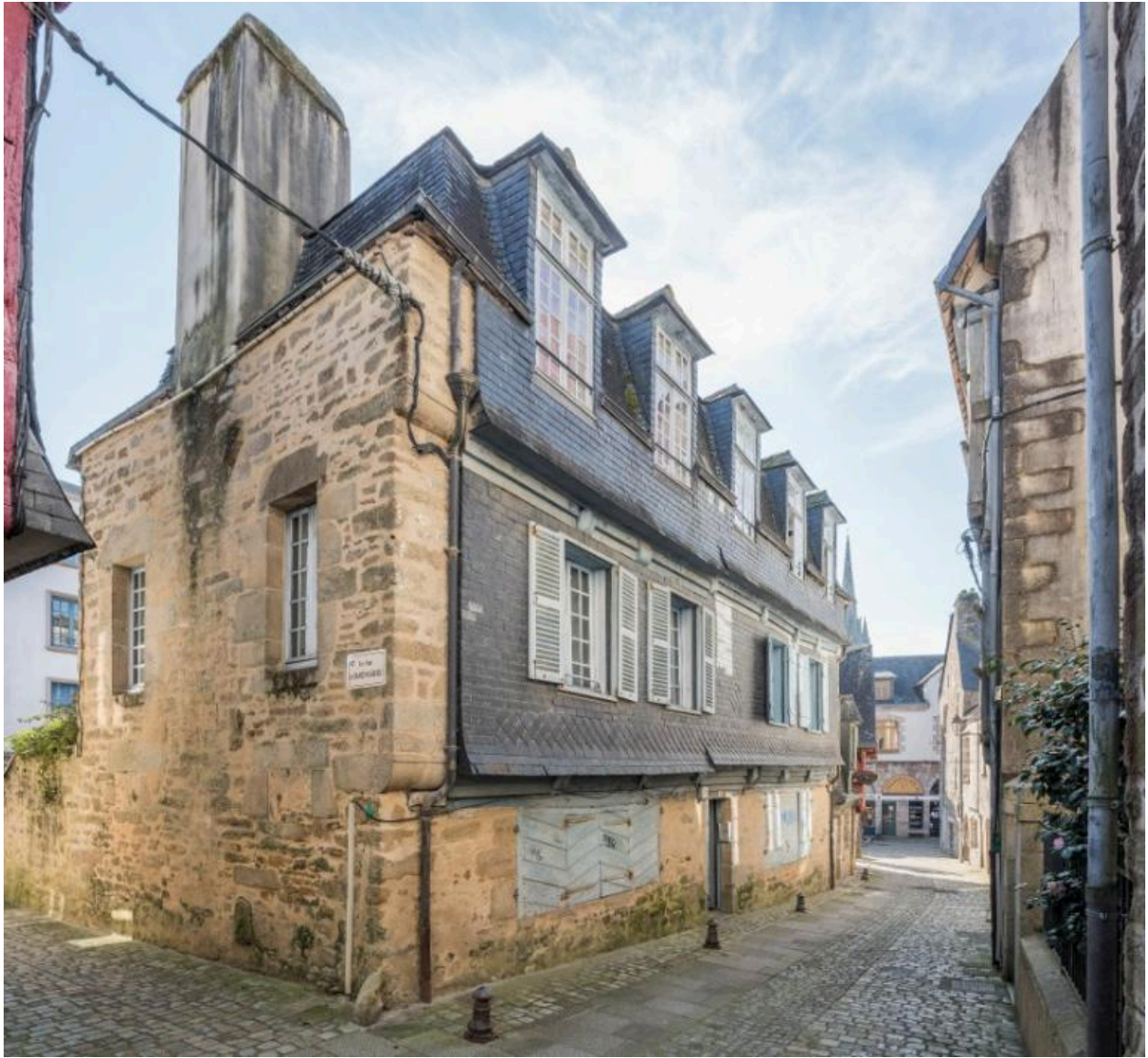
Ensemble du bâtiment à gouttereau sur rue. Le pignon intègre plusieurs conduits de cheminée dans sa maçonnerie.
