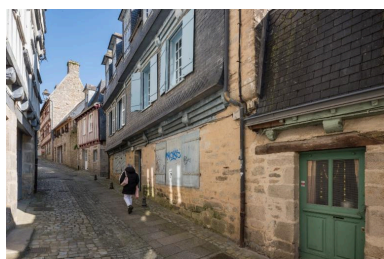
L'étage, caché sous un essentage d'ardoises, est en pan de bois en encorbellement. Phot. Charlotte Barraud IVR53_20252900703NUCA
