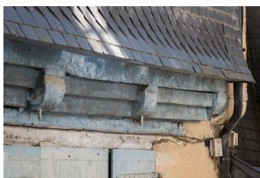
Encorbellement avec entretoises en escalier. Phot. Charlotte Barraud IVR53_20252900706NUCA
