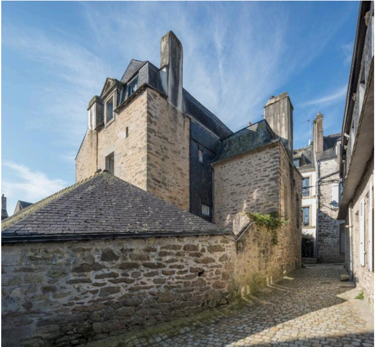
Façade arrière ; l'essentage d'ardoises cache probablement une partie en pan de bois.
