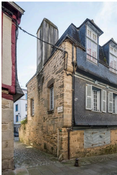
Le mur à ressauts accompagne l'encorbellement de l'étage et du surcroît. Phot. Charlotte Barraud IVR53_20252900700NUCA
