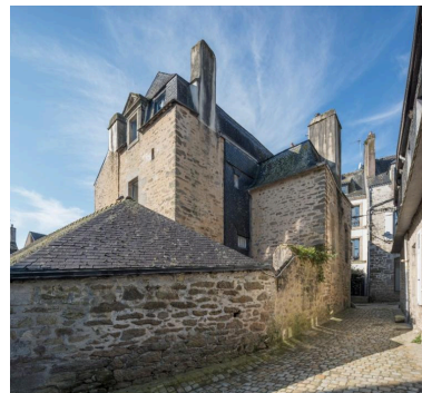
Façade arrière ; l'essentage d'ardoises cache probablement une partie en pan de bois. Phot. Charlotte Barraud IVR53_20252900701NUCA
