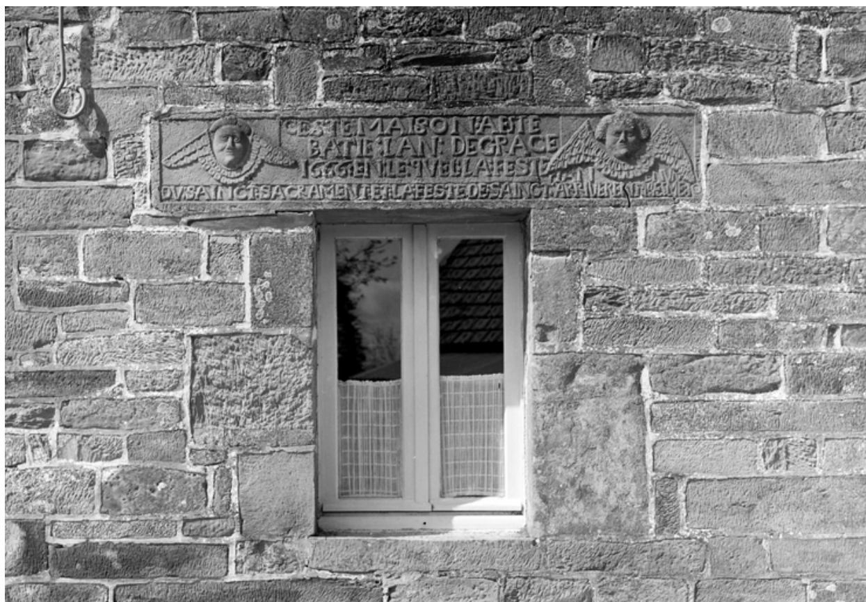
Maison A : vue du linteau
