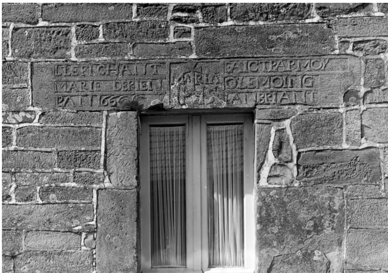
Maison A : vue du linteau
