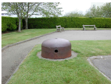
Vue de la cloche blindée de type 486P2 (état en 2002) Phot. Guillaume Lécueillier IVR53_20022902924NUCA
