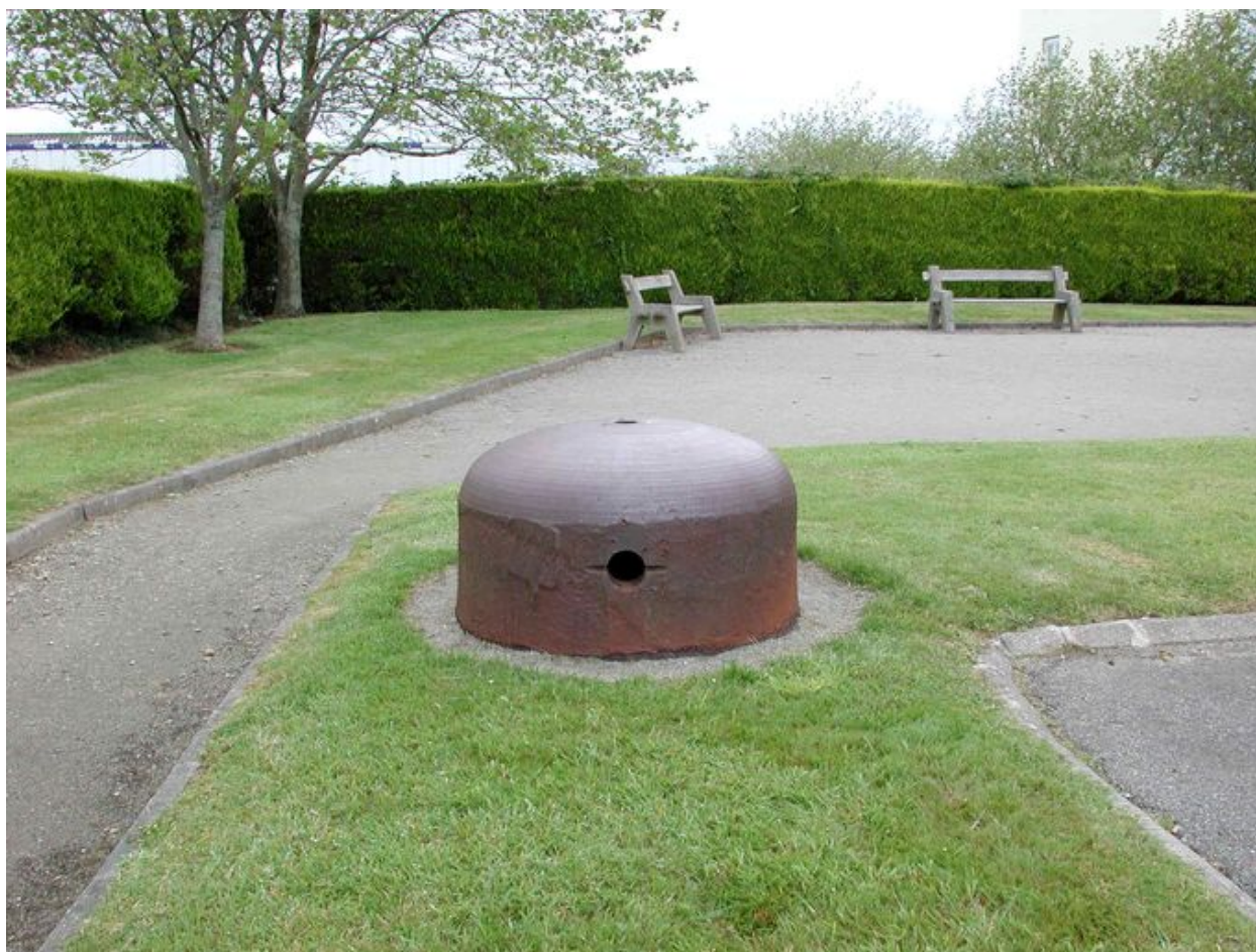
Vue de la cloche blindée de type 486P2 (état en 2002)
