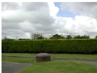
Vue de la cloche blindée de type 486P2 (état en 2002) Phot. Guillaume Lécueillier IVR53_20022902925NUCA
