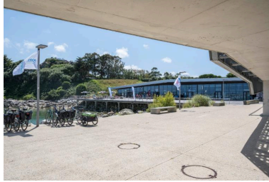
Espace commercial du port de plaisance de Roscoff Phot. Charlotte Barraud IVR53_20252901091NUCA
