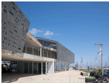
Espace commercial du port de plaisance de Roscoff Phot. Charlotte Barraud IVR53_20252901095NUCA
