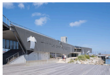
Espace commercial du port de plaisance de Roscoff Phot. Charlotte Barraud IVR53_20252901101NUCA
