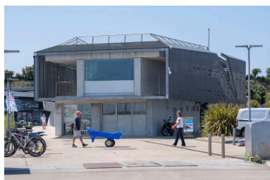
Espace commercial du port de plaisance de Roscoff Phot. Charlotte Barraud IVR53_20252901104NUCA
