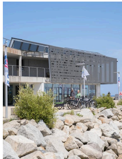
Espace commercial du port de plaisance de Roscoff Phot. Charlotte Barraud IVR53_20252901103NUCA
