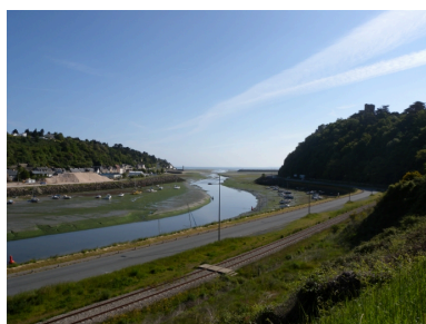
L'embouchure du port du Légué : vue des rails de la voie de chemin de fer, rive droite, quai Surcouf, et de la tour de Cesson (menacée)
