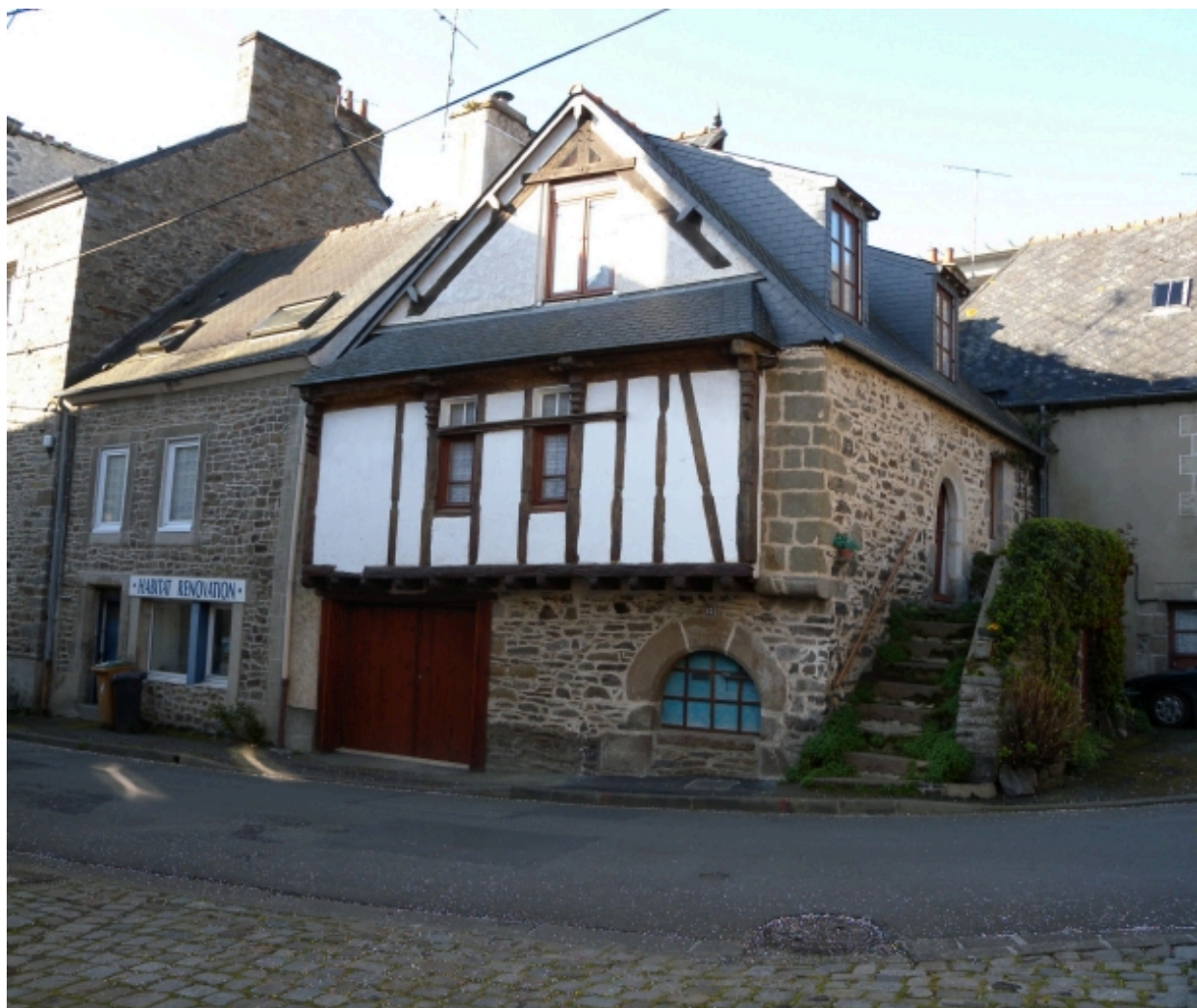
Vue générale d'une maison traditionnelle du Légué, datée du 17ème siècle
