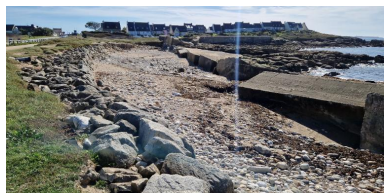
Vue générale vers le sud depuis le milieu de la grève. Des sections de mur sont couchées sur la grève du côté de la mer Phot. Guillaume Lécueillier IVR53_20265610146NUCA
