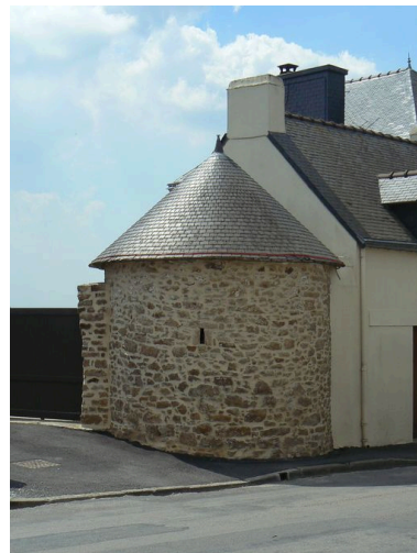
Tourelle de la maison du 9 rue de Cariel Phot. Johan Vincent IVR53_20075605696NUCA
