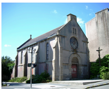
Chapelle Notre-Dame-de-Lourdes : vue générale nord-est Phot. Gwénaél Fauchille IVR53_20082906047NUCA
