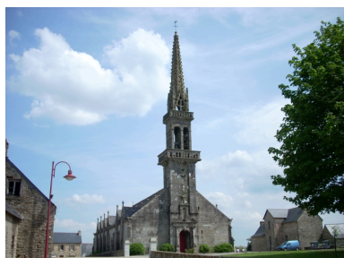
Plouyé, église paroissiale Saint-Joseph : vue générale nord-ouest Phot. Gwénaél Fauchille IVR53_20082905845NUCA
