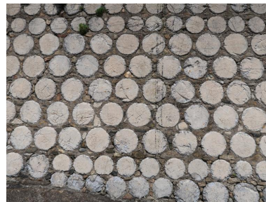
Mise en oeuvre des barils de ciment dans le quai à usage de soutènement de la route et protection du littoral Phot. Erwana L'Haridon IVR53_20242910955NUCA
