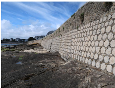
Quai russe : barils de ciment intégrés à la maçonnerie Phot. Erwana L'Haridon IVR53_20242910956NUCA
