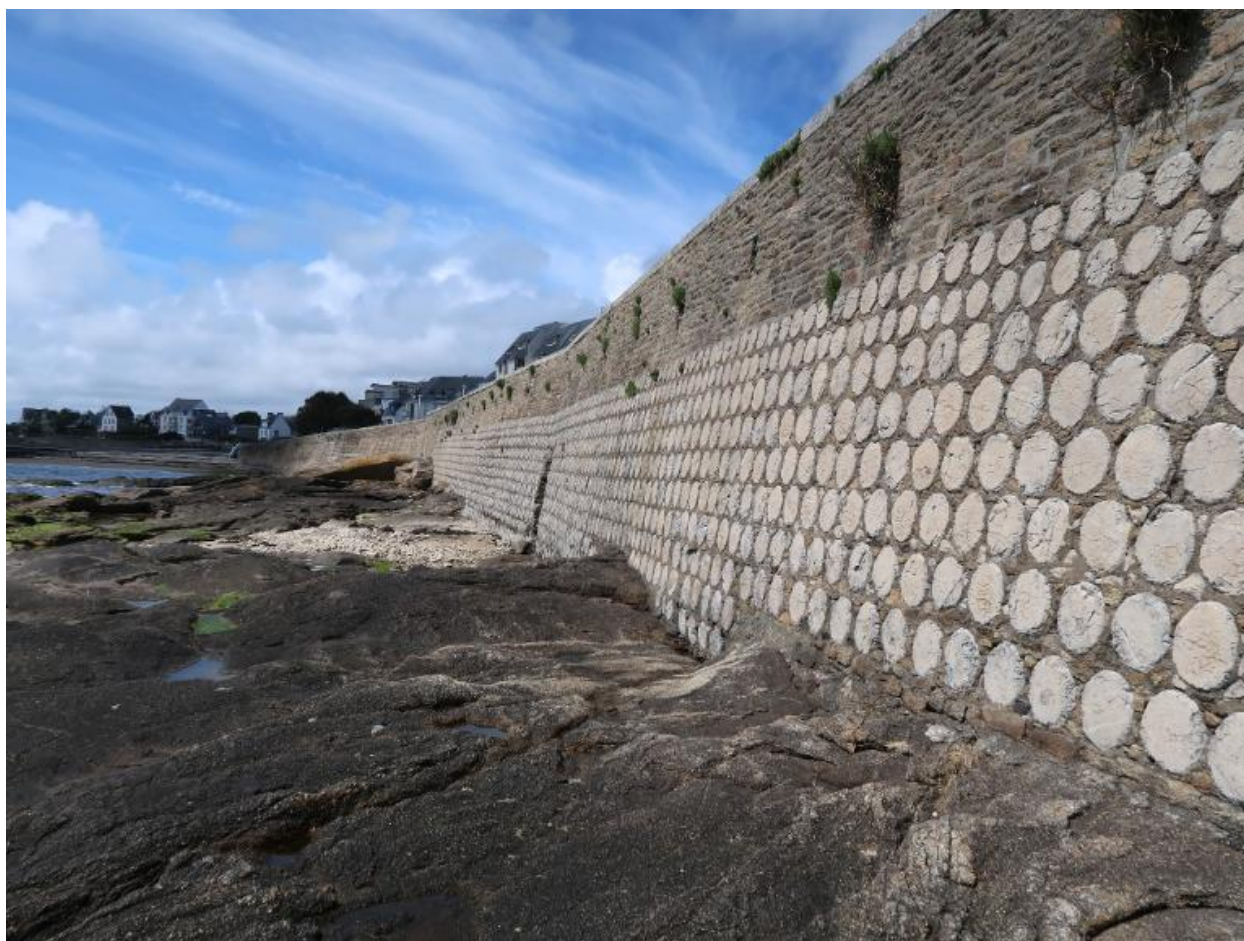
Quai russe : barils de ciment intégrés à la maçonnerie
