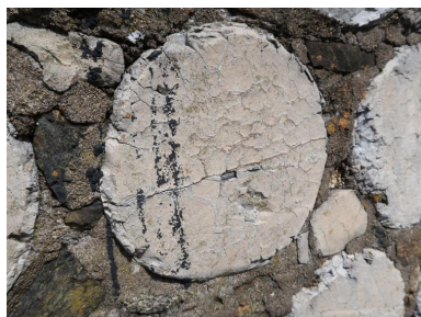
Quai russe : vue rapprochée du ciment sous forme de baril Phot. Erwana L'Haridon IVR53_20242910957NUCA
