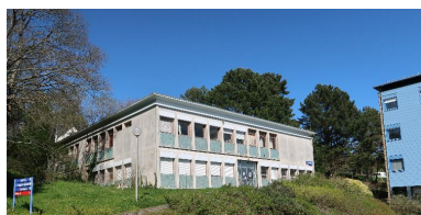
L'ancienne infirmerie, aujourd'hui occupée par le Greta (bâtiment J). A droite, vue partielle du pignon de l'internat (G). Phot. Thierry Goyet IVR53_20183506352NUCA
