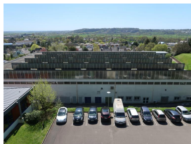
Vue des ateliers (E), prise du nord-est (bâtiment D).
