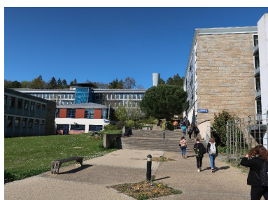
L'axe "central", à gauche les ateliers et l'externat E', à droite, le pignon paré de granite de l'externat C, au fond de la perspective, l'externat D.
