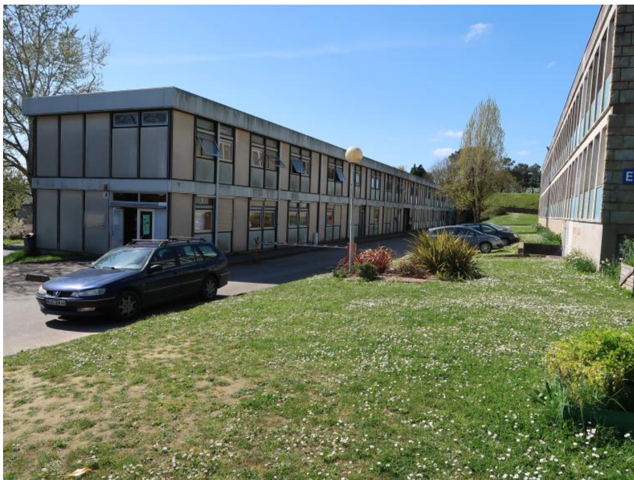
Bâtiment A, externat sciences de l'ingénieur. Classes modulables sur 2 niveaux.
