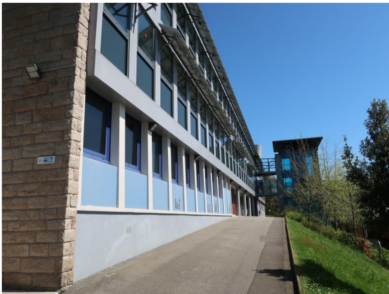
Façade sud-ouest du bâtiment D (externat) et ses adjonctions : isolation, panneaux solaires - brise-soleils et escalier-ascenseur, relié au bâtiment par des passerelles.
