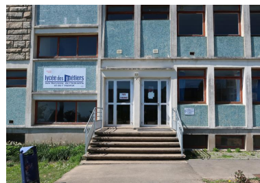
L'entrée des ateliers, sur la façade sud-est.
