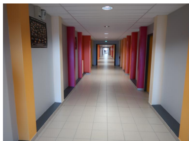
Couloir d'un externat. Les salles sont desservies, à chaque étage, par un couloir central dans lequel la structure du bâtiment (poteaux en béton armés) est apparente.
