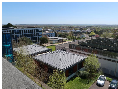
Vue d'ensemble depuis le toit de l'externat D : de gauche à droite : l'externat C, l'externat E' et les ateliers (E). Phot. Thierry Goyet IVR53_20183506349NUCA
