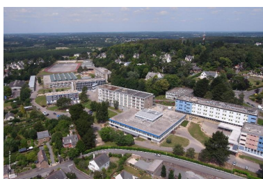
Vue aérienne du lycée. Au centre, le restaurant scolaire et l'externat F. A droite, le collège et l'internat (G). A l'arrière plan, les autres bâtiments du lycée et le plateau sportif. Phot. Panoramic Bretagne IVR53_20183506343NUCA
