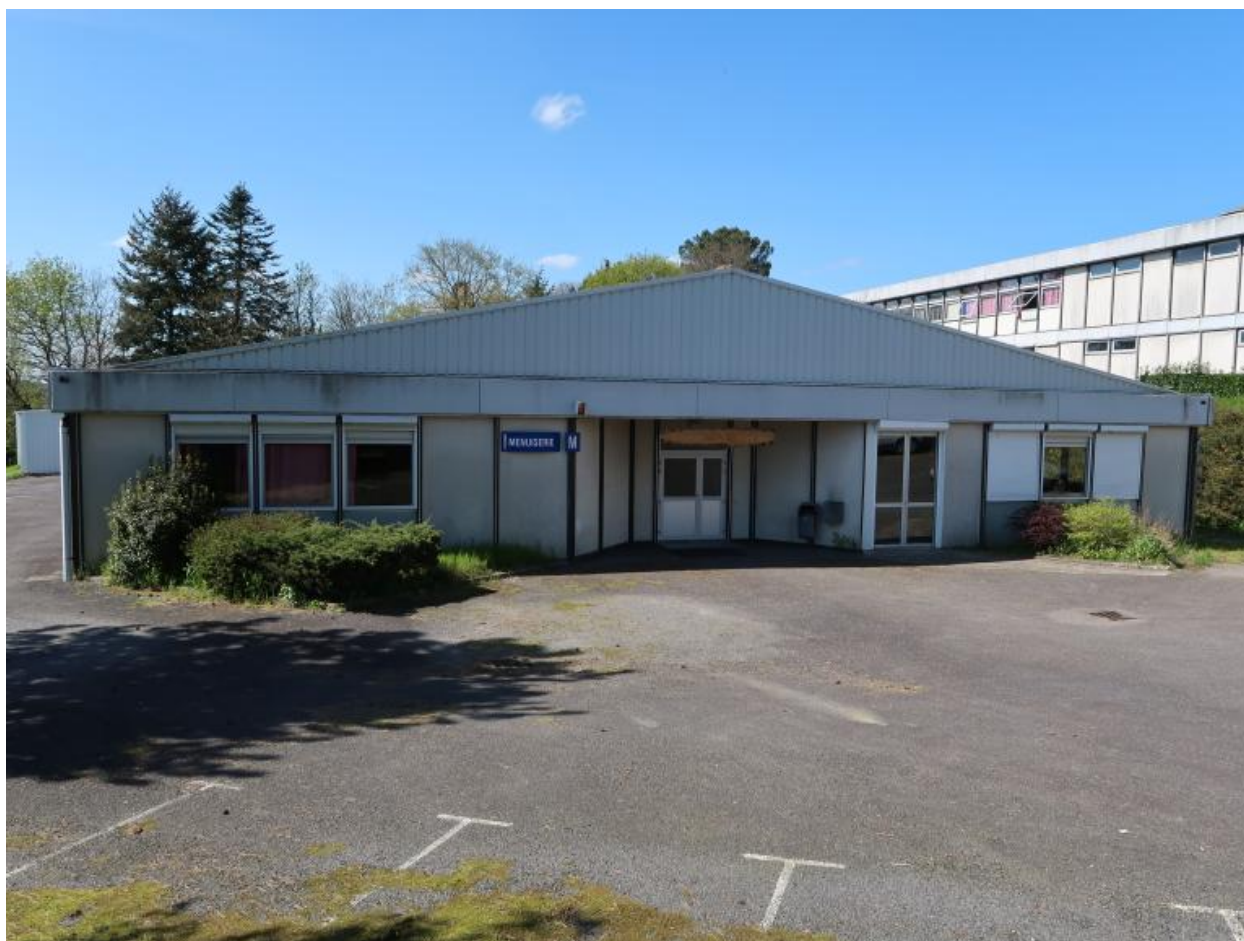
Bâtiment A : atelier menuiserie modulable.
