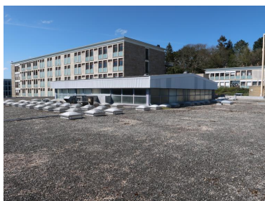
Le toit-terrasse du restaurant scolaire, le dispositif d'éclairage et d'extraction d'air des cuisines, façade sud du bâtiment F. A l'arrière plan, façade de l'ancienne infirmerie (bâtiment J), aujourd'hui Greta. Phot. Thierry Goyet IVR53_20193505619NUCA
