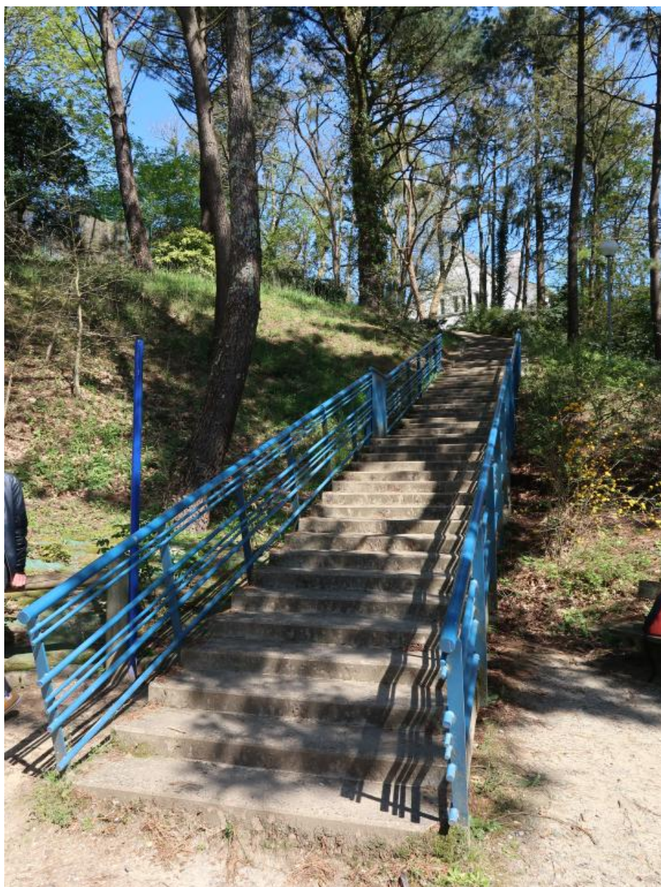
Escalier au nord du parc.
