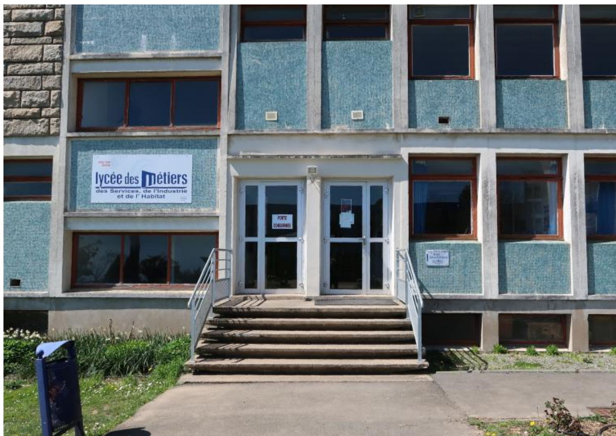
L'entrée des ateliers, sur la façade sud-est.
