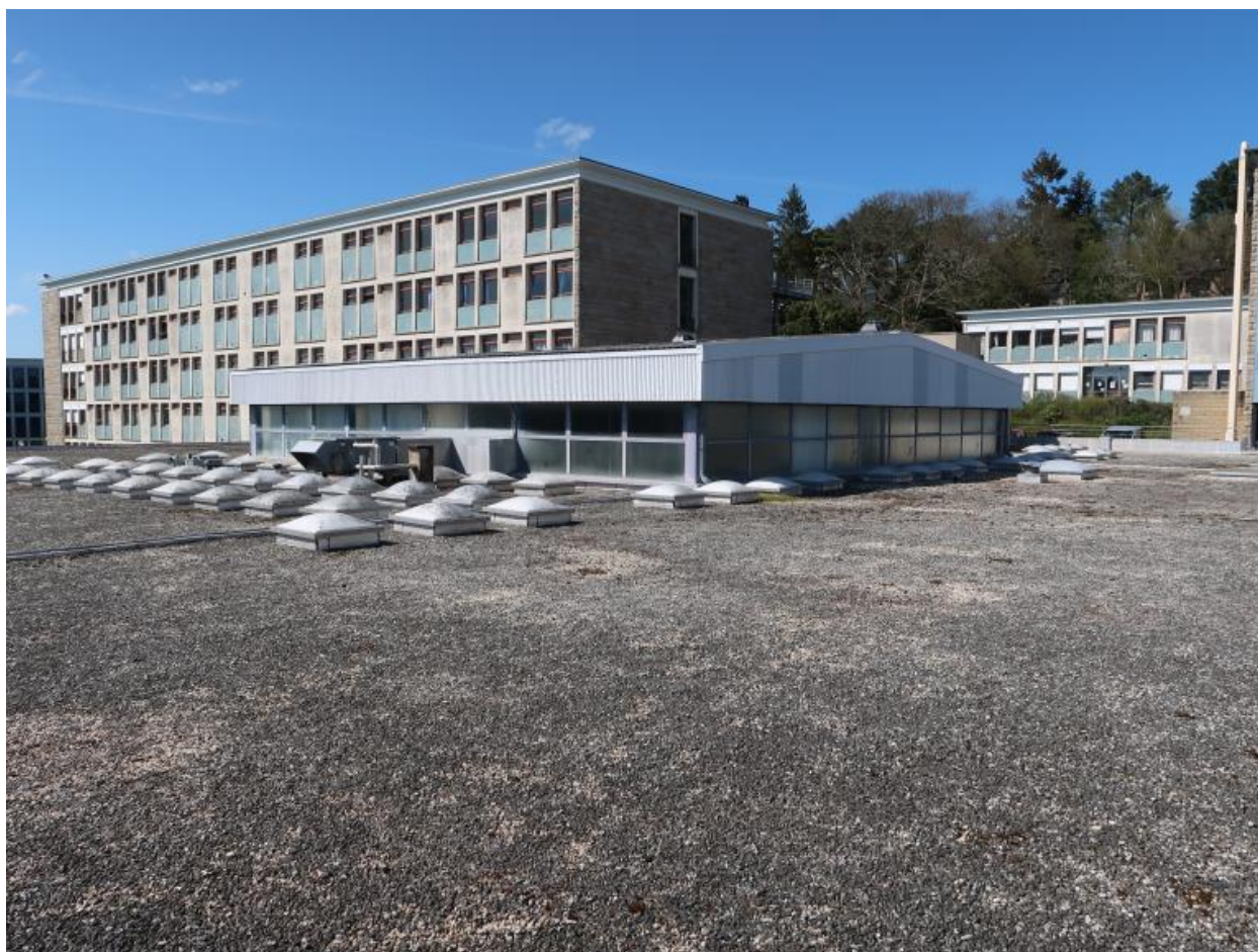
Le toit-terrasse du restaurant scolaire, le dispositif d'éclairage et d'extraction d'air des cuisines, façade sud du bâtiment F. A l'arrière plan, façade de l'ancienne infirmerie (bâtiment J), aujourd'hui Greta.
