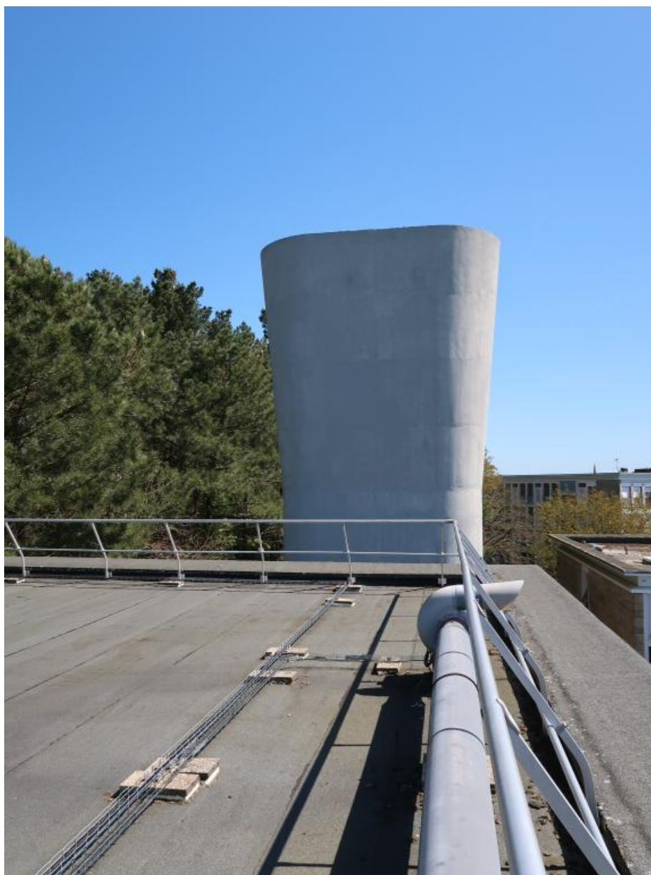
Cheminée de la chaufferie : à l'extrémité sud ouest du bâtiment D.
