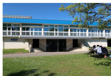
Façade sud du service de restauration. Les entrées des selfs, situées en rez-de-chaussée. Les trois côtés est, sud et ouest du restaurant scolaire sont intégralement vitrées et ouvrent sur un balcon continu. Phot. Thierry Goyet IVR53_20193505621NUCA
