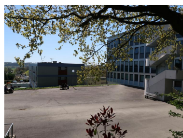
Façade sud-est du bâtiment C (externat) et son escalier extérieur. A l'arrière plan, le pignon nord- est du bâtiment B (logements).
