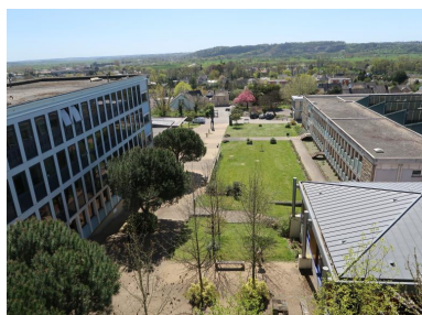
Vue de l'axe "central", prise du nord vers le sud, depuis le toit du bâtiment D. A gauche, l'externat C, à droite, la toiture du bâtiment E' et les ateliers. Phot. Thierry Goyet IVR53_20193505617NUCA
