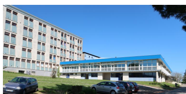
Le restaurant scolaire, façade ouest, et l'externat F. Phot. Thierry Goyet IVR53_20183506345NUCA
