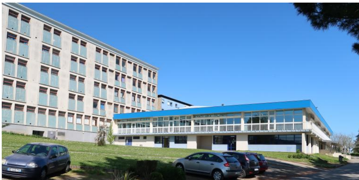
Le restaurant scolaire, façade ouest, et l'externat F.
