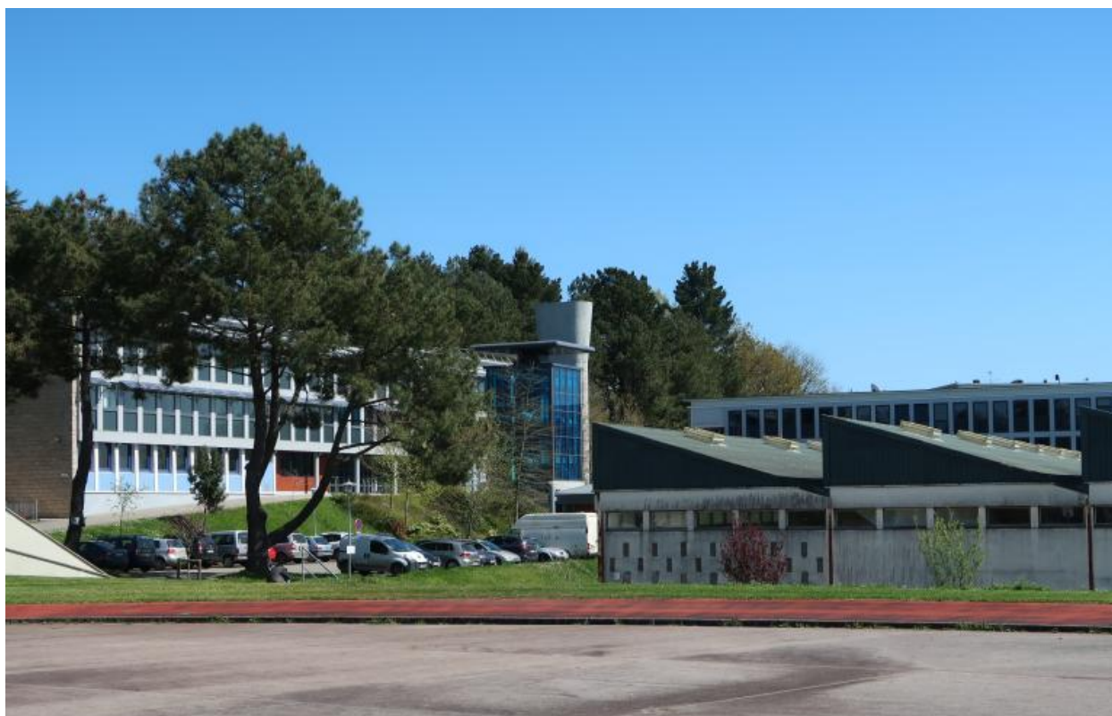
Façade du bâtiment D (externat), vue partielle des atelier (E) et à l'arrière façade du bâtiment C. Vue prise du plateau sportif.
