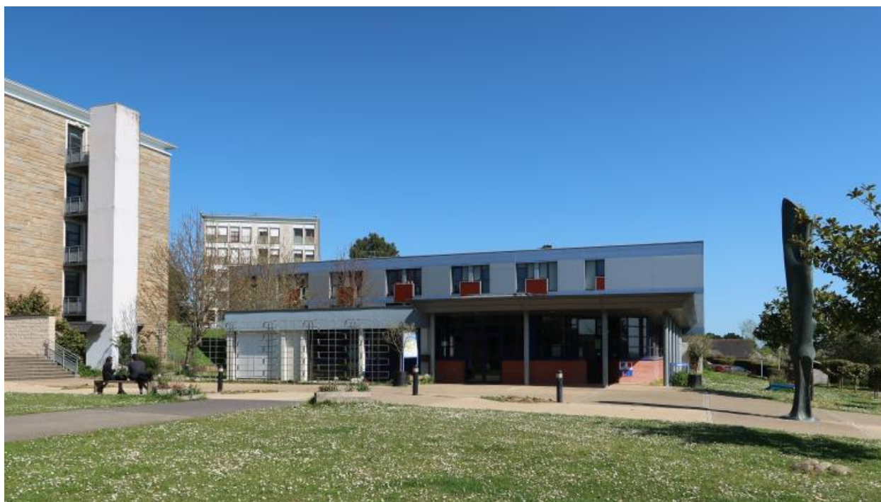
Le pignon sud du bâtiment C, l'administration et l'œuvre du 1% artistique du sculpteur cubain Augustin Cardenas.
