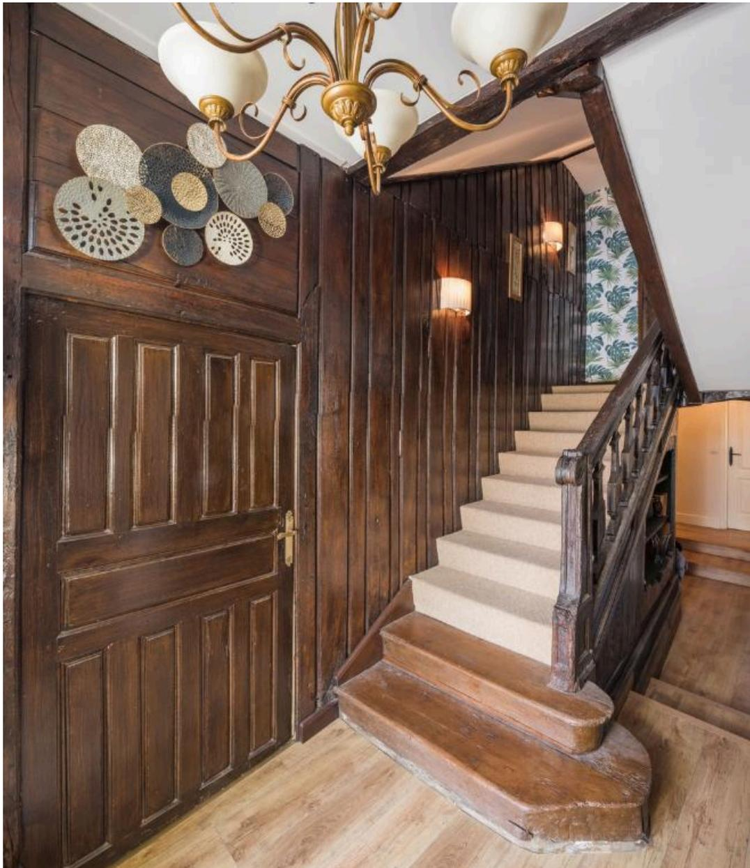
Logis. Vestibule d'entrée avec l'escalier tournant à retours construit entre le mur de refend et une cloison en menuiserie.
