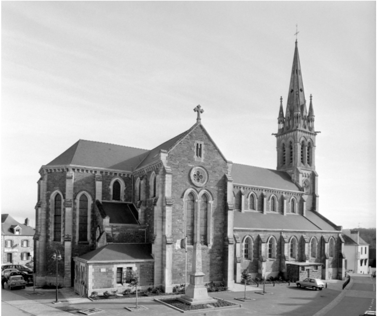
Elévation Ouest : vue générale
