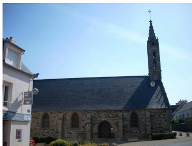
Lanvéoc, église paroissiale : vue générale nord-ouest Phot. Gwénaél Fauchille IVR53_20082905816NUCA
