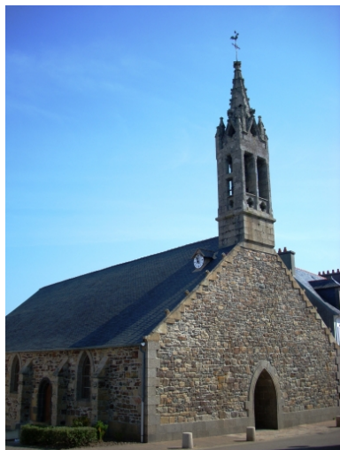
Lanvéoc, église paroissiale : vue générale nord-ouest Phot. Gwénaél Fauchille IVR53_20082905815NUCA
