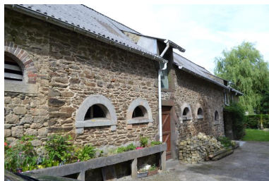
Blanchisserie du Leck. Vue sud-ouest IVR53_20185905911NUCA
