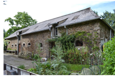
Blanchisserie du Leck. Vue générale sud-est IVR53_20185905910NUCA
