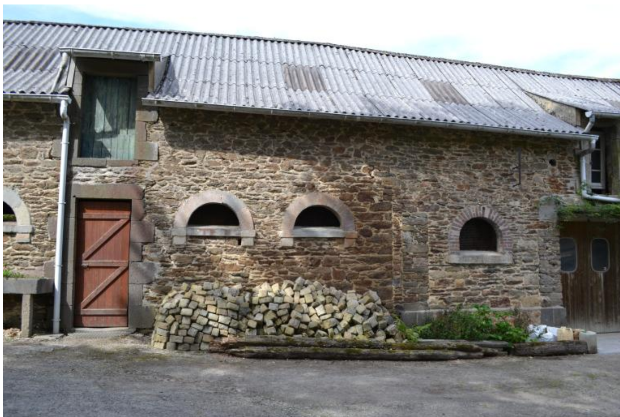
Blanchisserie du Leck. Façade sud. Détail
