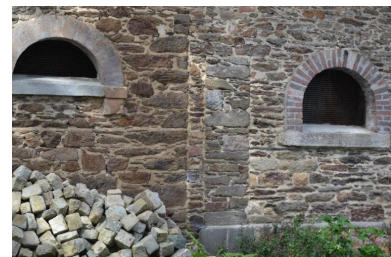
Blanchisserie du Leck. Façade sud. Détail d'un pilier englobé dans la maçonnerie IVR53_20185905913NUCA
