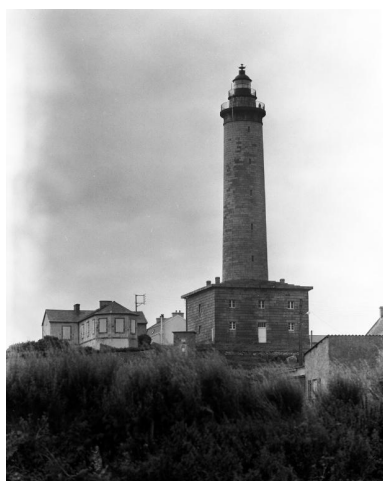
Vue de situation (état en 1986)
