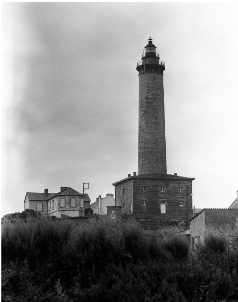
Vue de situation (état en 1986)
