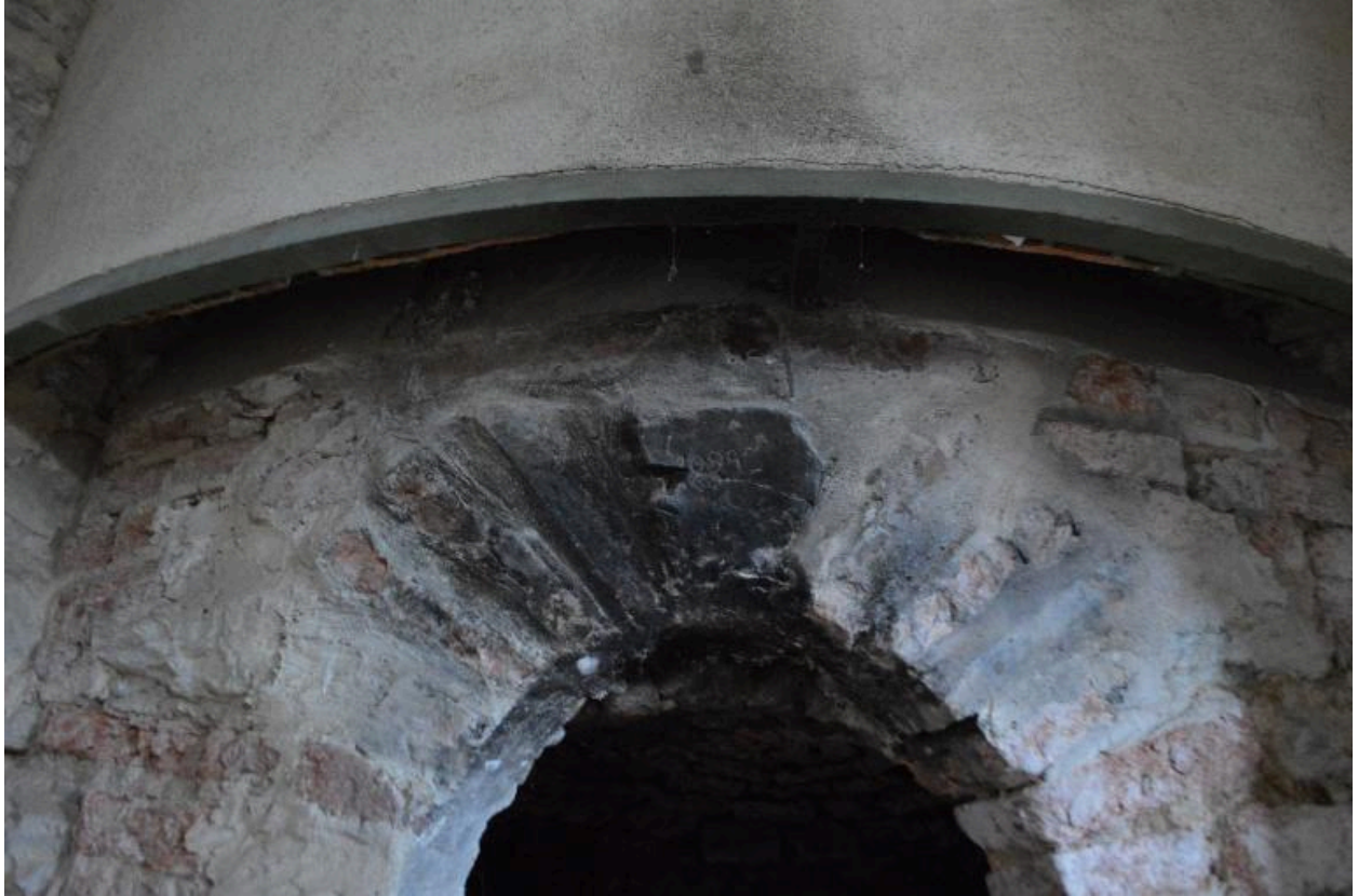
Détail d'un four à pain au sous-sol
