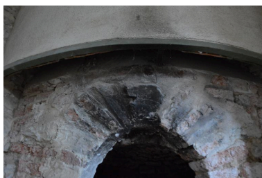
Détail d'un four à pain au sous-sol Phot. Maïlys Provost IVR53_20183505967NUCA
