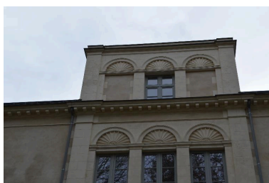
Détail de la façade nord Phot. Maïlys Provost
