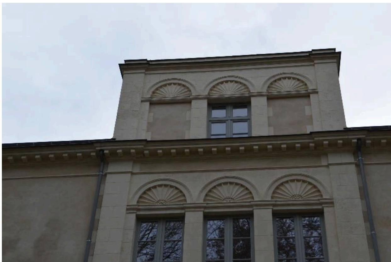
Détail de la façade nord
