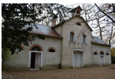
Grand Domaine, anciennes écuries Phot. Maïlys Provost IVR53_20183505960NUCA
