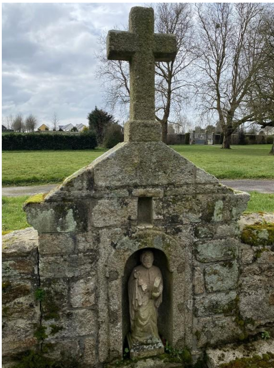
Vue détaillée, façade est
