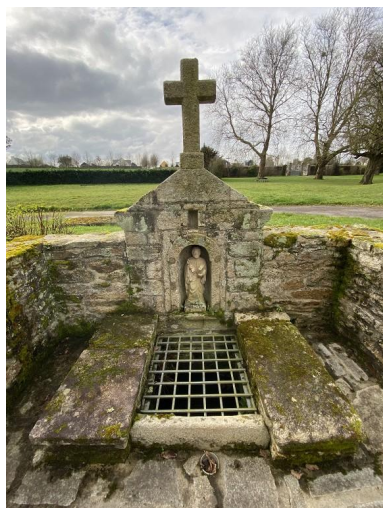
Vue est Phot. Baptiste Oligo IVR53_20255610673NUCA
