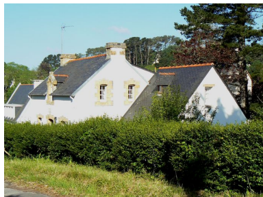
Vue générale de la villa Les Sapins Phot. Johan Vincent IVR53_20072908609NUCA
